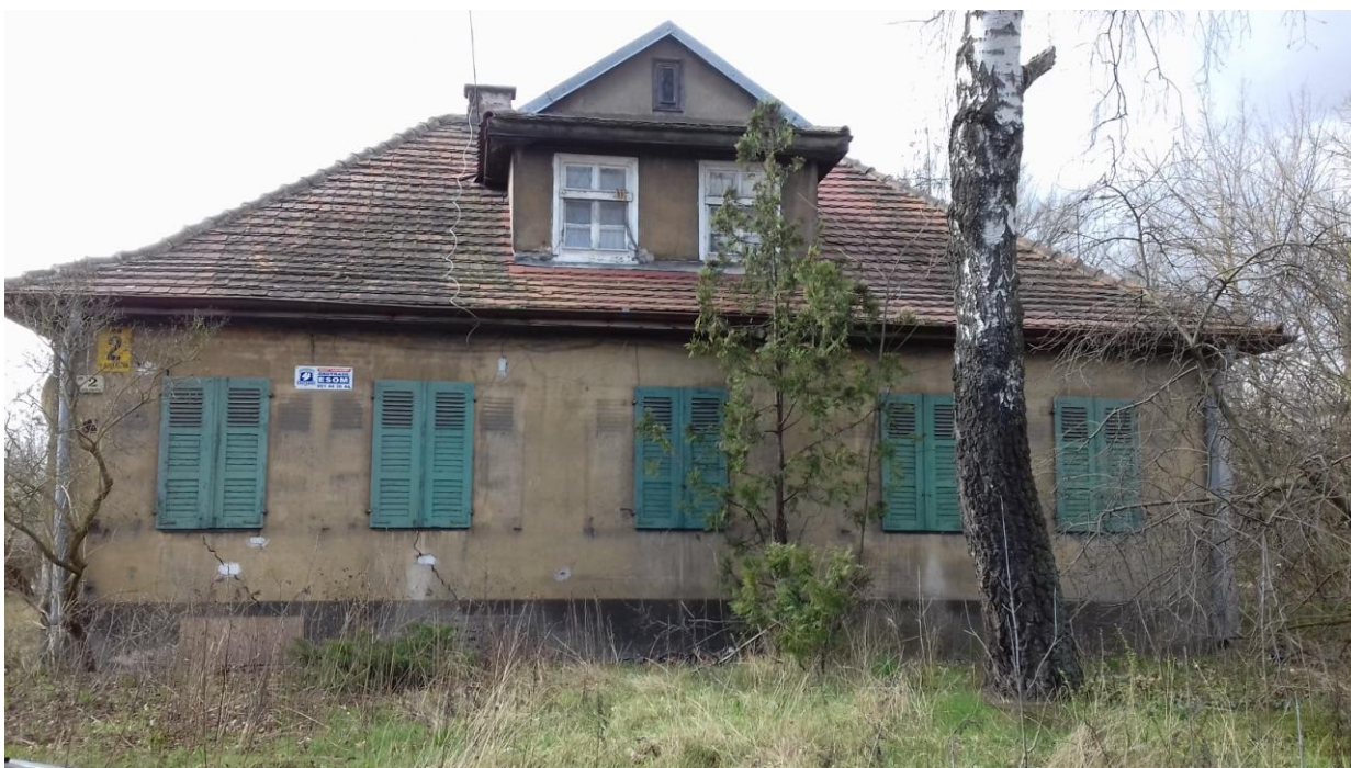
Fot.3 Elewacja tylna budynku mieszkalnego
