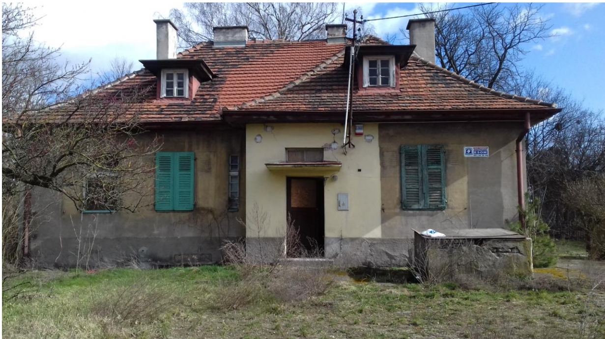
Fot.1 Elewacja frontowa budynku mieszkalnego
