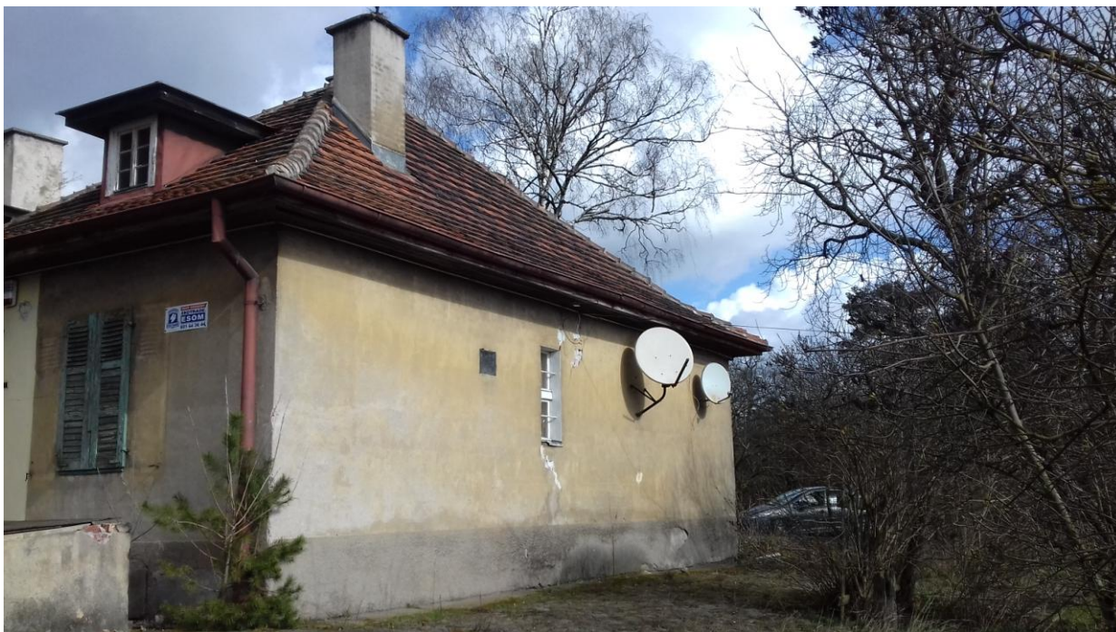
Fot.2 Elewacja boczna budynku mieszkalnego
