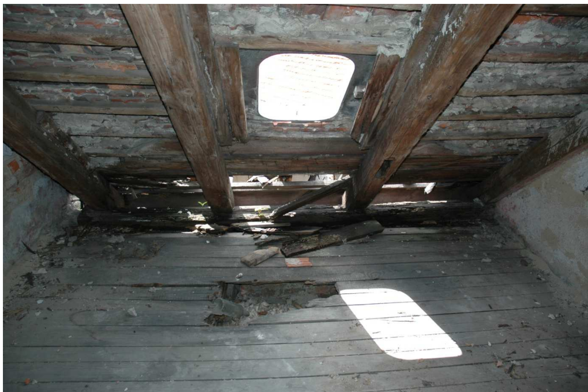
Rys. 3. Widoczne ubytki pokrycia dachowego
