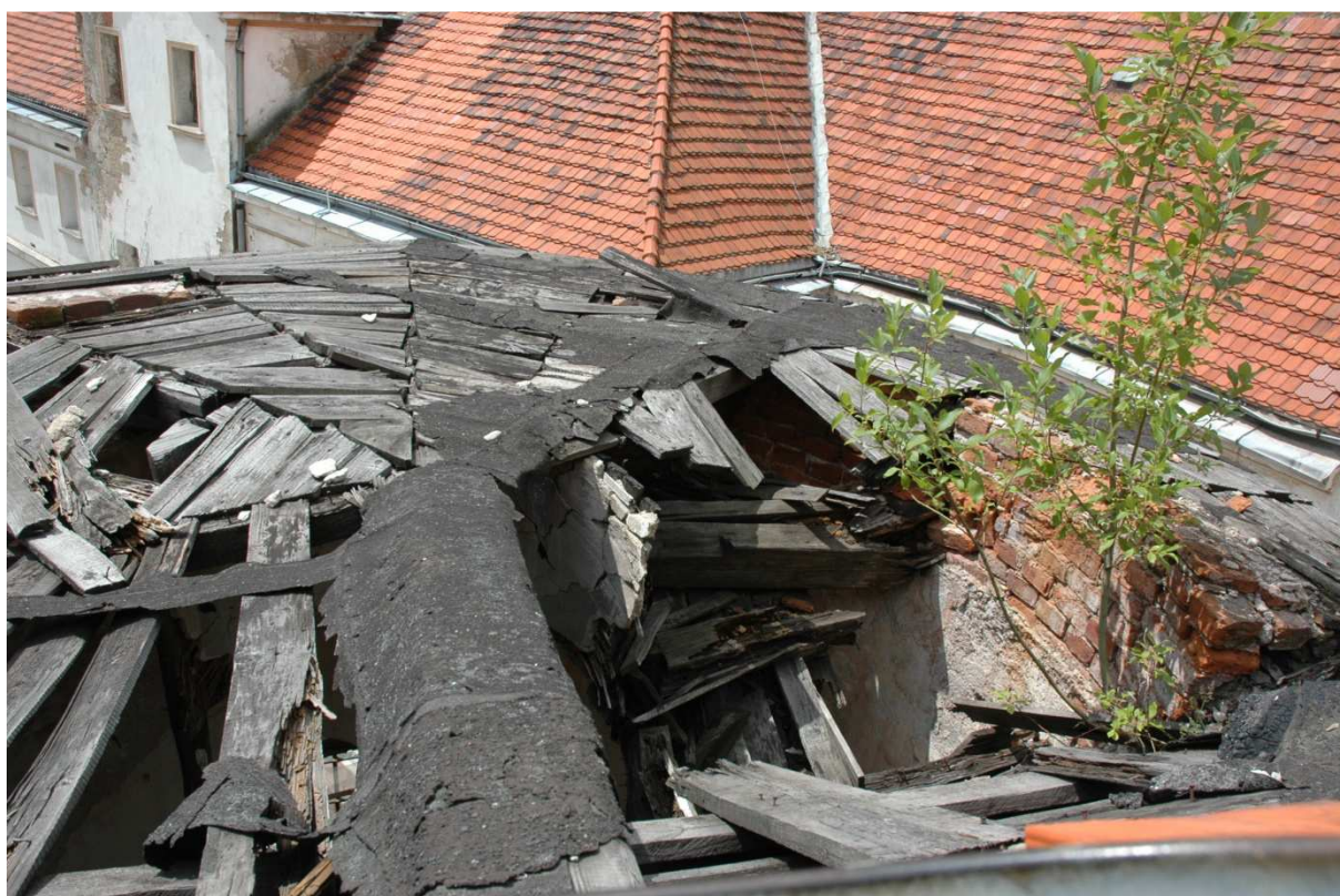
Rys. 1. Zniszczona więźba nad klatką schodową.
