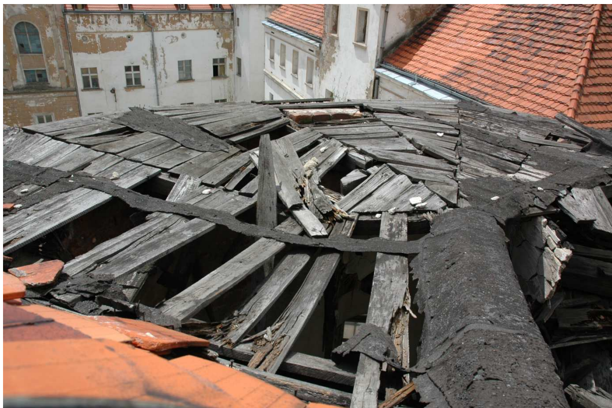
Rys. 1. Zniszczona więźba nad klatką schodową.
