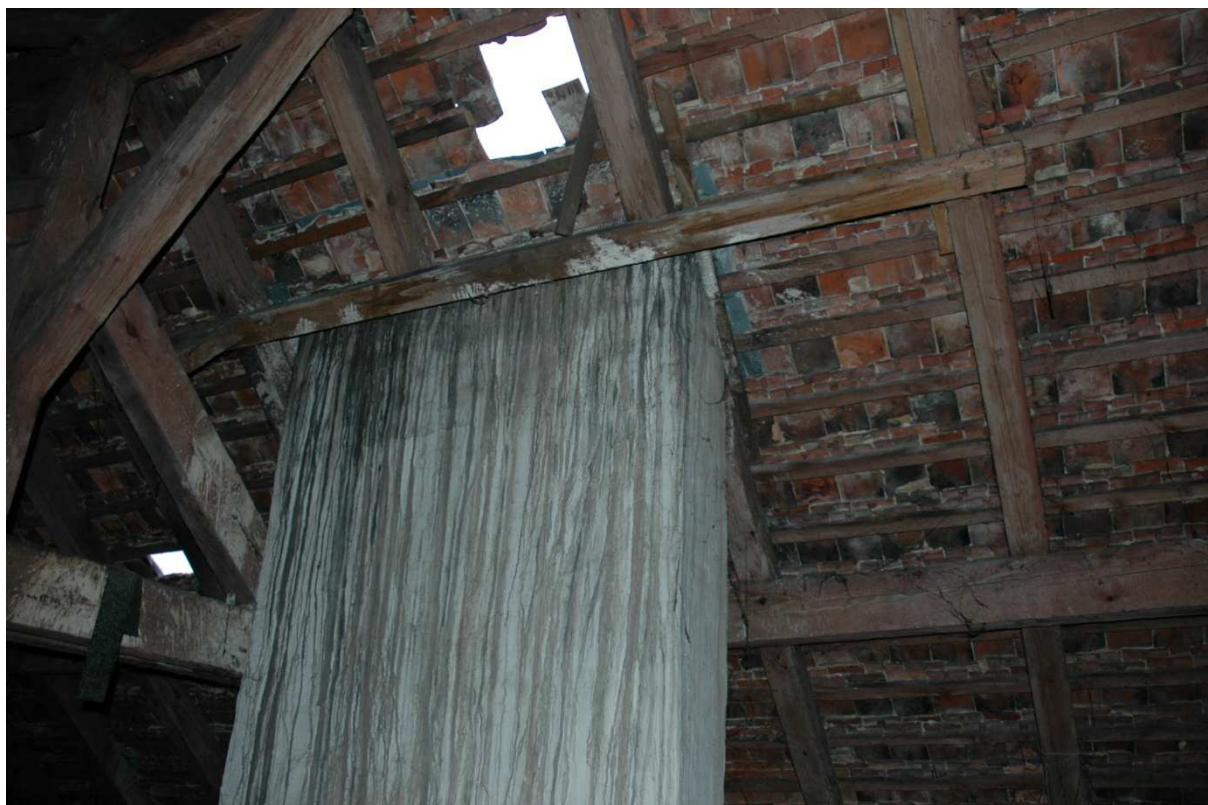
Rys. 5. Widoczne ubytki pokrycia dachowego.
