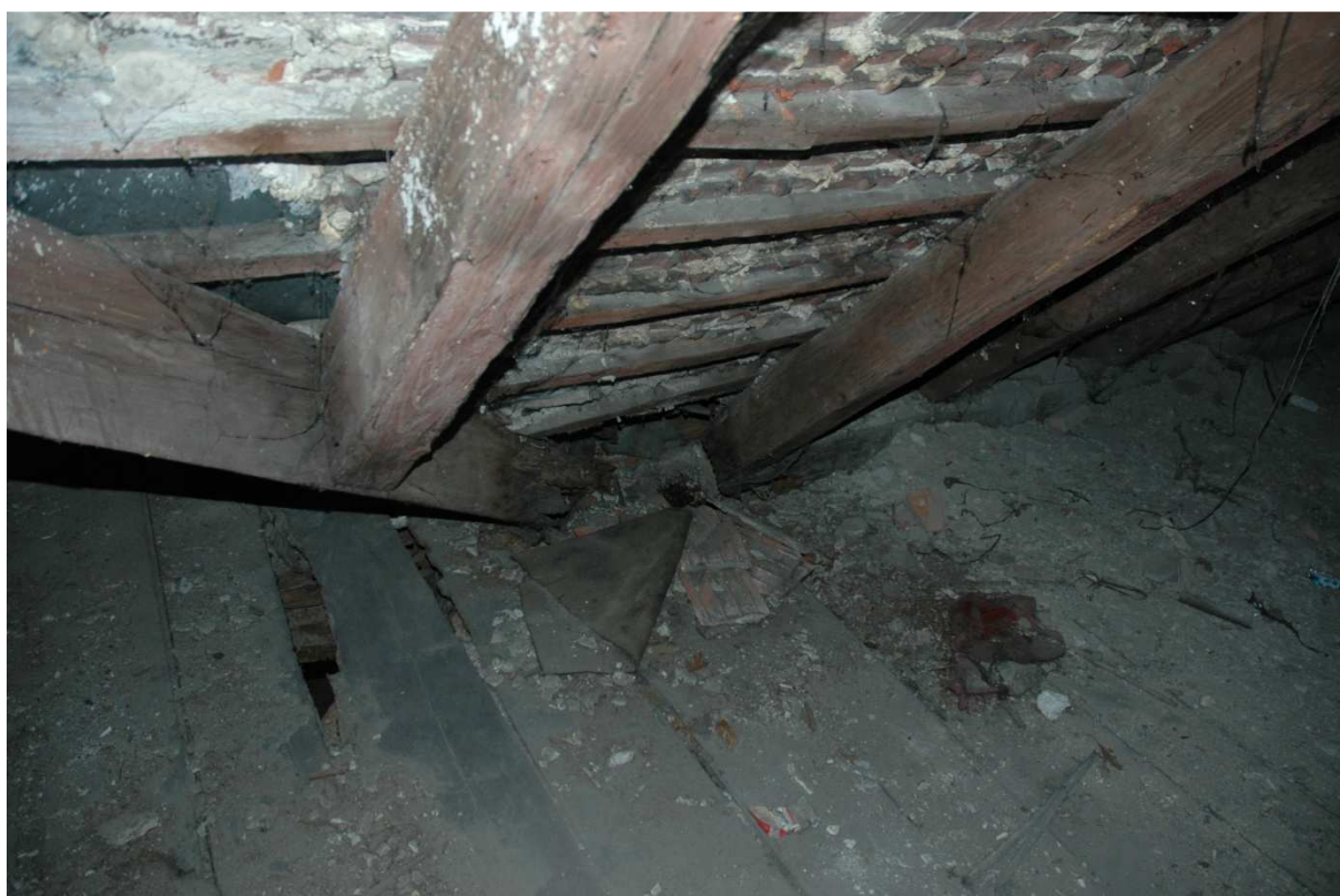
Rys. 6. Widoczna przegnita krokwia koszowa i murłata.
