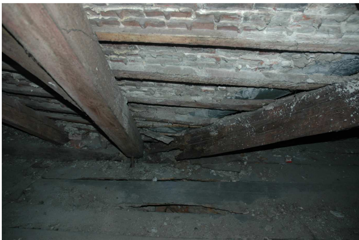
Rys. 4. Widoczna zniszczona krokiew koszowa.
