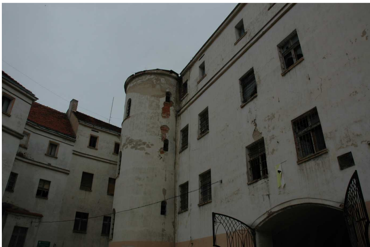
Rys. 8. Widoczne zawilgocenie ścian spowodowane brakiem obróbek blacharskich.
