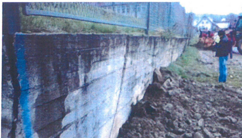
Fot.2 Uszkodzony fragment muru oporowego wzdłuż drogi powiatowej.
