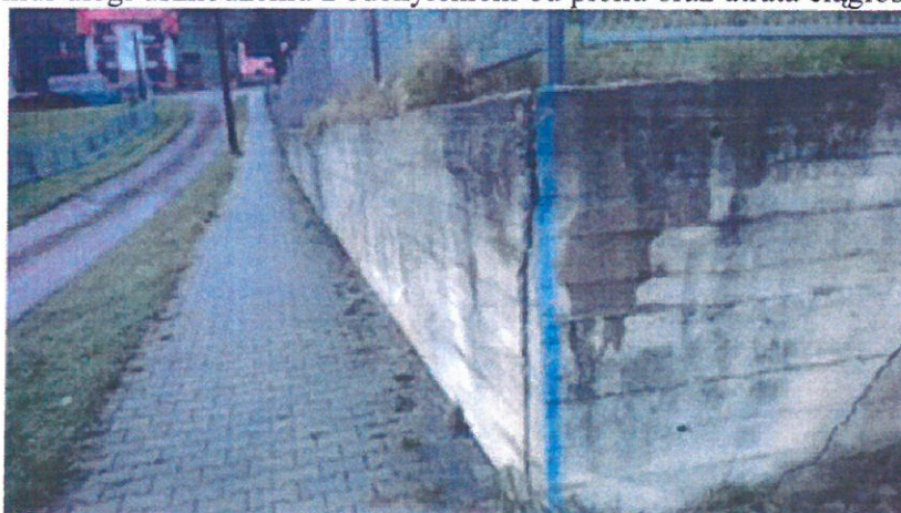
Fot.1 Uszkodzony narożnik muru oporowego
