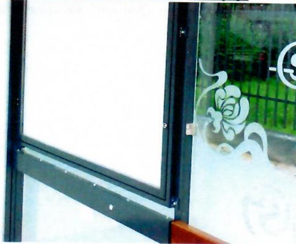
Kształt i miejsce umieszczenia listwy SOS w wiatkach zainstalowanych w Płocku w 2014r.
