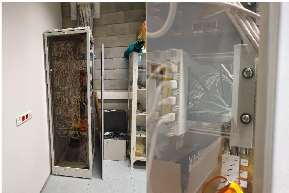
Rys. Istniejąca piętrowa szafa RACK – standard wykonania / przykład
