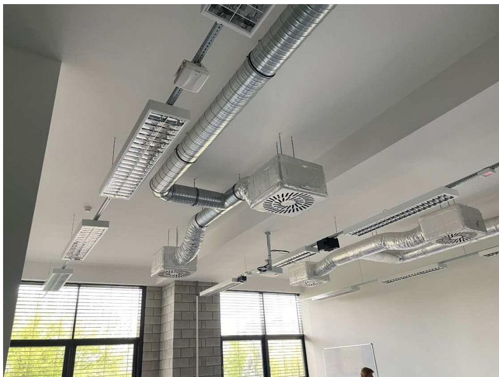
Rys. Istniejąca instalacja oświetleniowa – stan aktualny
