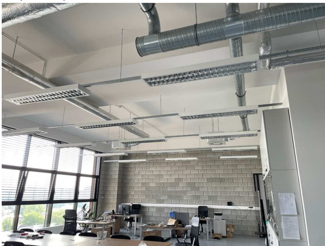
Rys. Istniejące oprawy oświetleniowe w pom. 419/420 (do demontażu) zainstalowane na wspornikach/profilach
