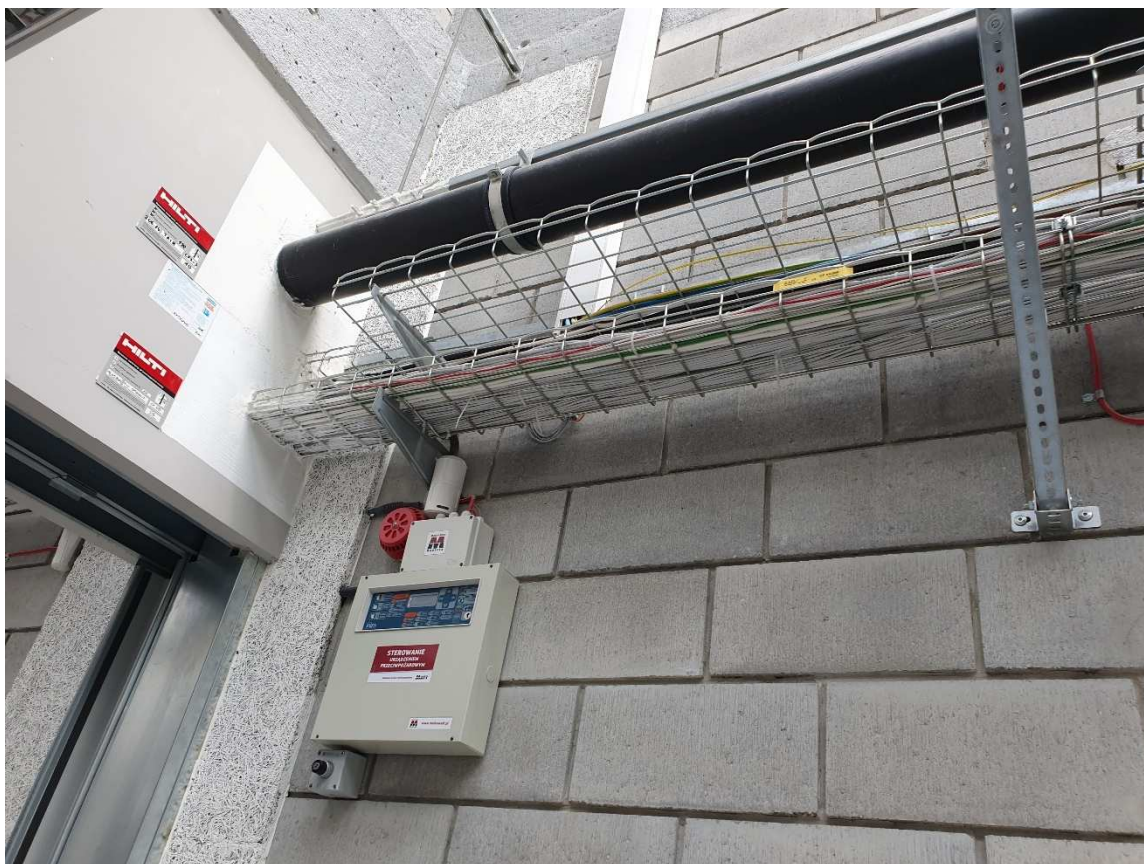
Rys. Istniejące koryta kablowe oraz przejścia ppoż. – standard wykonania / przykład
