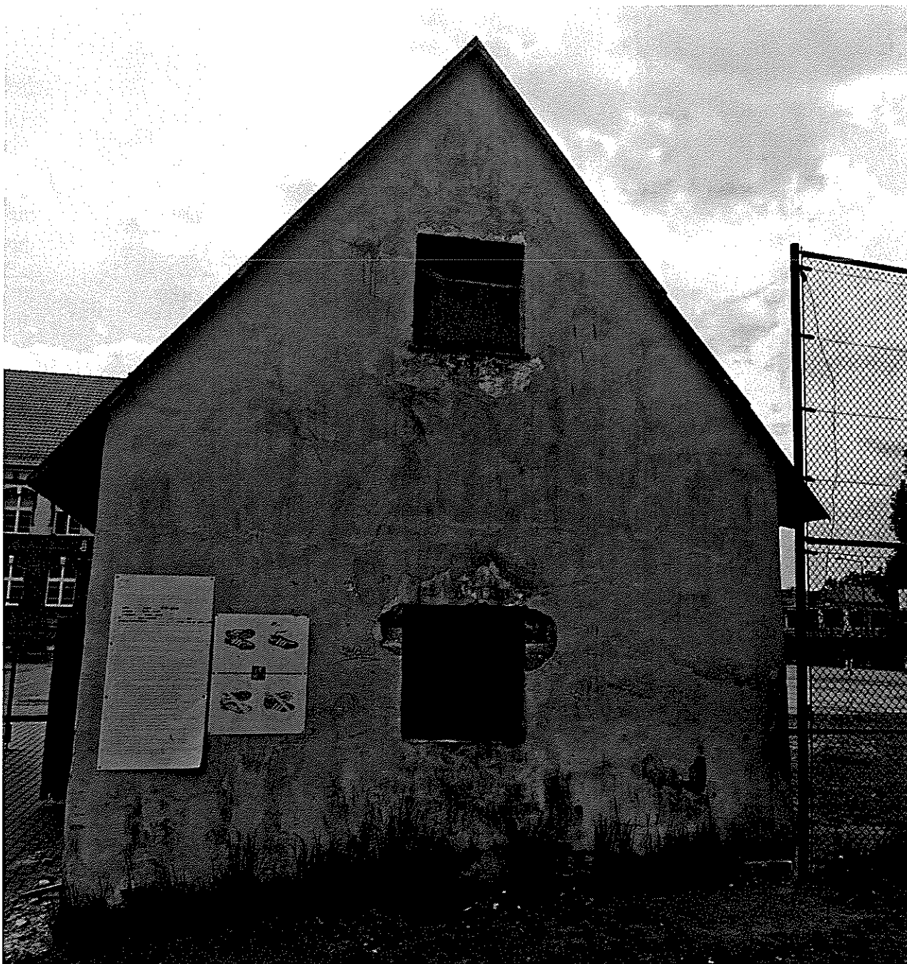
FOT. F-4. ELEWACJA (PÓŁNOCNA)
