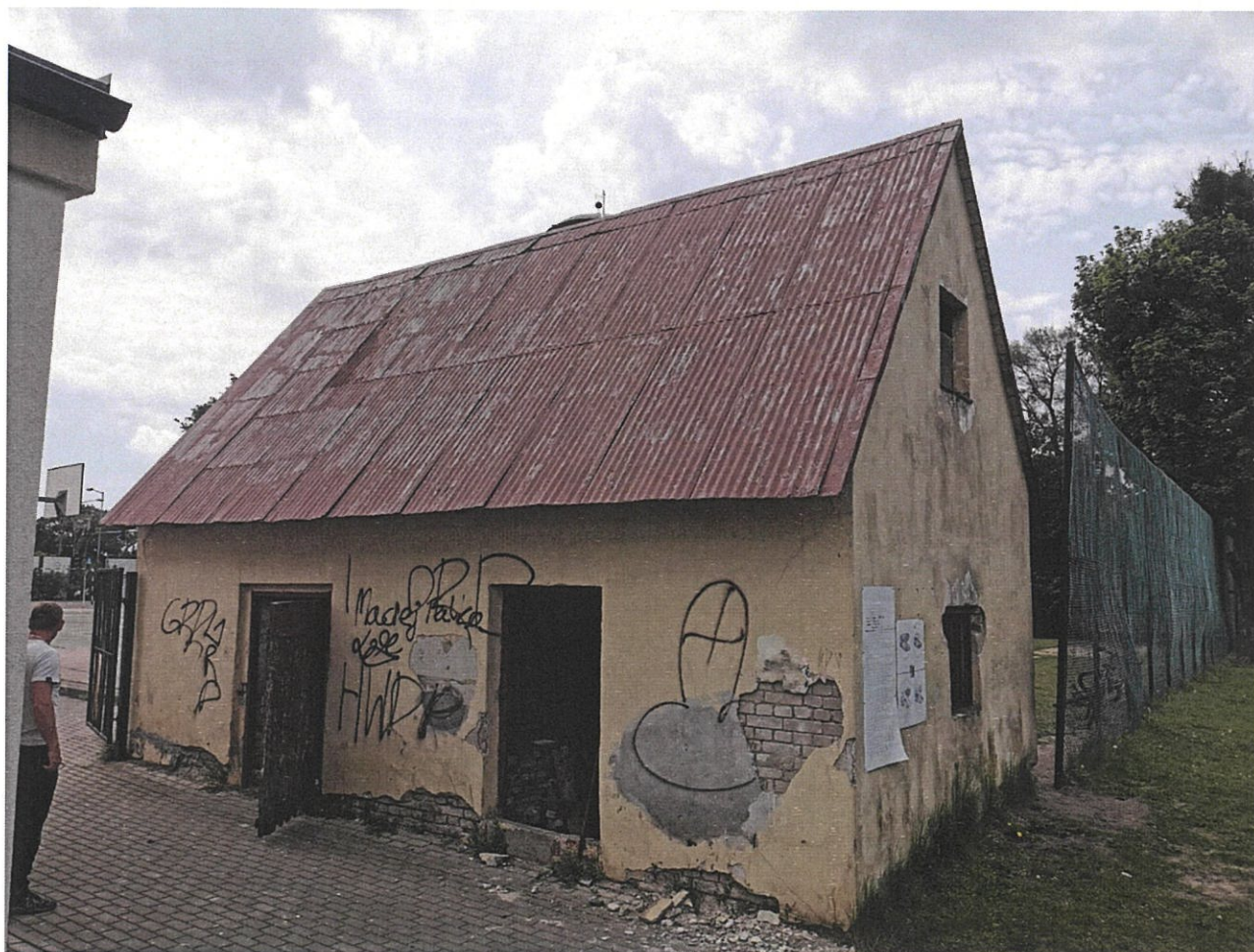
FOT. F-3. ELEWACJA (WSCHODNIA)
