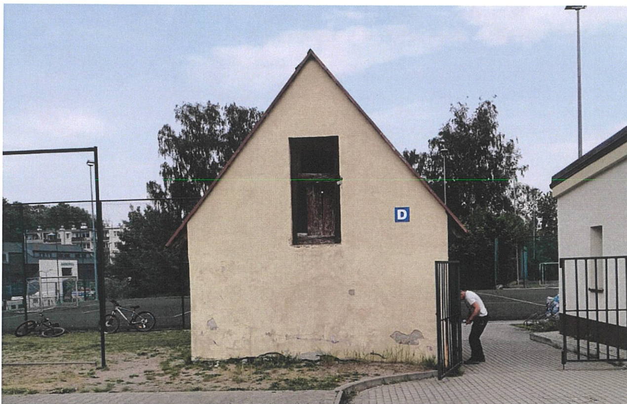
FOT. F-2. ELEWACJA (POŁUDNIOWA)
