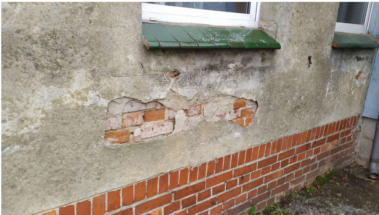
FOT. NR 5. BUDYNEK MIESZKALNY, ZBLIŻENIE ELEWACJI – WIDOCZNE UBYTKI I ODSPOJENIA ISTNIEJĄCEGO TYNKU
