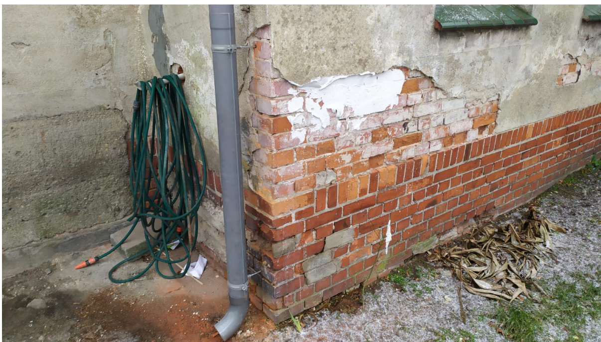
FOT. NR 6. BUDYNEK MIESZKALNY, ZBLIŻENIE PARTI COKŁOWEJ ELEWACJI – WIDOCZNE UBYTKI I ODSPOJENIA ISTNIEJĄCEGO TYNKU ORAZ ZAGRZYBIENIE TYNKU I COKŁU Z CEGŁY
