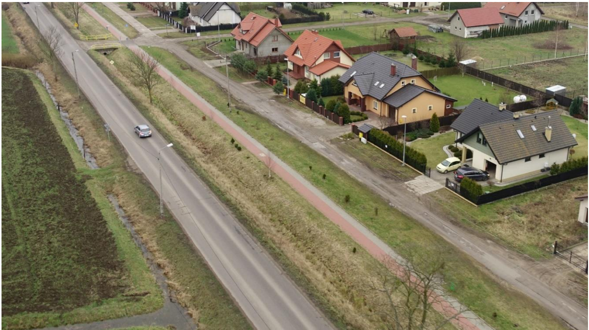
Rys. 7.2.5 Przykład usytuowanie drogi dla pieszych i rowerów wzdłuż drogi zamiejscowej poza rowem i poza strefą bezpieczeństwa
