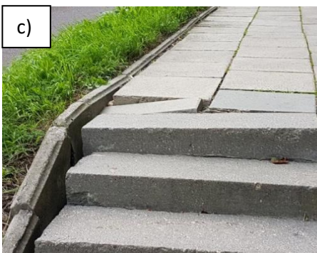
Rys. 16.2.1 Przykład zidentyfikowanych na podstawie inspekcji deficytów infrastruktury liniowej dla pieszych: a) słupy w pasie ruchu dla pieszych, b) zieleń zajmująca znaczną część pasa ruchu dla pieszych, c) uszkodzone schody, d) obniżenia chodnika sprzyjające tworzeniu się kałuż.
