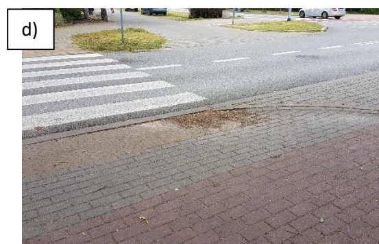
Rys. 16.2.1 Przykład zidentyfikowanych na podstawie inspekcji deficytów infrastruktury liniowej dla pieszych: a) słupy w pasie ruchu dla pieszych, b) zieleń zajmująca znaczną część pasa ruchu dla pieszych, c) uszkodzone schody, d) obniżenia chodnika sprzyjające tworzeniu się kałuż.
