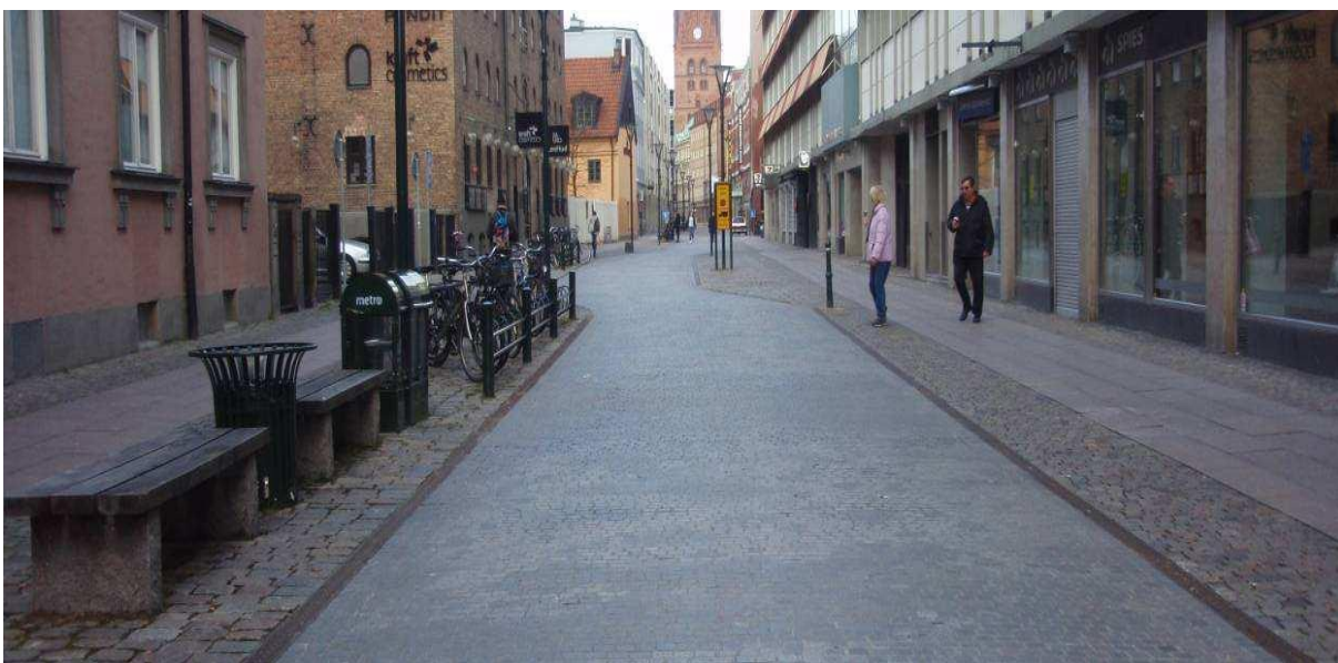
Rys. 8.5.2. Wyróżnione kolorem i fakturą nawierzchni pasy użytkowe jezdni i chodnika
