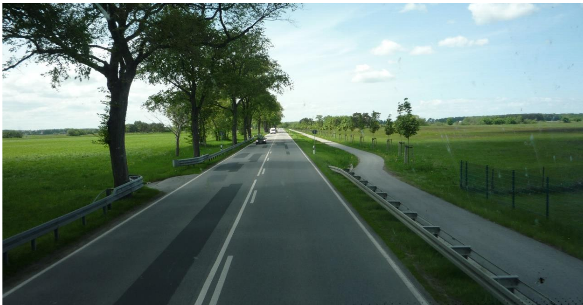
Rys. 7.2.7 Przykład usytuowania drogi dla pieszych i rowerów poza rowem i poza barierą drogową.
