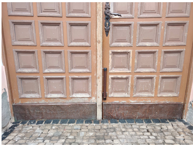
2. Widok ubytków w zewnętrznej stronie drzwi wejściowych.
