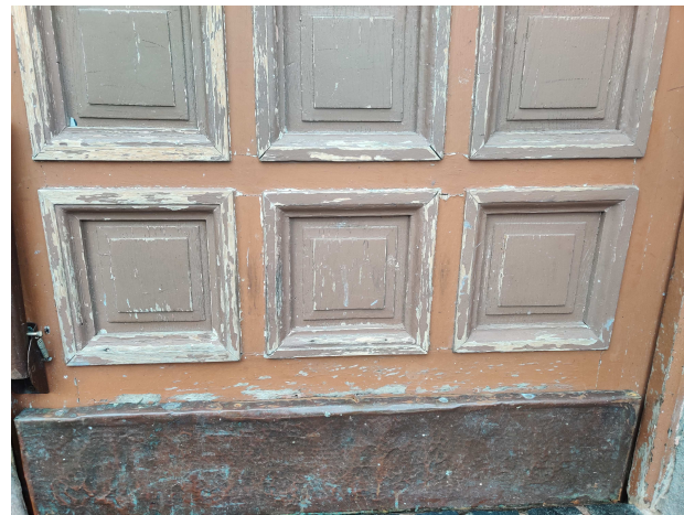
2. Widok ubytków w zewnętrznej stronie drzwi wejściowych.
