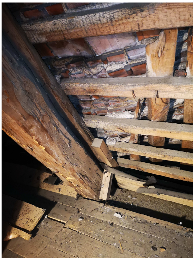
Fot. 4 – widoczne ślady uszkodzeń krokwi poddasza nieużytkowego
