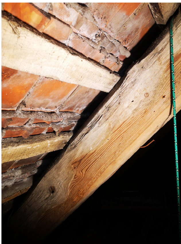
Fot. 6 – widoczne ślady zawilgoceń krokwi poddasza nieużytkowego
