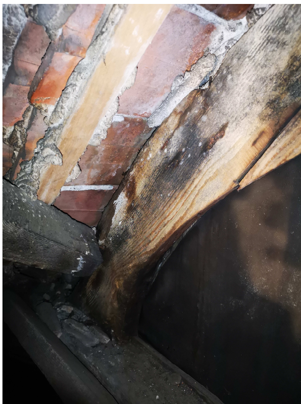
Fot. 3 – widoczne ślady zawilgoceń przy otworach okiennych poddasza nieużytkowego
