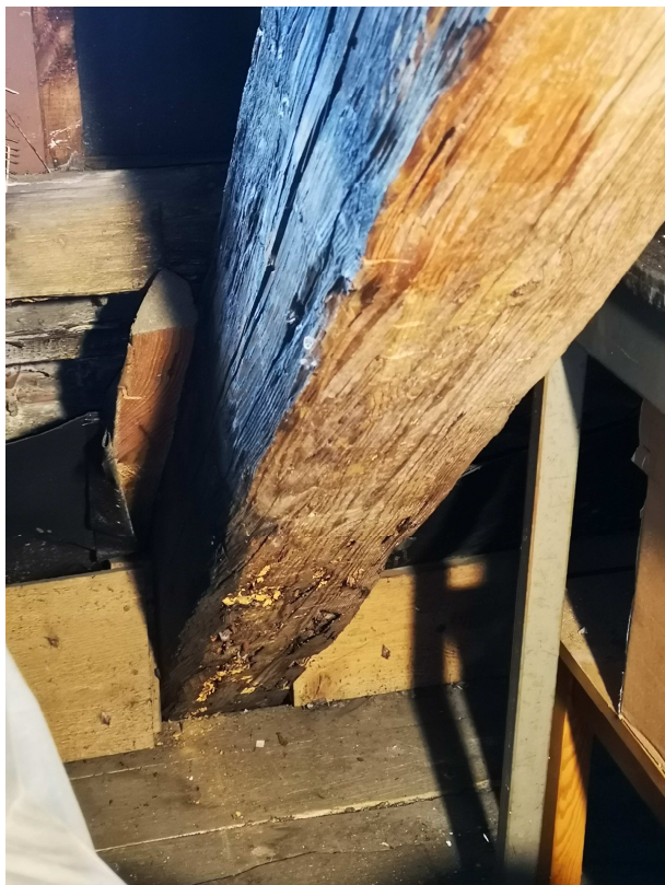
Fot. 5 – widoczne ślady uszkodzeń krokwi poddasza nieużytkowego
