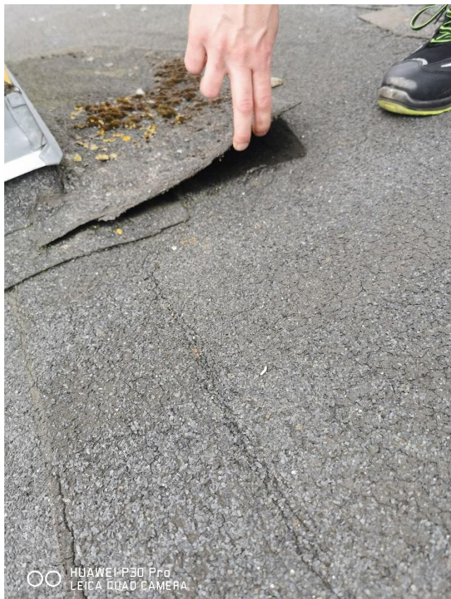
Uszkodzenia poszycia
