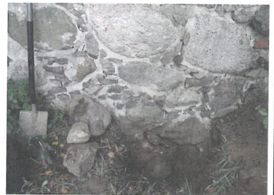
Fot. 4 Zakres odkrywki „1”
