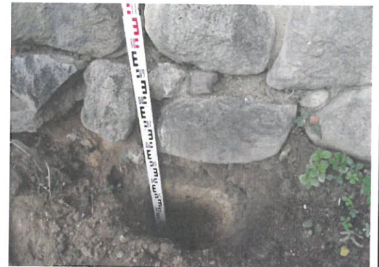
Fot. 4 Zakres odkrywki „2”
