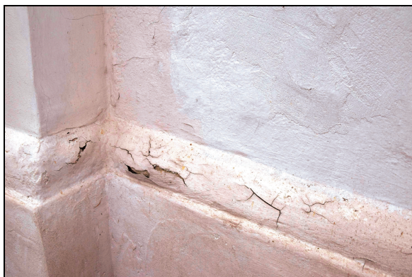
Wyraźnie spękane tynki
