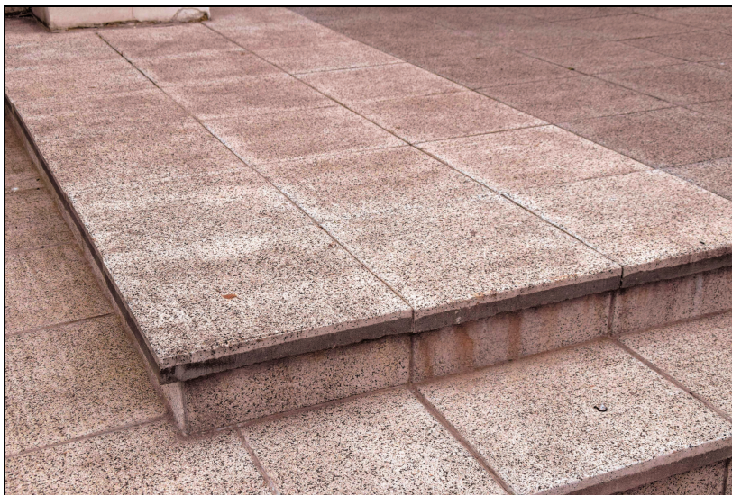
Schody przed wejściem z betonowych płytek
