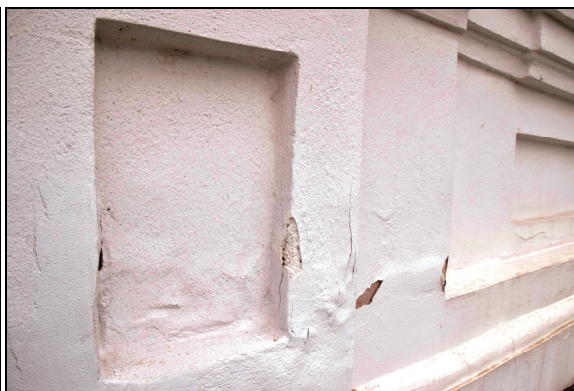
Wyraźnie spękane tynki
