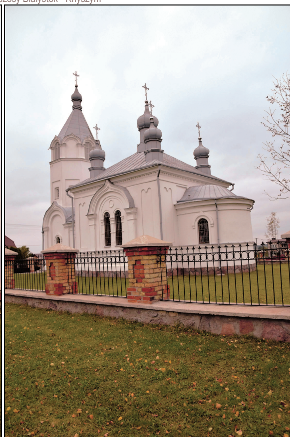
Widok od strony południowej
