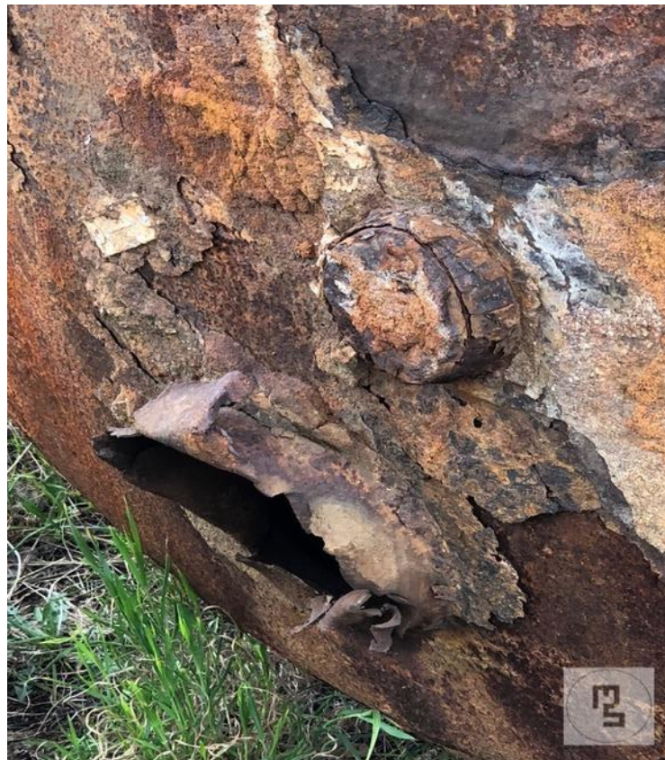
Fot. 7 Stan zachowania
