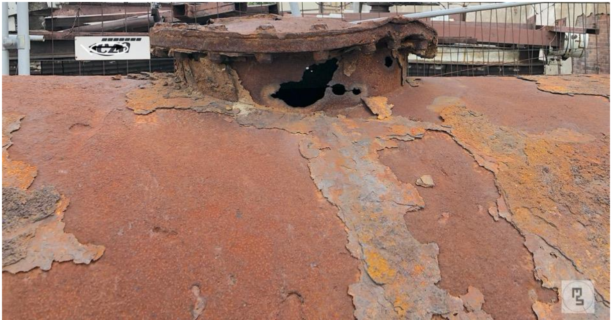
Fot. 8 Stan zachowania
