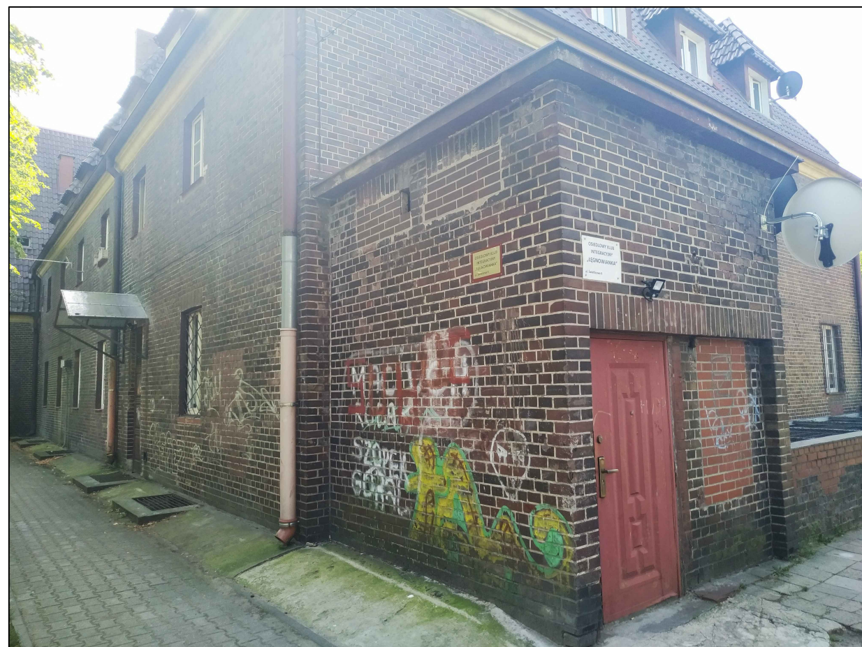
elewacja od strony północno-zachodni - widok fotografia
