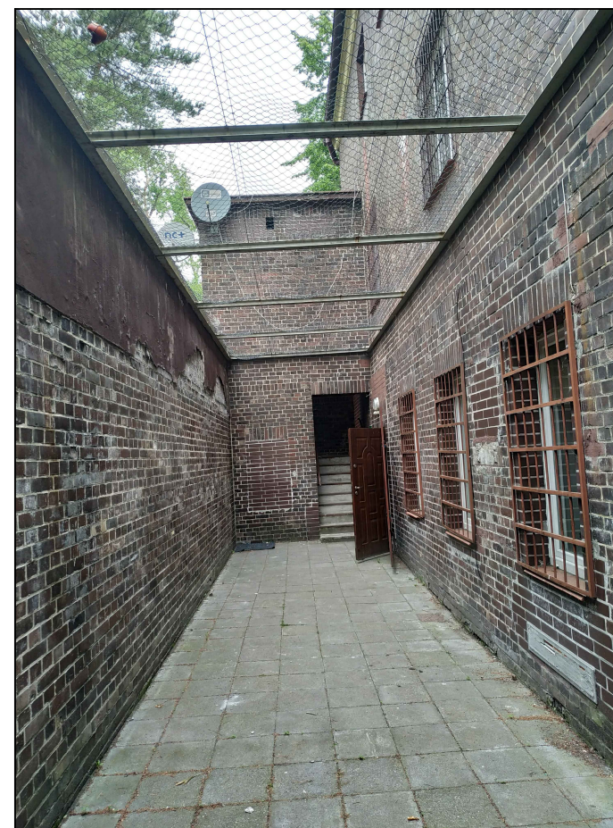
elewacja południowo-zachodnia - widok od strony naświetla fotografia
