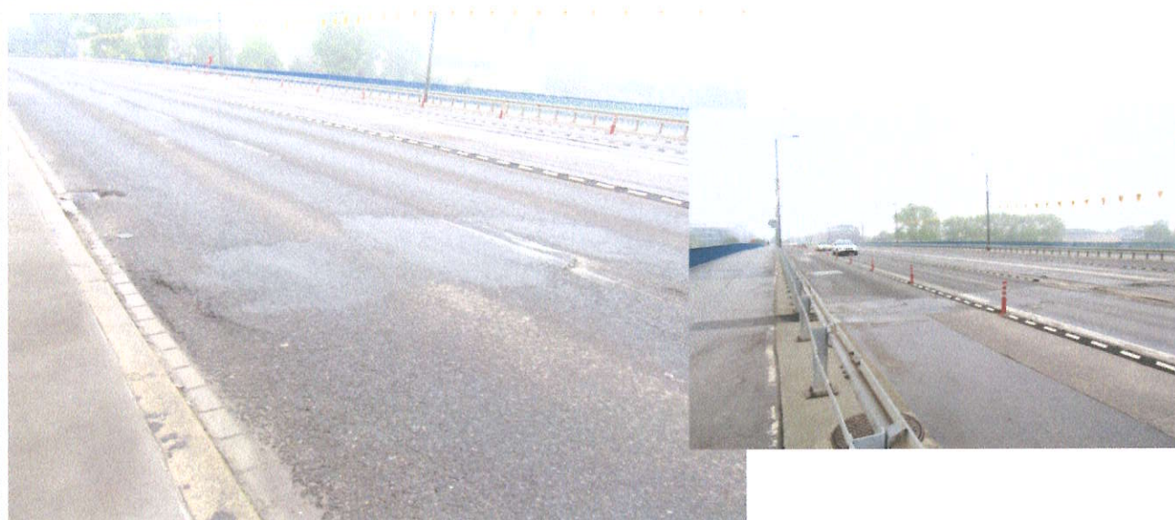
FOT. 2.2. WIDOK NAWIERZCHNI CHODNIKA
