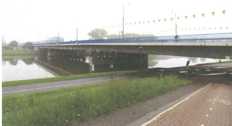
FOT. 1.2. WIDOK OBIEKTU Z BOKU - od strony GW
