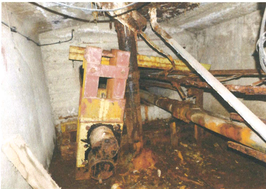
FOT. 8.1 WIDOK RAMY BLOKU ZAKOTWIENIA CIĘGIEN SPRĘŻAJĄCYCH SKRZYŃKI NR 1 GW NAD FILAREM OD STRONY RONDA GRUNWALDZKIEGO
