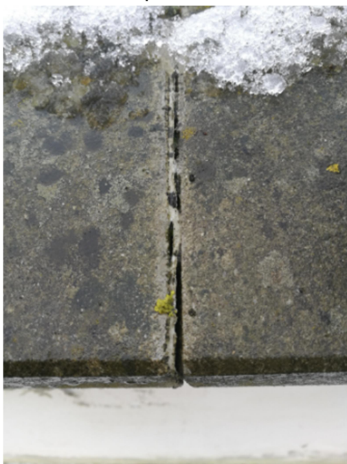
Fot. 9 Uszkodzone spoinowanie
