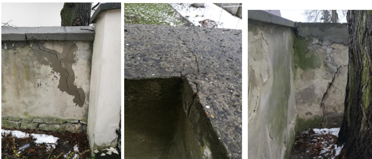
Fot. 8 Uszkodzona struktura muru – strona południowa
