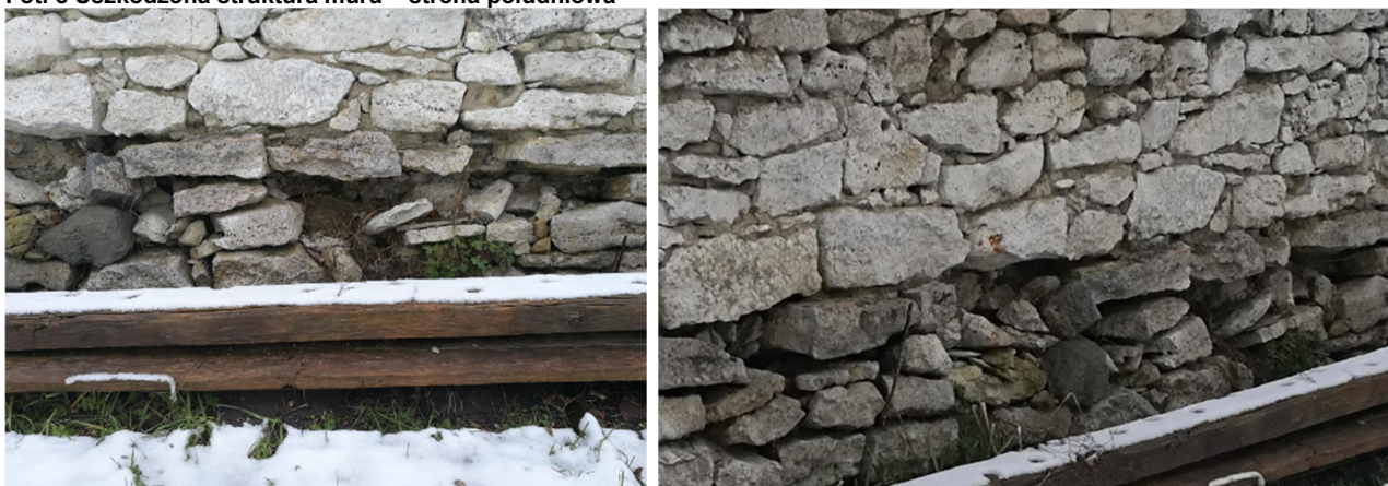
Fot. 8 Uszkodzona struktura muru – strona południowa
