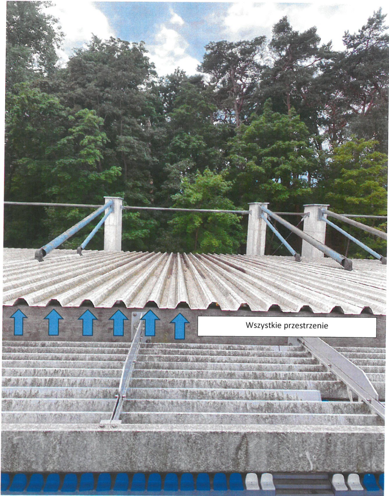
Zdjęcie nr 2 – miejsce obowiązkowej impregnacji przy płatwi tylnej
