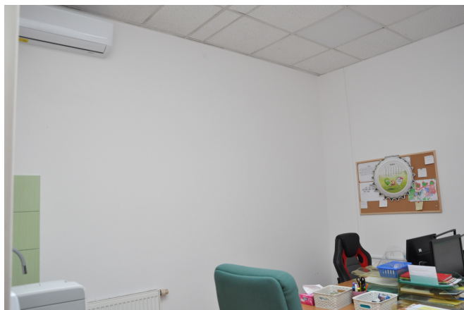
Fot.1.Widok na ścianę wschodnią od wew. pomieszczeni biurowego
