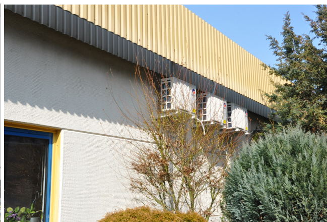
Fot. 2.Ściana wschodnia, miejsce planowanego okna pod klimatyzatorami
