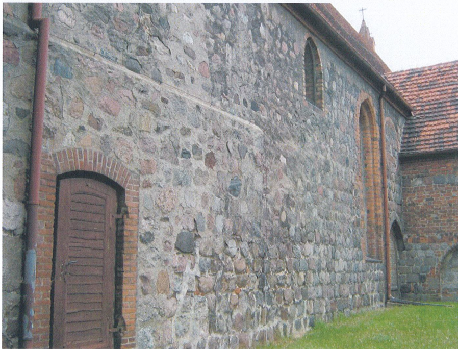
Fot. Elewacja południowa kościoła w Trzciesku- Zdroju. Widoczne pozacieranie muru kamiennego wtórną zaprawą z szarym cementem.
