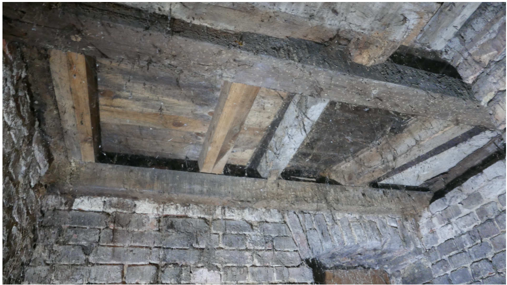
Fot. 9 Uszkodzony podest wejściowy klatki schodowej
