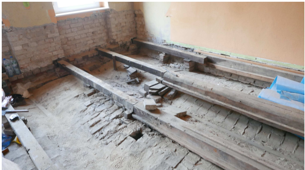
Fot. 14 Odkryty, uszkodzony strop odcinkowy w pom. nr 10 w lokalu nr 1
