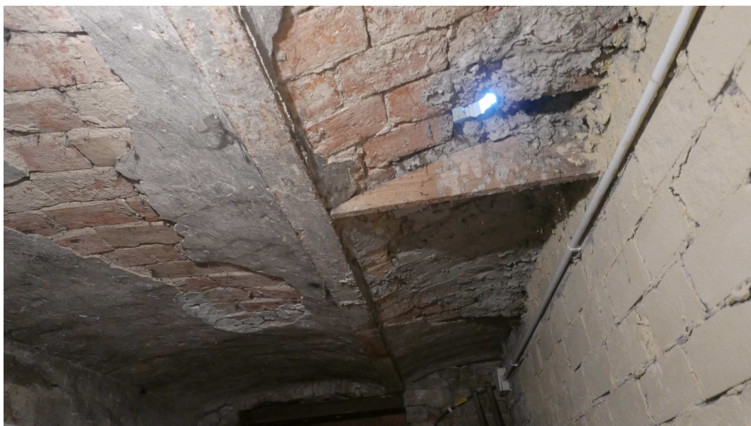
Fot. 4 Strop odcinkowy uszkodzony
