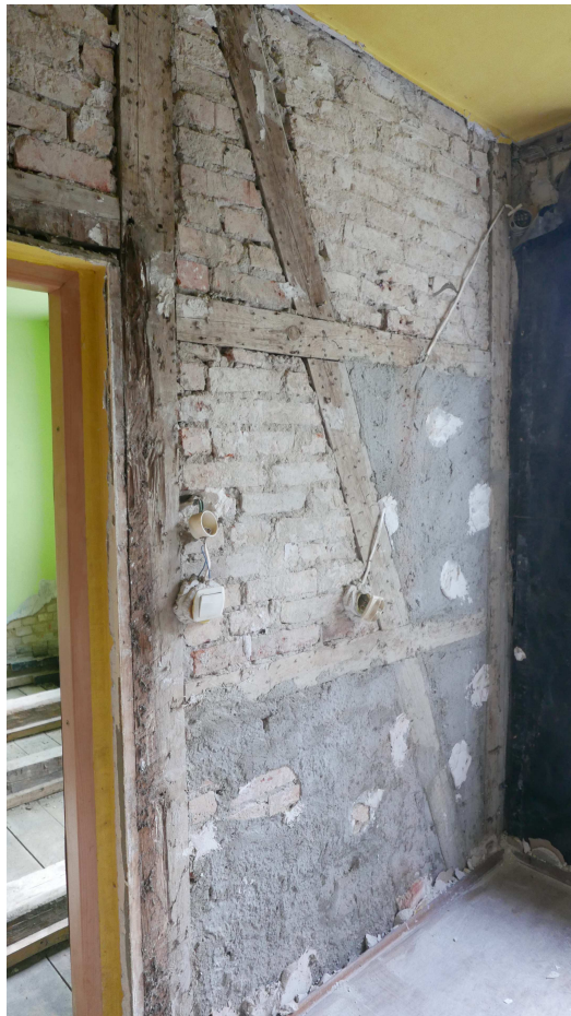
Fot. 11 Ściana ryglowa podłużna budynku
