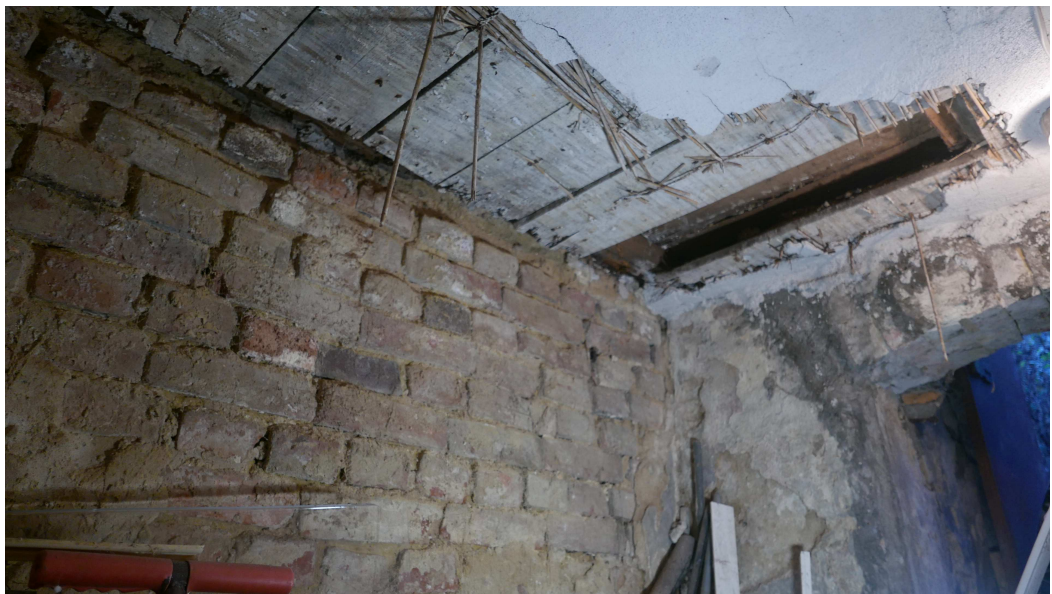
Fot.10 Stan stropów drewnianych do przyszłego remontu kapitalnego
