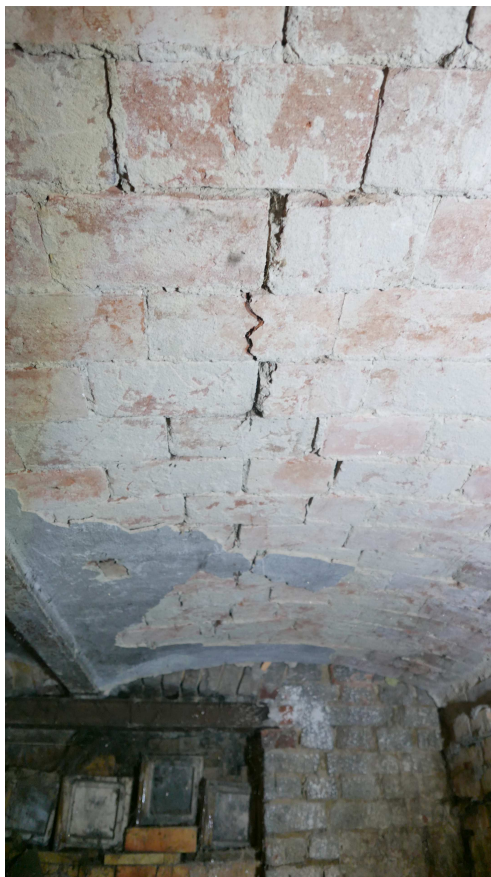
Fot. 6 Strop odcinkowy uszkodzony
