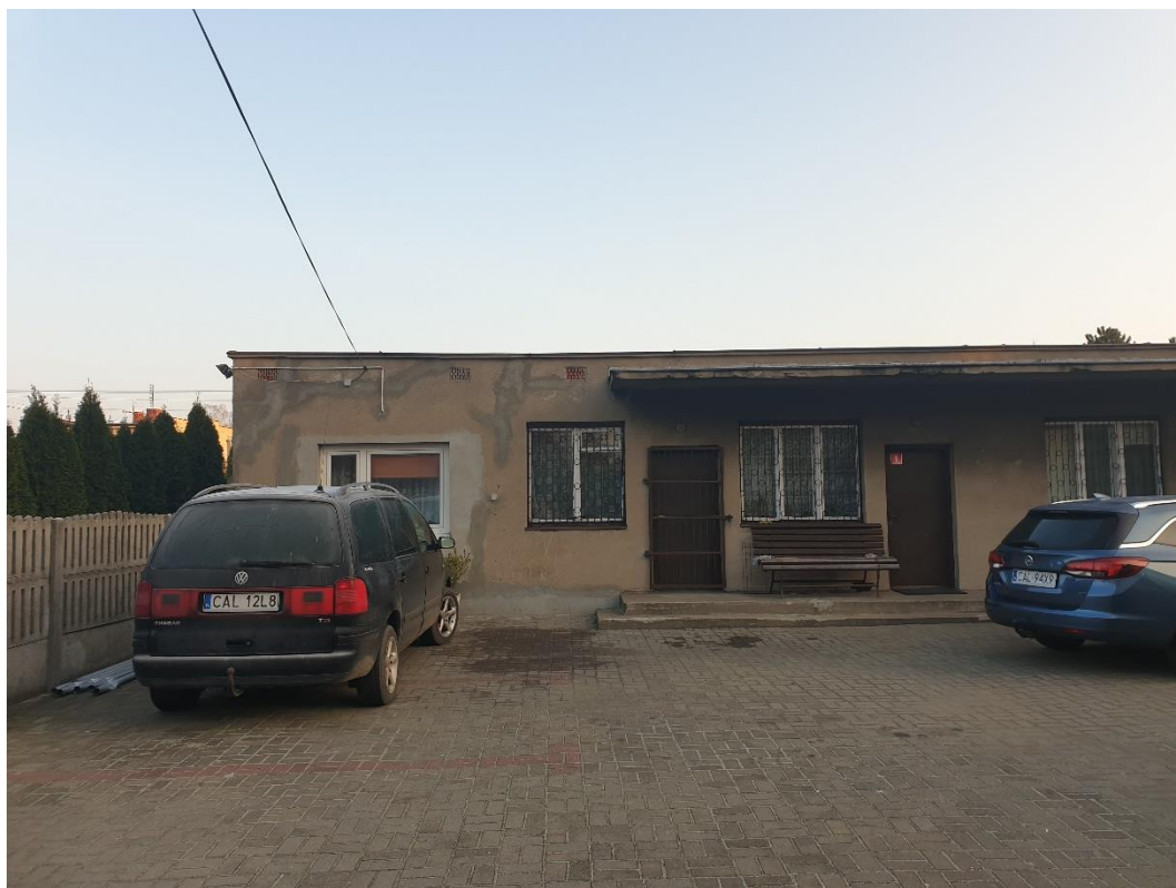
Rys. 2. Elewacja drugiego budynku Urzędu Gminy w Bądkowie – budynek objęty opracowaniem.
