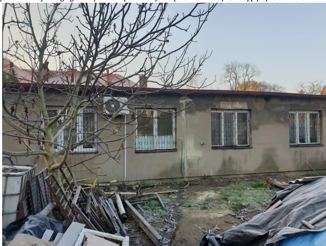
Rys. 3. Elewacja drugiego budynku Urzędu Gminy w Bądkowie – budynek objęty opracowaniem.
