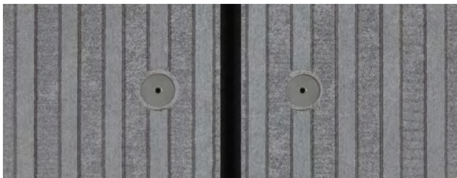
Punkt mocowania na aluminiowej konstrukcji nośnej; mocowanie w osi wybrzuszenia płyty.
