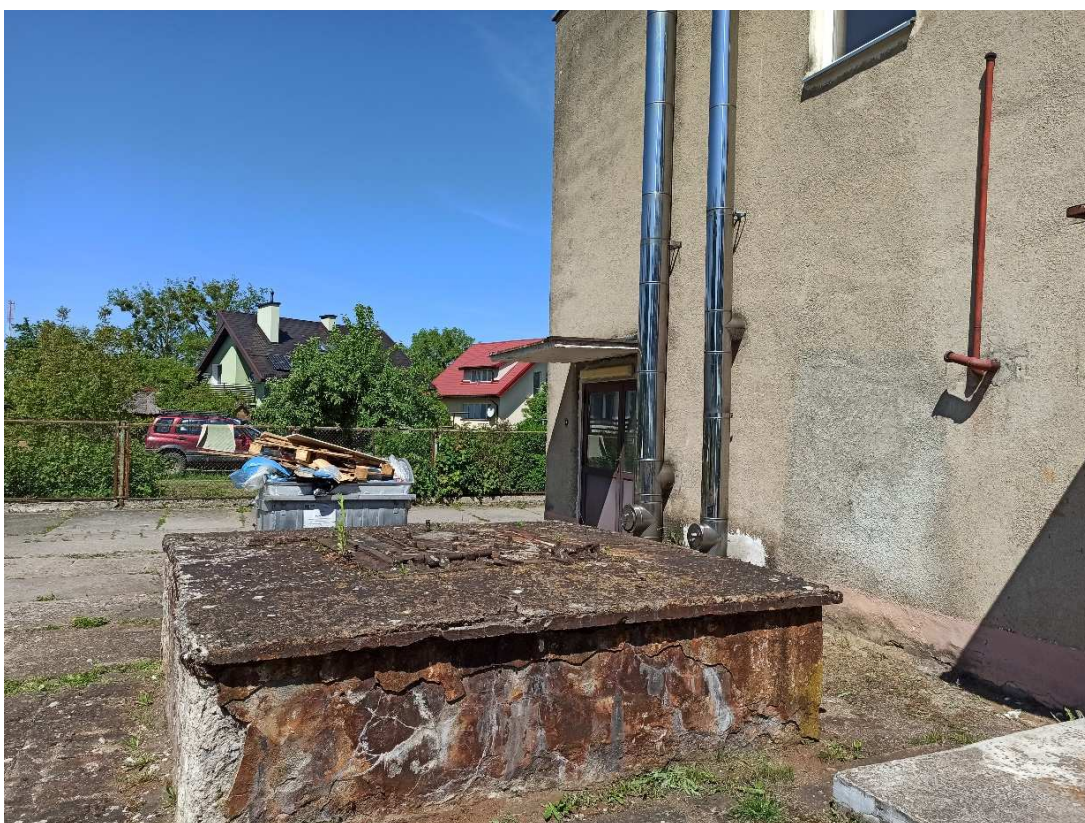
Fotografia nr 4 Widok fundamentu byłego komina przy kotłowni podlegającego rozbiórce – stan istniejący
