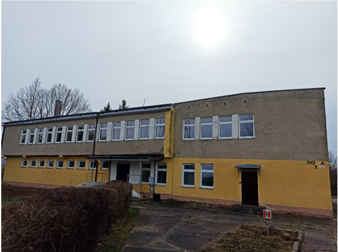
Fotografia nr 1 Widok elewacji frontowej (północnej) – stan istniejący
