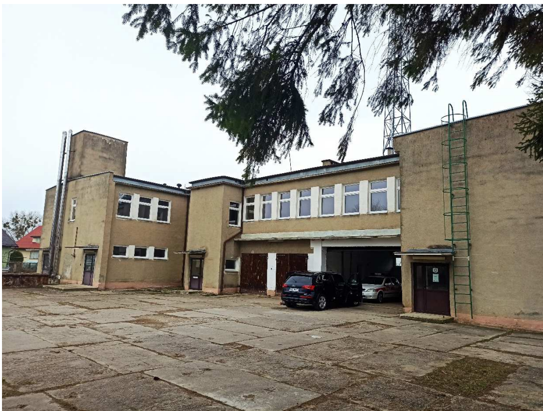
Fotografia nr 3 Widok elewacji tylnej i bocznej (południowo-wschodnia) – stan istniejący
