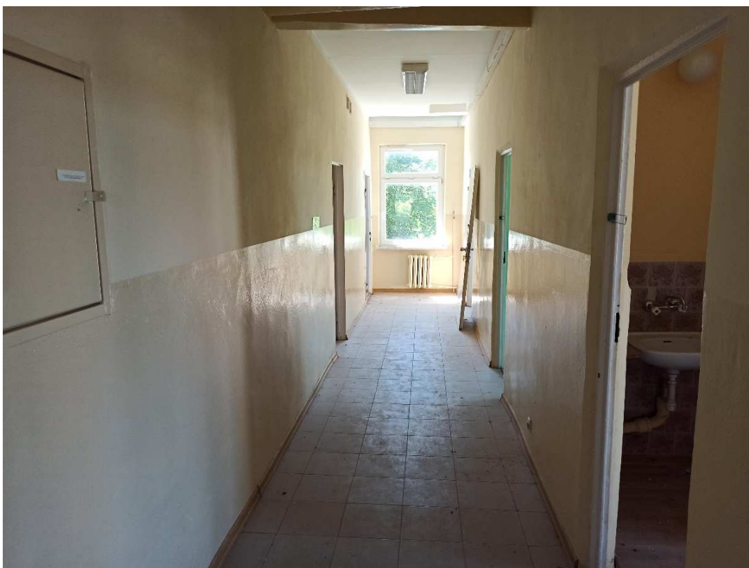
Fotografia nr 8 Widok z poziomu piętra na korytarz w części głównej budynku – stan istniejący
