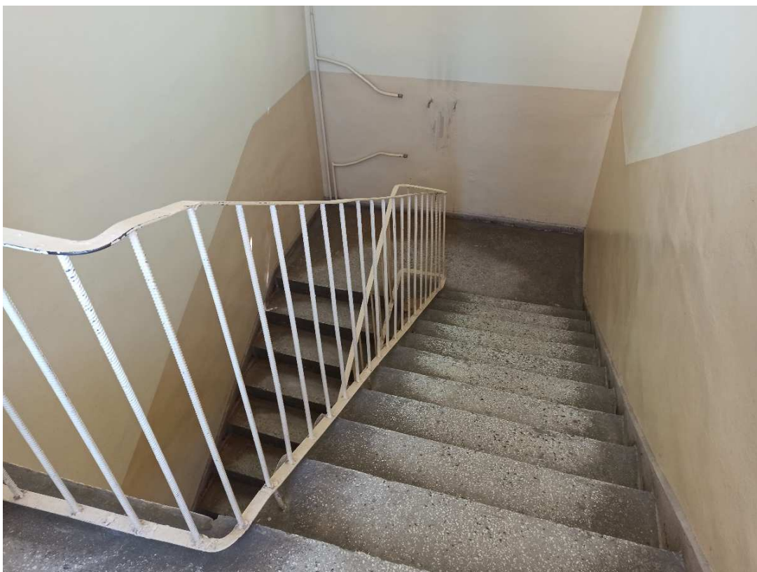
Fotografia nr 9 Widok z poziomu piętra na korytarz w części bocznej budynku – stan istniejący
