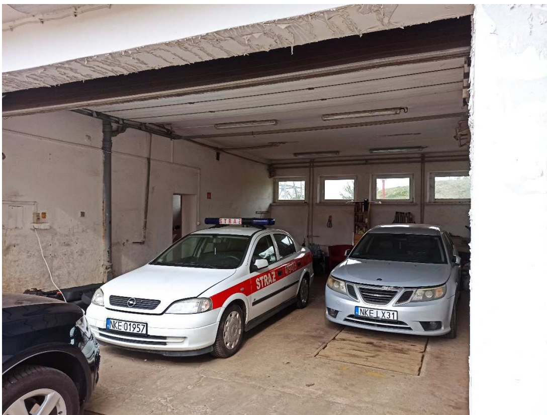
Fotografia nr 12 Widok od wewnątrz istniejącej części garażowej
