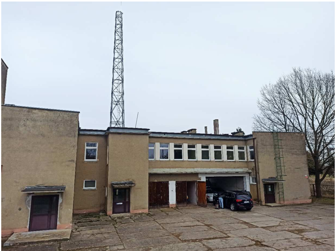
Fotografia nr 2 Widok elewacji tylnej (południowej) – stan istniejący
