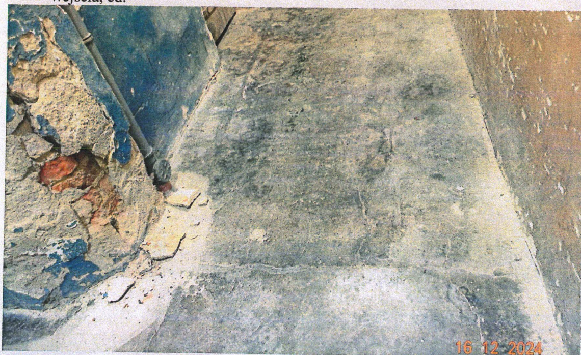
Zdjęcie nr 18 – widok spękań oraz odpadającego tynku na ścianie w korytarzu, po lewej stronie od wejścia, cd.
