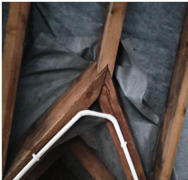
Fot. 12 Widok pofałdowanej, pozaginanej membrany (część środkowa)
