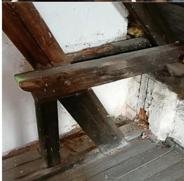
Fot. 13 Zniszczony węzeł: przegnita murlata, krokiew i słupek podpierający murlatę (skrzydło północne)
