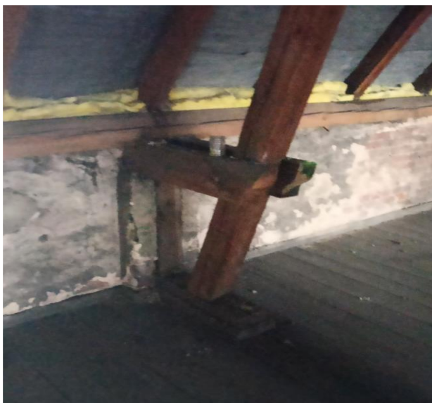
Fot. 7 Widok zawilgoconego muru, odspojony tynk, zniszczone fugi; obszar skrzydła południowego
