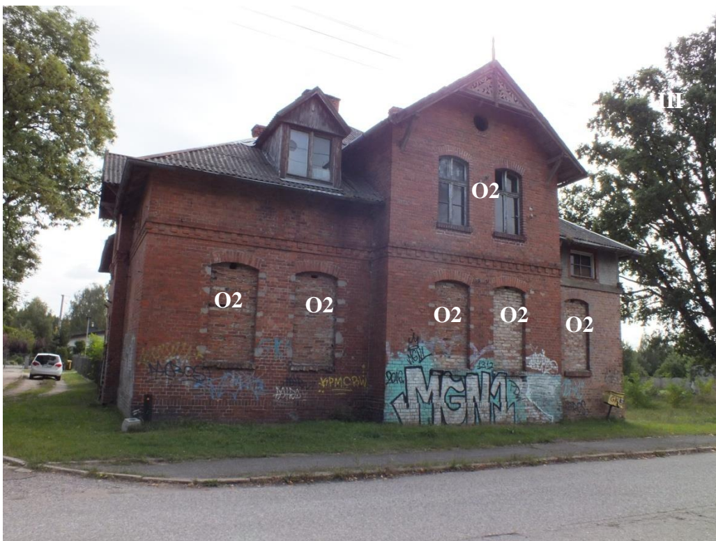
Pastorówka, ul. Bursztynowa, elewacja zachodnia z zaznaczonym usytuowaniem stolarek przeznaczonych do wymiany i do uzupełnienia
