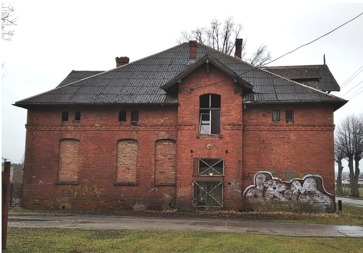
Fot. 3. Elewacja północno-wschodnia – widok od strony kościoła – wejście prowadzące na klatkę schodową, widoczne na elewacji zamurowane otwory okienne, elewacje do oczyszczenia z graffiti, demontaż pokrycia dachowego z eternitu
