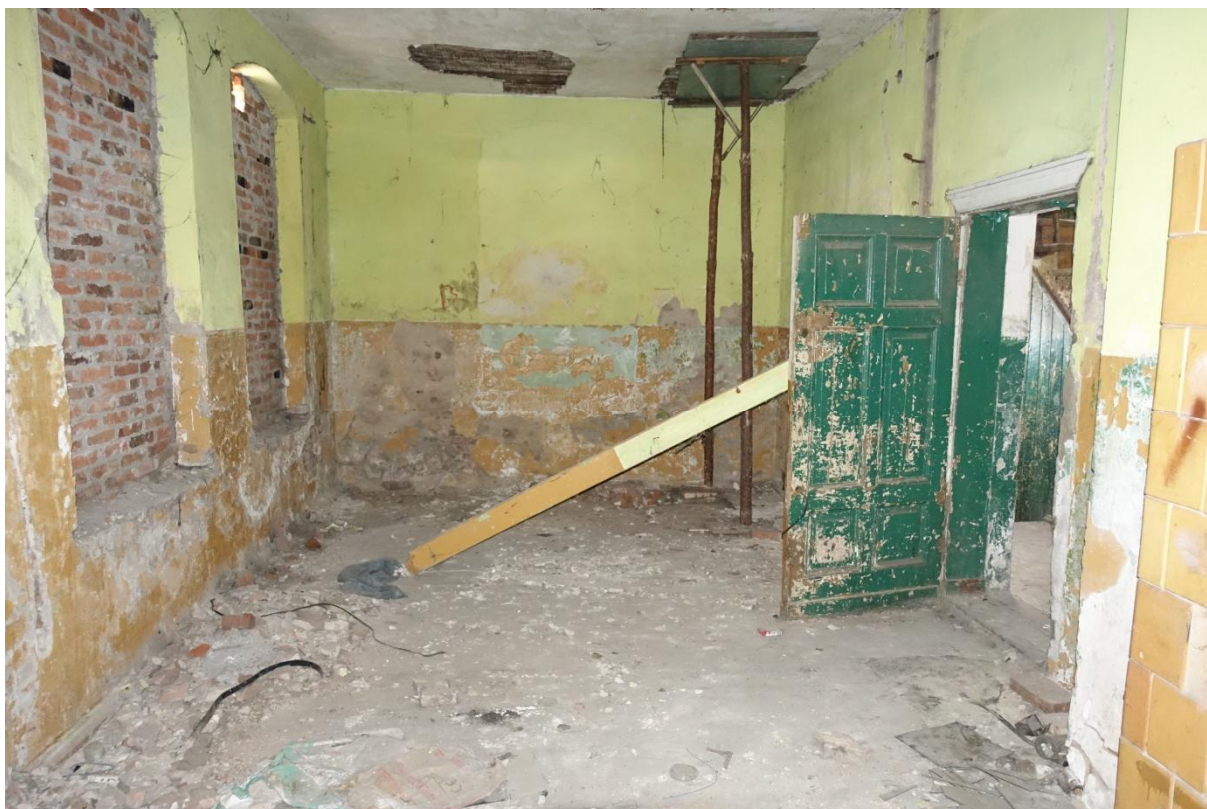
Fot. 14. Pomieszczenie parteru – skrzydło północno-zachodnie, widoczne zabezpieczenia stropu drewnianego po uszkodzeniach
