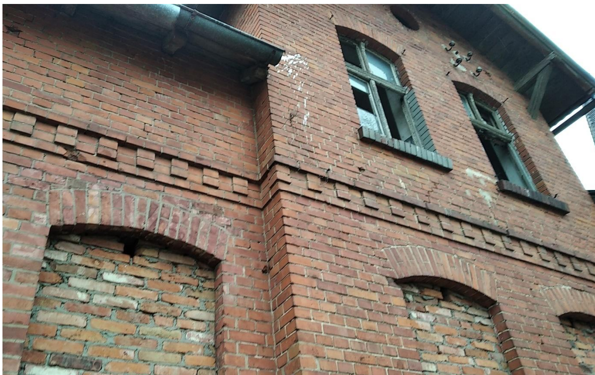
Fot. 8. Detale elewacji – nadproża, podokienniki, gzymsy
