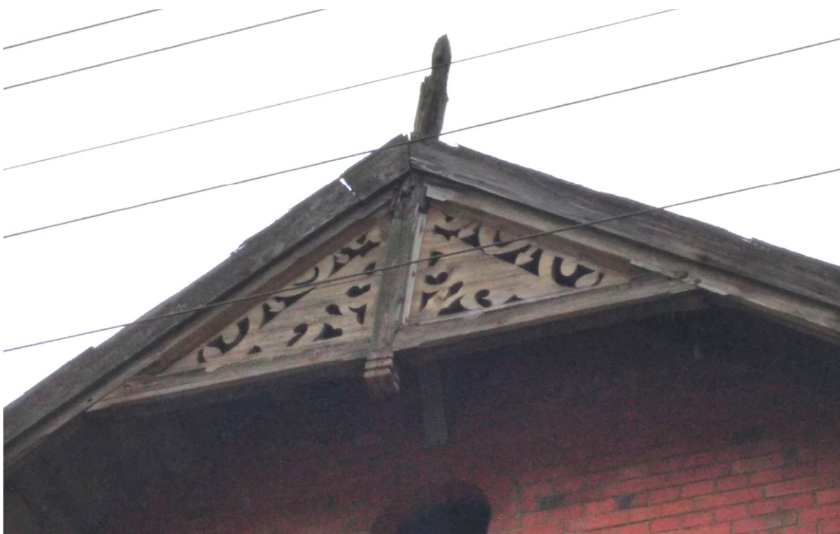
Fot. 9. Detal elewacji – snycerka szczytów dachu
