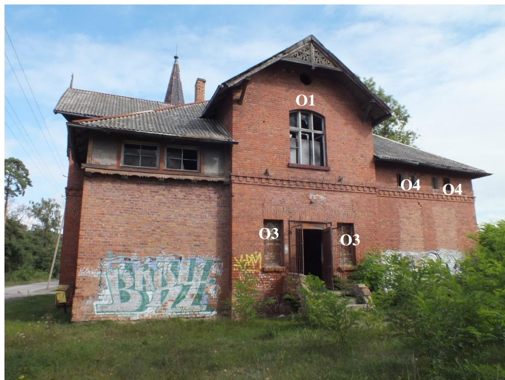
Pastorówka, ul. Bursztynowa, elewacja południowa z zaznaczonym usytuowaniem stolarek przeznaczonych do wymiany.
