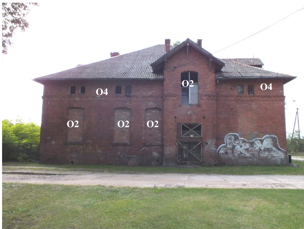
Pastorówka, ul. Bursztynowa, elewacja północna z zaznaczonym usytuowaniem stolarek przeznaczonych do wymiany i do uzupełnienia
