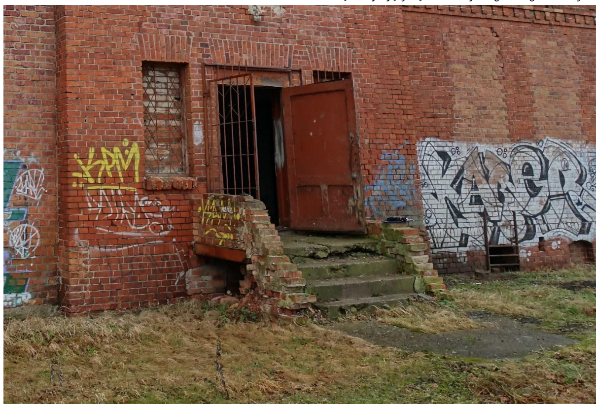
Fot. 11. Schody do budynku, zauważyć można naświetle piwniczne pod schodami, układ cegieł nie powiązany z elewacją
