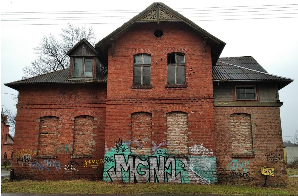
Fot. 2. Elewacja północno-zachodnia – widok od strony drogi ul Bursztynowej, widoczny brak obróbek blacharskich, lukarna jako element późniejszy do rozebrania, elewacje do oczyszczenia z graffiti, rozbiórka fragmentu ściany z szarej cegły i odtworzenie ściany
