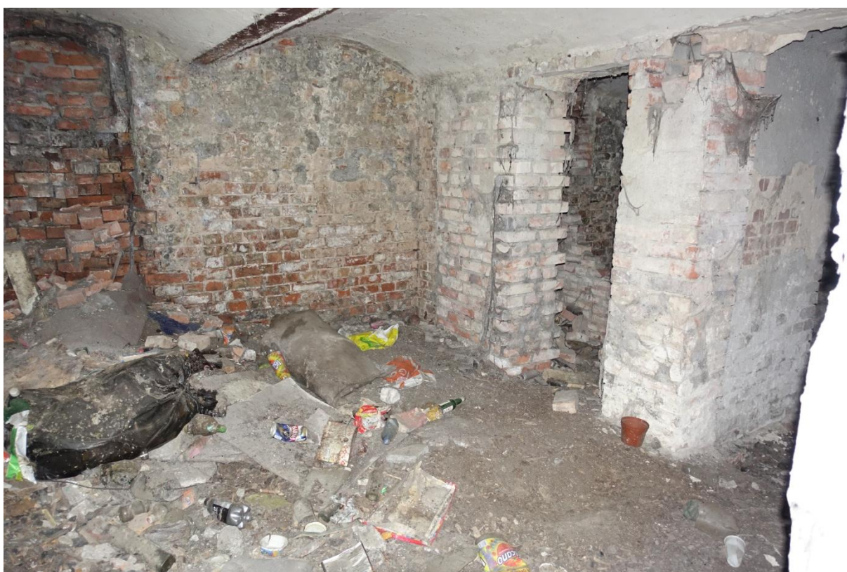
Fot. 23. Pomieszczenie piwnic ze stropami łukowymi Kleina, ściany ceglane otynkowane ze znacznymi uszkodzeniami, brak posadzki
