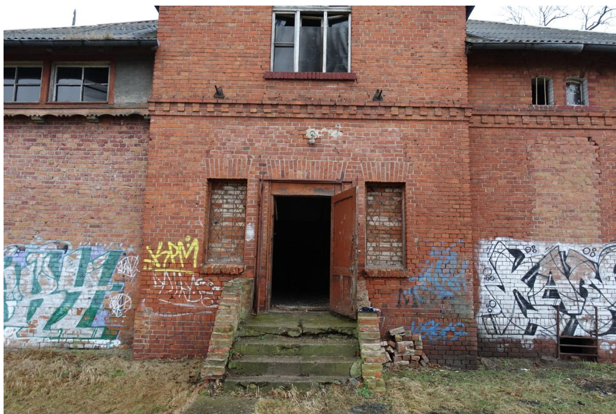
Fot.7. Wejście główne, widok na betonowe schody przewidziane do rozbiórki
