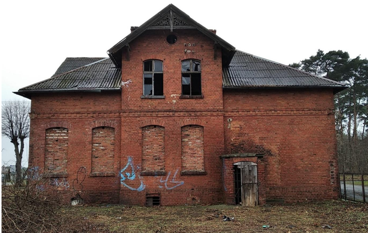
Fot.4. Elewacja południowo-wschodnia od strony ogrodowej, widoczne wejście do części piwnicznej, zamurowane otwory okienne, brak rynien i rur spustowych, stolarka okienna uszkodzona,
