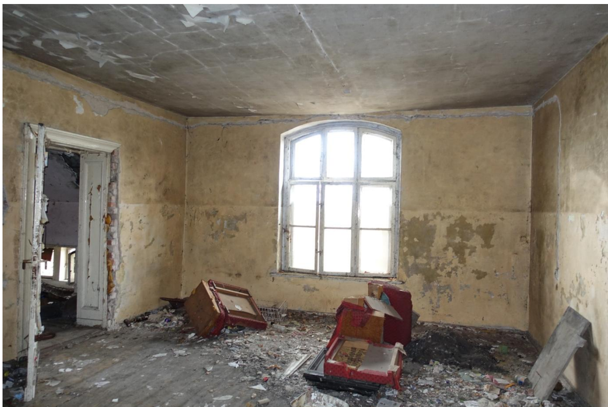
Fot.18. Pomieszczenie piętra nad wejściem głównym z widokiem na dqb, widoczne ugięcie sufitu, posadzka drewniana
