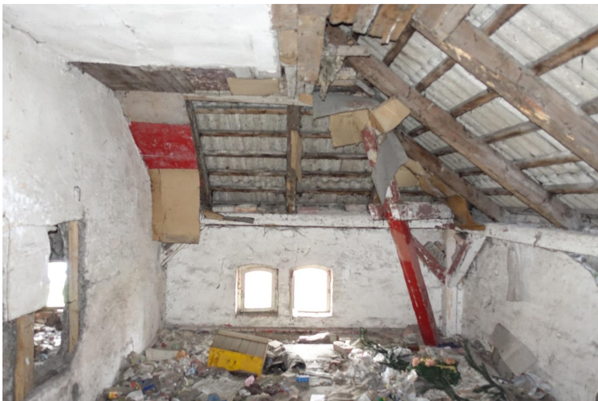
Fot. 20. Odśloną konstrukcją więźby dachowej, widoczne miejscowe, sporadyczne zacieki na elementach drewnianych świadczące o nieszczelności pokrycia dachu
