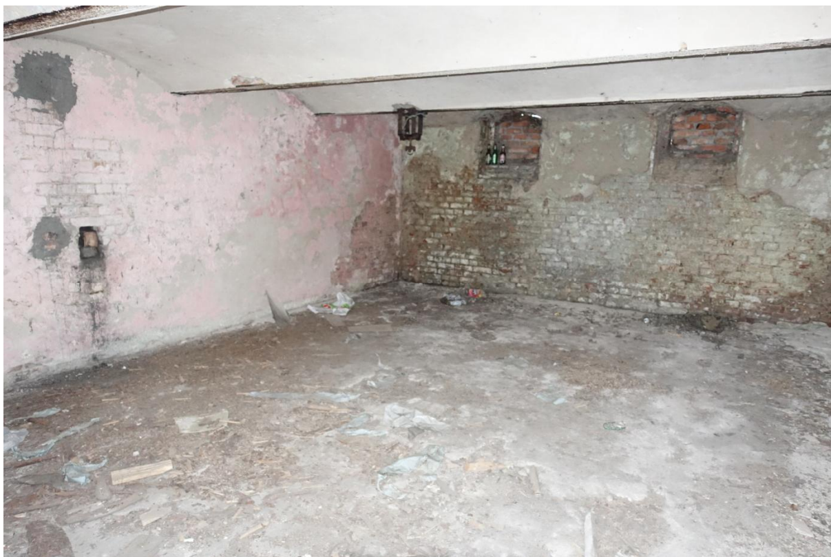
Fot. 24. Pomieszczenie piwnic – widoczny łukowy strop Kleina, posadzka betonowa
