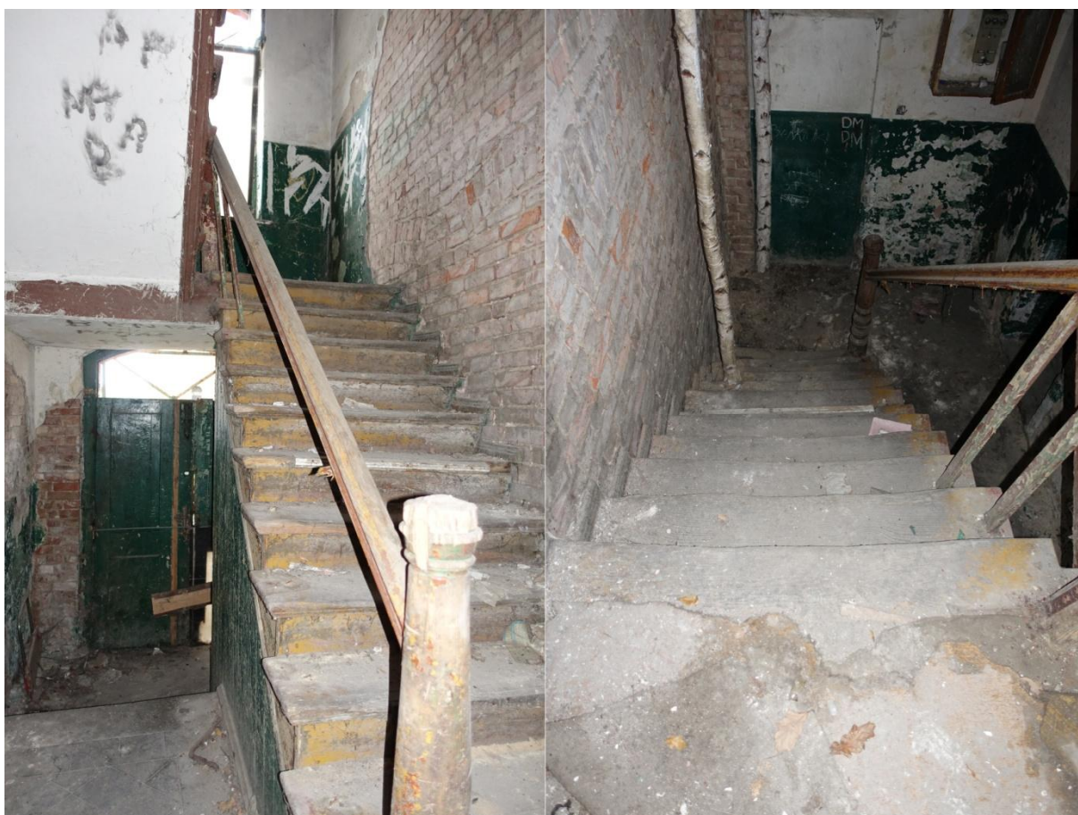
Fot. 15. Klatka schodowa drewniana w znacznym stopniu zniszczona, do odtworzenia
