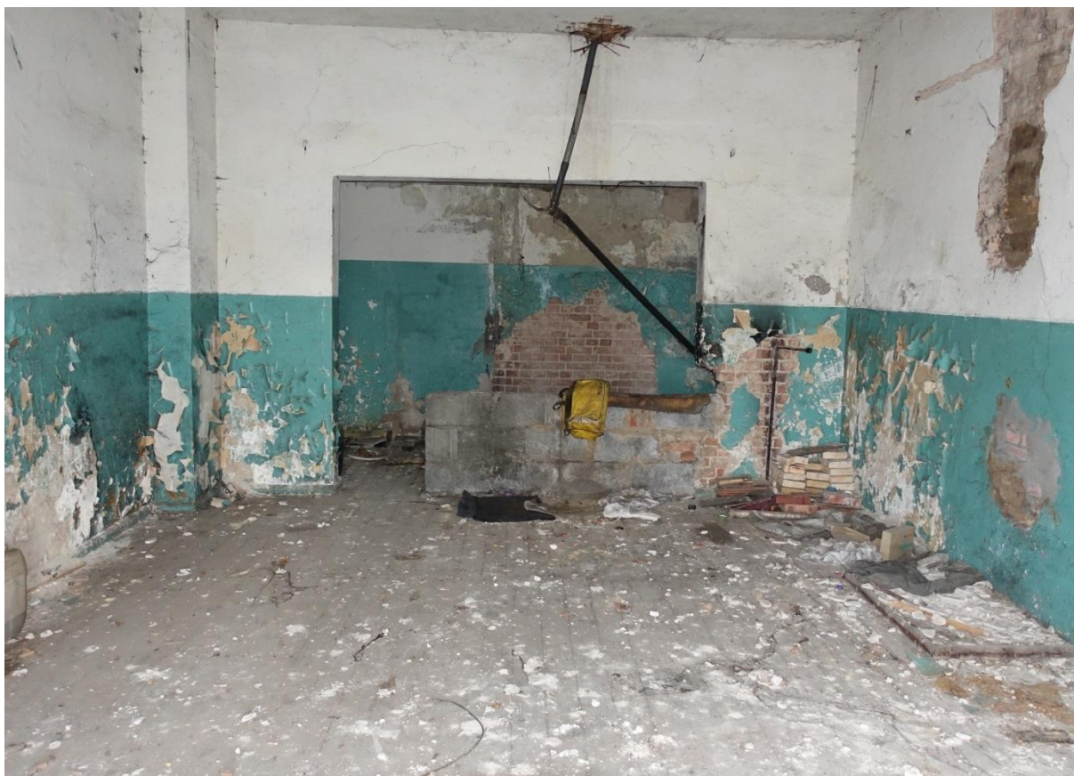
Fot. 12. Hall wejściowy, widoczna posadzka drewniana oraz zniszczony tynk na ścianach z łuszczącą się farbą
