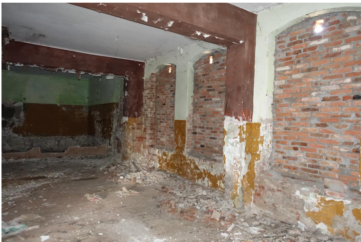
Fot. 13. Pomieszczenie parteru – skrzydło południowo-wschodnie, widoczna posadzka drewniana oraz zniszczony tynk na ścianach z łuszczącą się farbą
