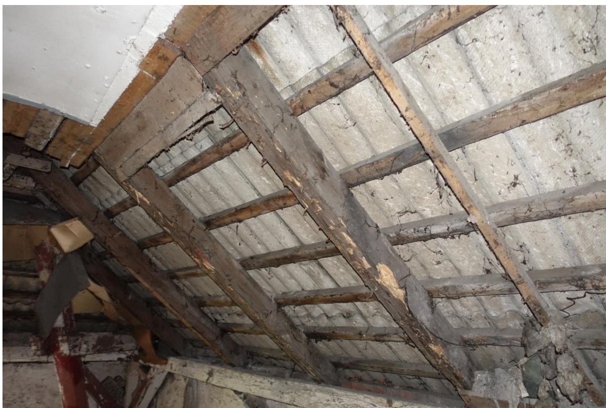
Fot 19. Odślonięta konstrukcja więźby dachowej, widoczne miejscowe, sporadyczne zacieki na elementach drewnianych świadczące o nieszczelności pokrycia dachu
