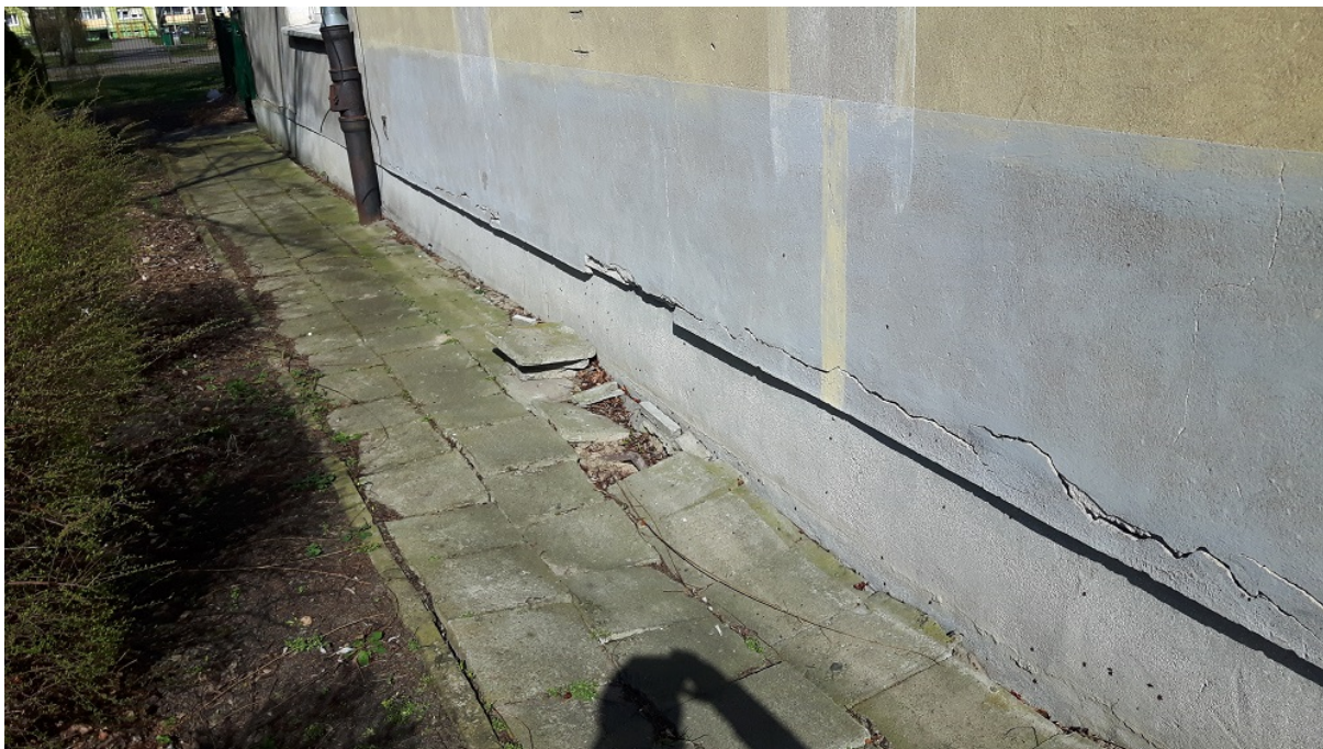
Fot. nr 7 Ubytki i pęknięcia cokołu sali gimnastycznej oraz zapadająca się opaska – elewacja południowo – zachodnia.
