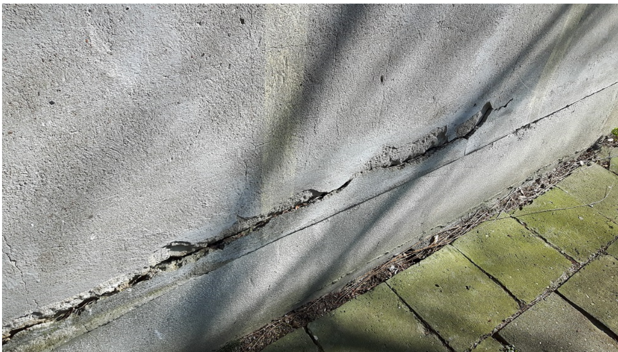
Fot. nr 6 Ubytki i pęknięcia cokołu sali gimnastycznej.
