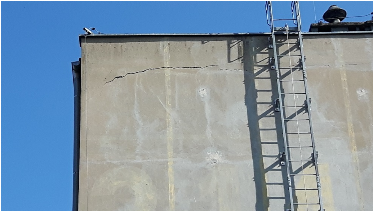
Fot. nr 3 Elewacja południowo – zachodnia (szczyt budynku szkoły) – pęknięcia przy attyce.
