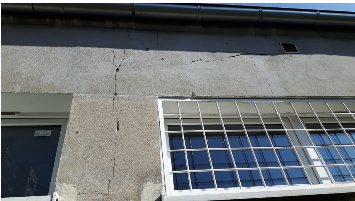
Fot. nr 8 Pęknięcia ścian zaplecza sali gimnastycznej – elewacja południowo – zachodnia.
