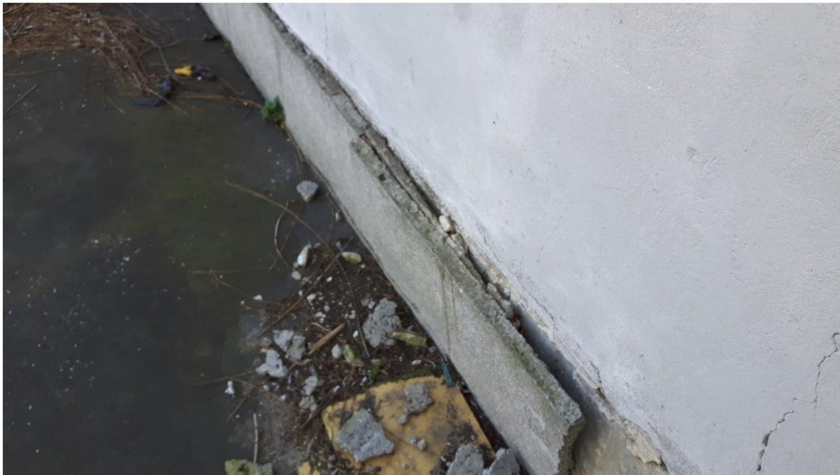
Fot. nr 5 Odpadające fragmenty cokołu sali gimnastycznej.
