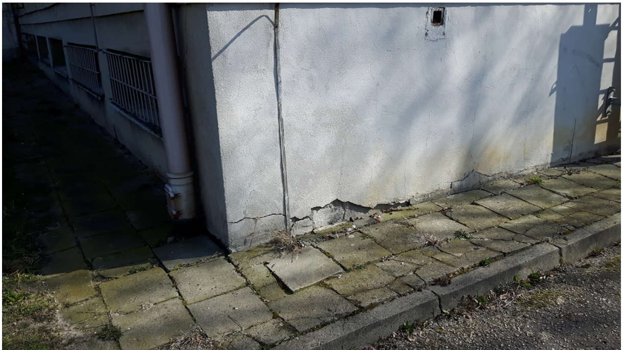
Fot. nr 10 Ubytki w tynku, destrukcja opaski – elewacja południowo – zachodnia.
