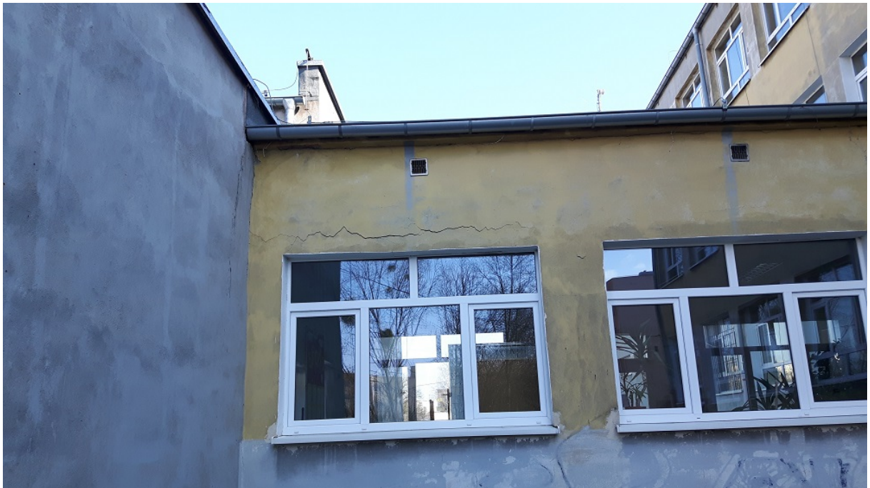
Fot. nr 9 Pęknięcia ścian łącznika – elewacja południowo – zachodnia.
