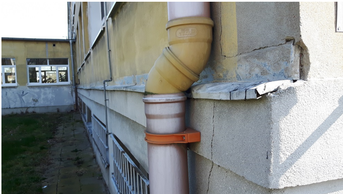
Fot. nr 11 Obróbki blacharskie – elewacja południowo – zachodnia.
