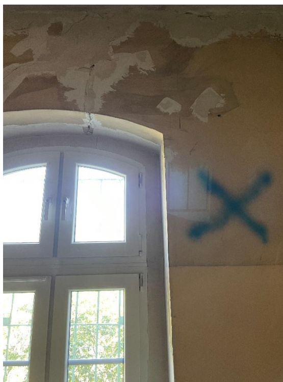
Rysunek 4-17. Odkrywka X. Zarysowania nadproży ścian zewnętrznych.
