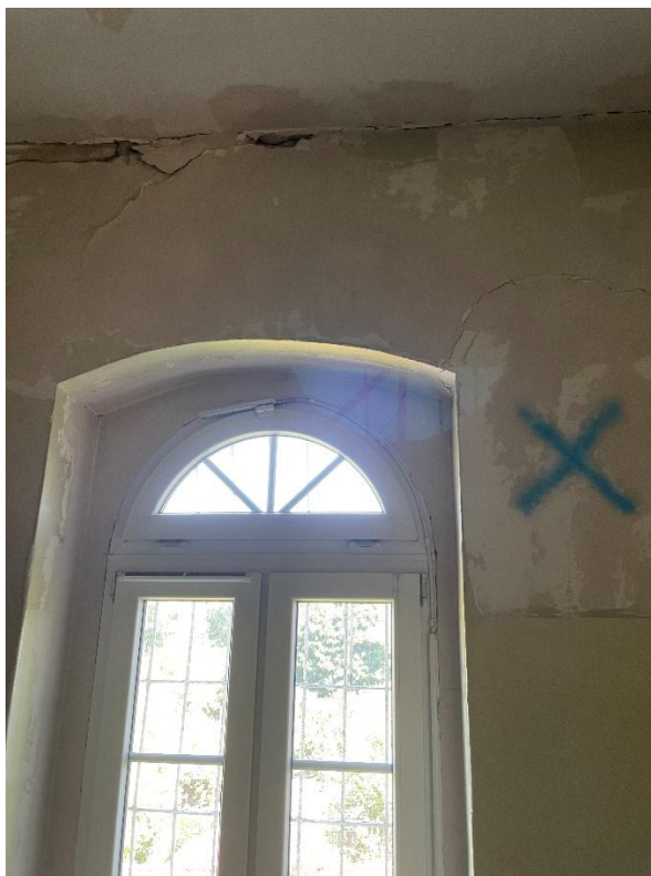
Rysunek 4-16. Odkrywka X. Zarysowania nadproży ścian zewnętrznych.
