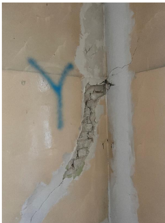
Rysunek 4-13. Odkrywka Y1. Pęknięty narożnik od strony wewnętrznej.
