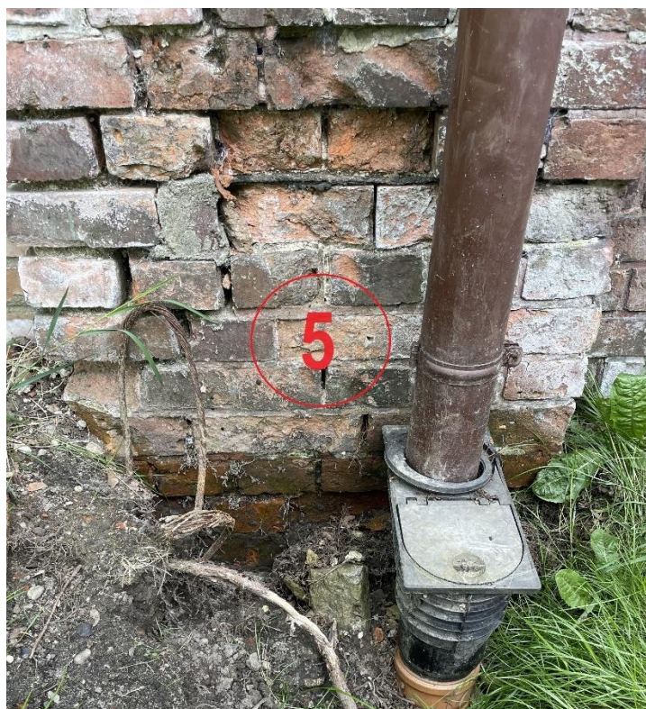
Rysunek 4-12. Odkrywka 5. Widok pęknięcia narożnika budynku na elewacji zewnętrznej.
