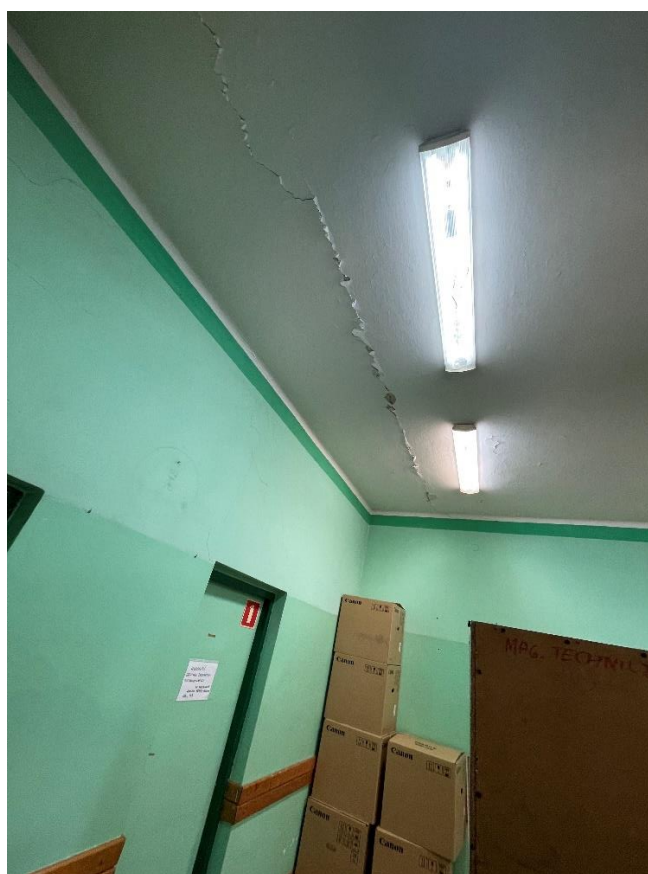
Rysunek 4-9. Odkrywka 2,3. Pęknięcia stropu pod ścianami nośnymi piętra.
