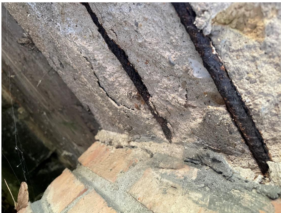
Rysunek 4-3. Odkrywka 1. Sprawdzenie średnicy prętów, oraz stanu prętów dolnych.
