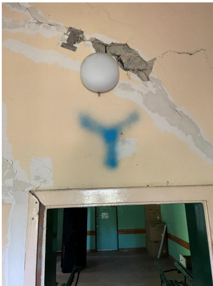
Rysunek 4-15. Odkrywka Y3. Pęknięcia nadproża ściany wewnętrznej.
