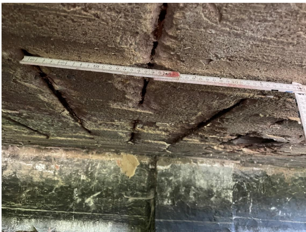
Rysunek 4-2. Odkrywka 1. Pomiar rozstawu prętów.
