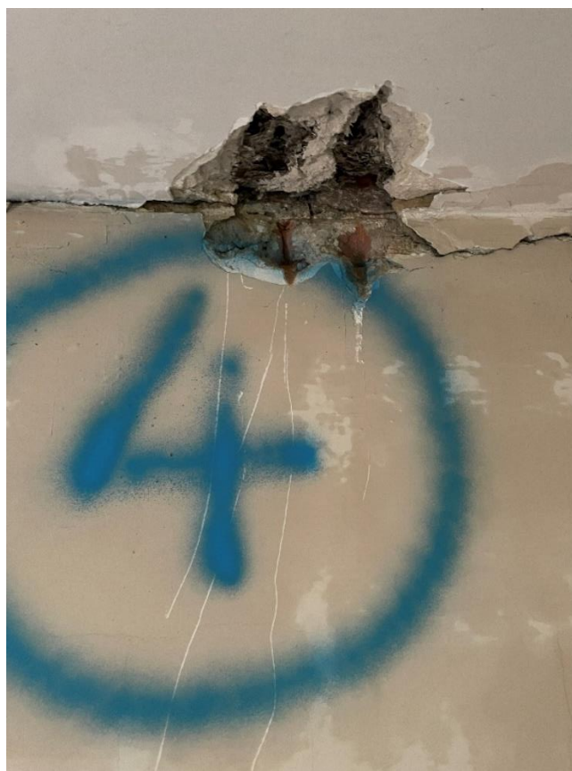
Rysunek 4-10. Odkrywka nr 4. Sufit piętra.
