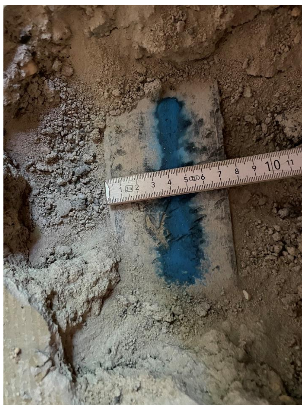
Rysunek 4-7. Odkrywka 2,3. Pomiar półki belki stalowej.
