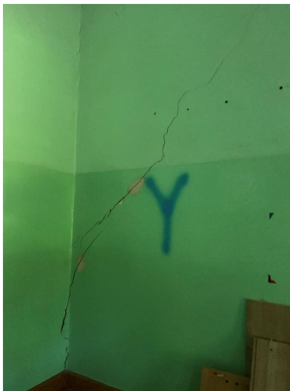
Rysunek 4-14. Odkrywka Y2. Zarysowanie narożnika ściany nośnej.
