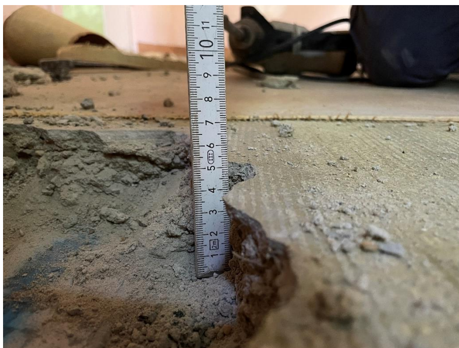
Rysunek 4-8. Odkrywka nr 2. Sprawdzenie grubości nadbetonu.
