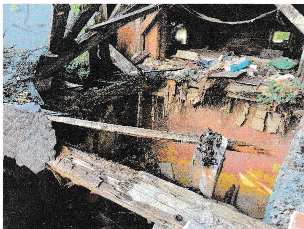
Fot. 1.9 – Zarwany dach i strop nad parterem budynku
