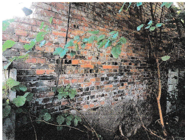
Fot. 1.6 – Uszkodzenia cegieł narożnika budynku
