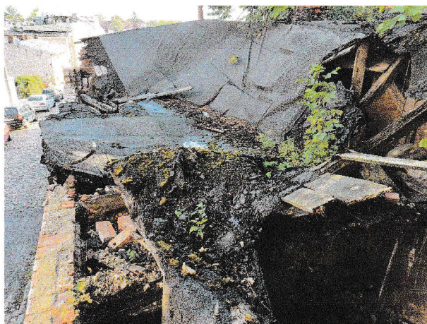
Fot. 1.10 – Zniszczona konstrukcja dachu i pokrycie dachu
