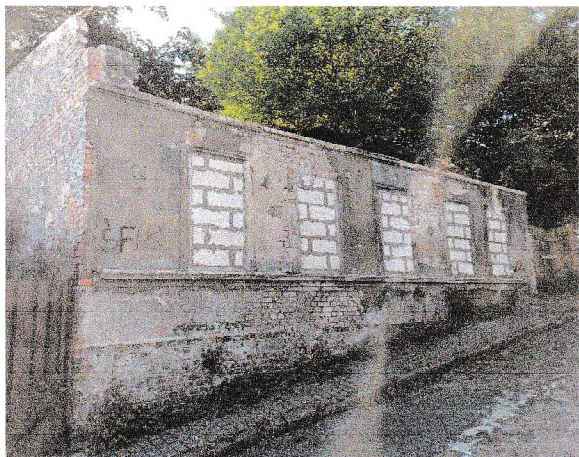
Fot. 1.3 – Ubytki zapraw w spoinach muru zewnętrznego
