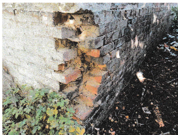
Fot. 1.6 – Uszkodzenia cegieł narożnika budynku
