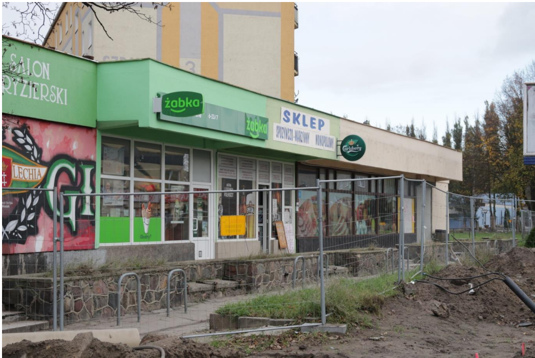
Widok pawilonu od ul. Stryjewskiego. Źródło: inwentaryzacja
