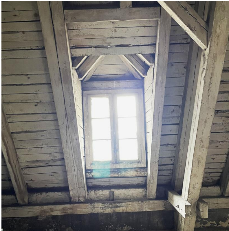
2.3 Okna w wykuszach – widok od strony strychu; górne okno posiada elementy wymienione (klamka, okucia, zapewne skrzydła)
