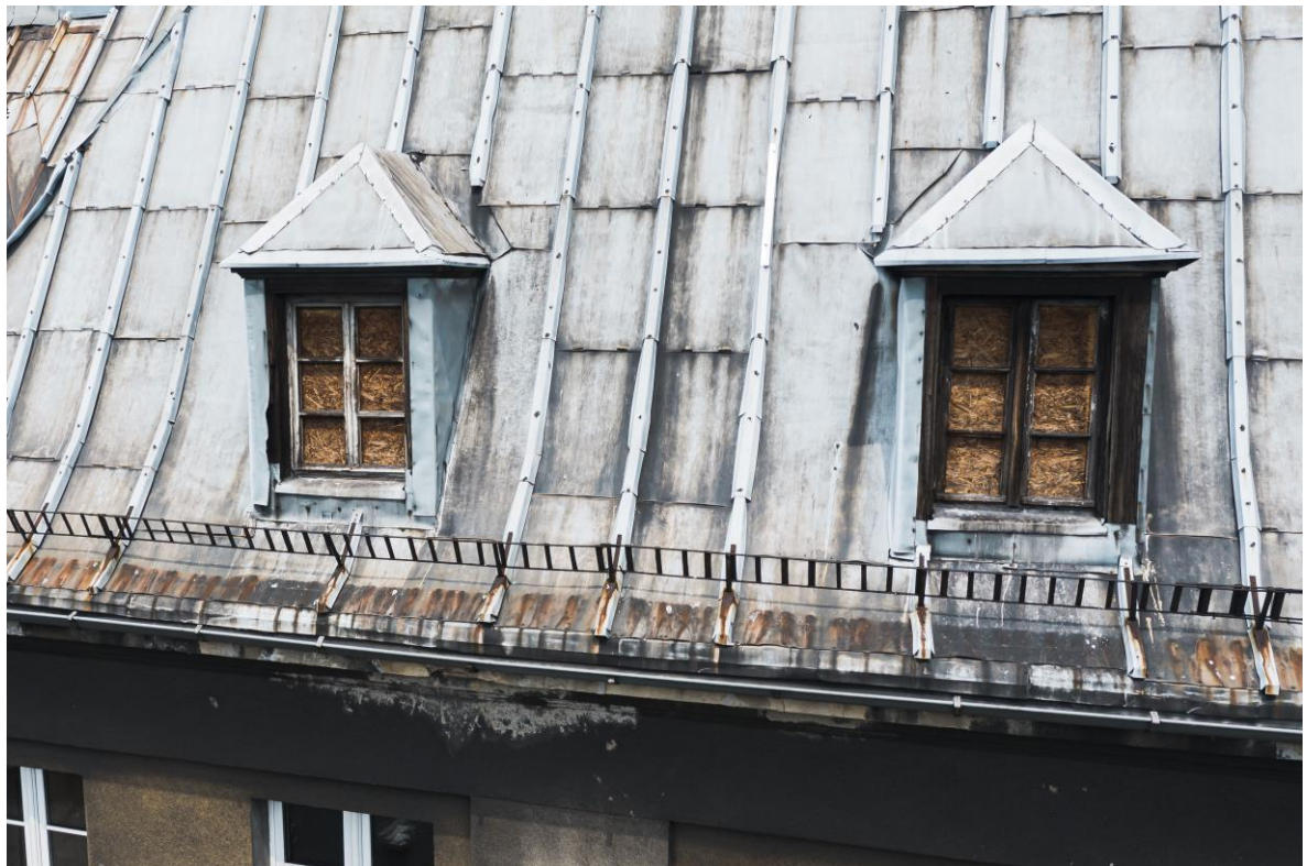
2.8 Wykusze w narożniku budynku, widoczne zniszczenia drewna (w oknie prawym praktycznie brak powłok malarskich), zamiast szyb – płyta OSB
