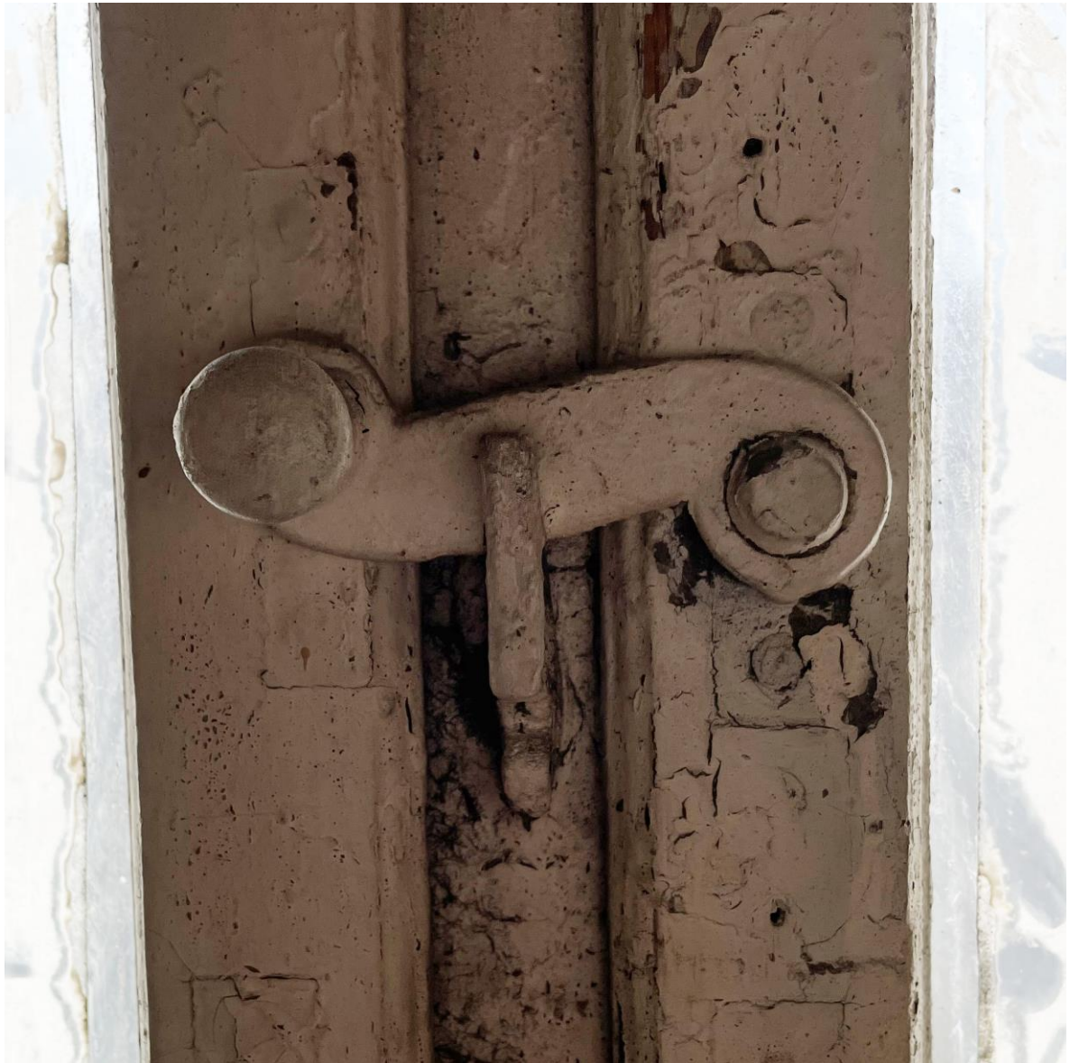
2.5 Zasułka okienna oryginalna (wielokrotnie przemalowywana)
