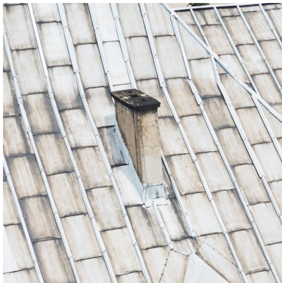
2.9 Oryginalny nieczynny komin, widoczne profilowania pionowe oraz forma czapy kominowej
