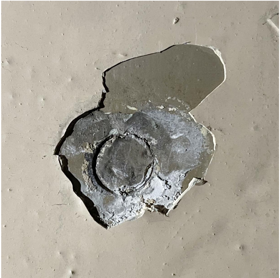
2.13 Naturalna odkrywka warstw malarskich drzwi w obrębie nitu; wyróżnić można kolorystykę szarą, oliwkową i szaro-ugrową
