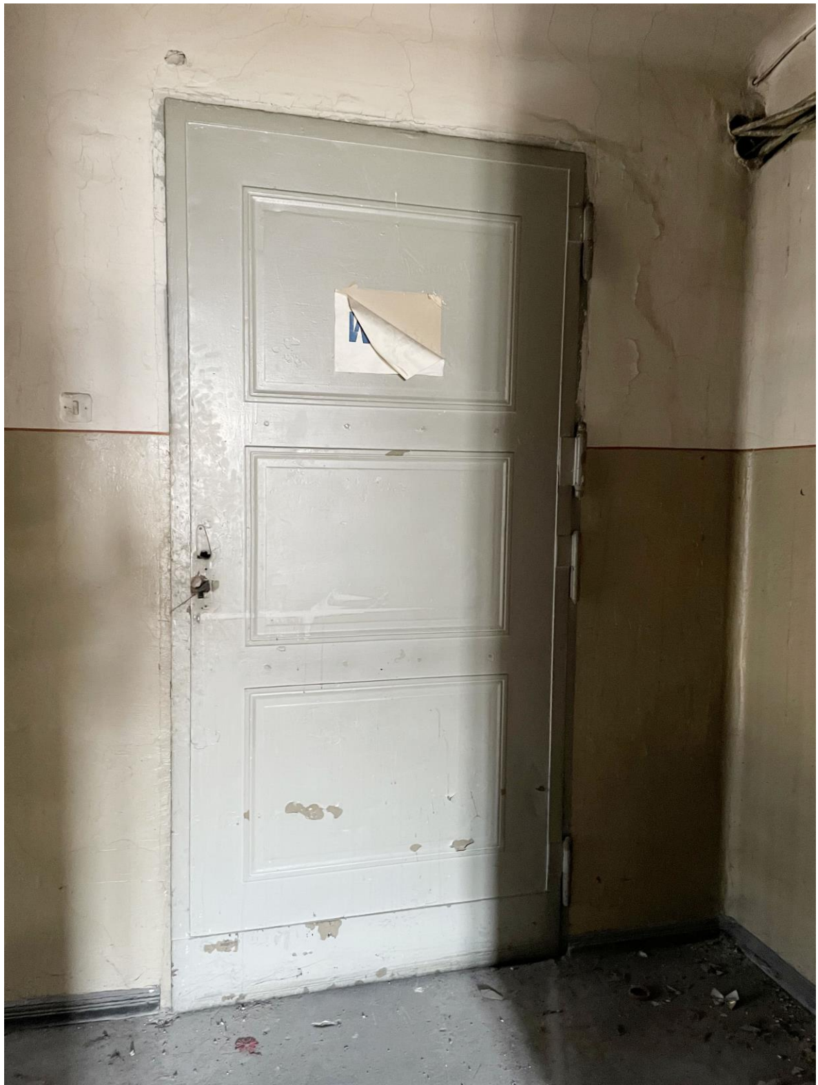
2.12 Oryginalna zachowana ślusarka stalowa na jednej z klatek schodowych budynku
