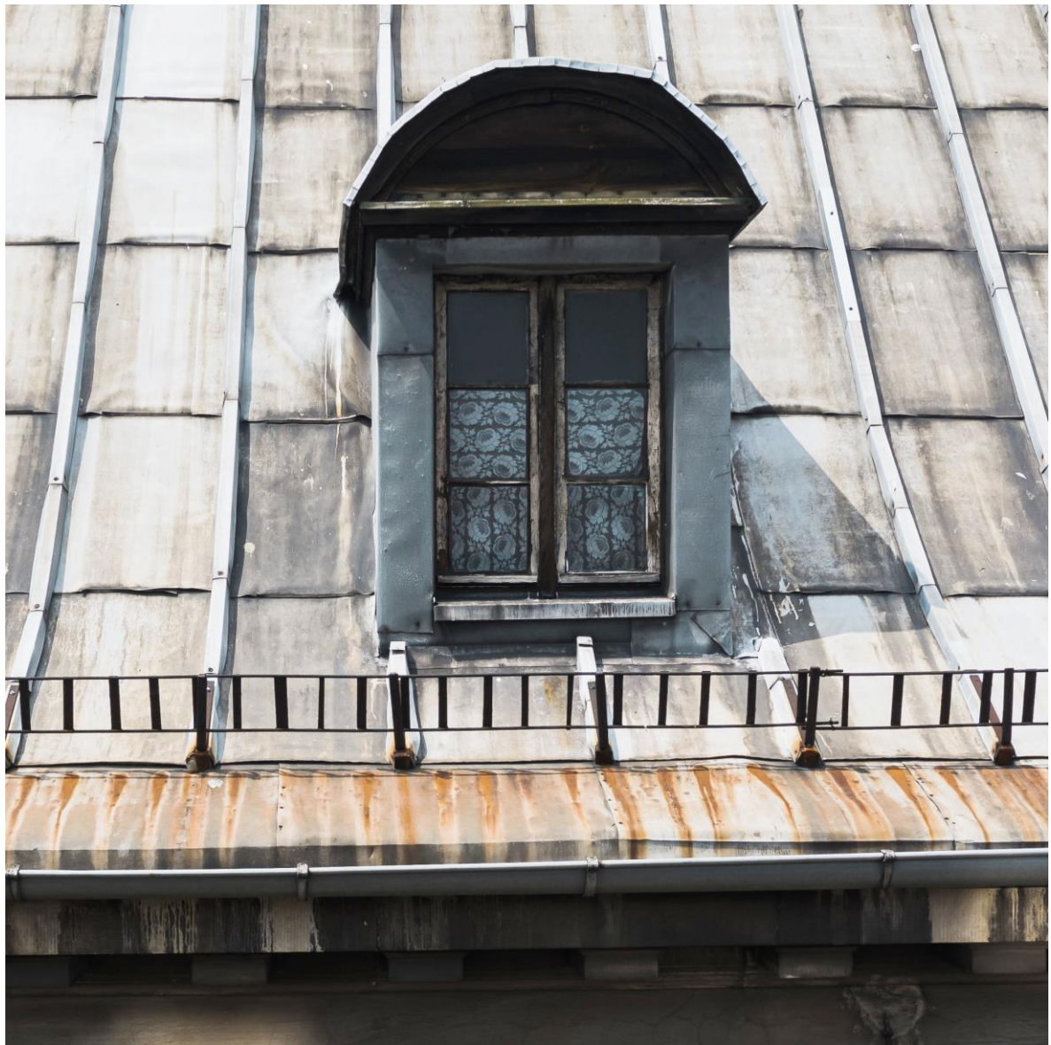
2.7 Wykusz od strony ul. Kilińskiego, ofasowania wtórne z blachy, liczne uzupełnienia kitów
