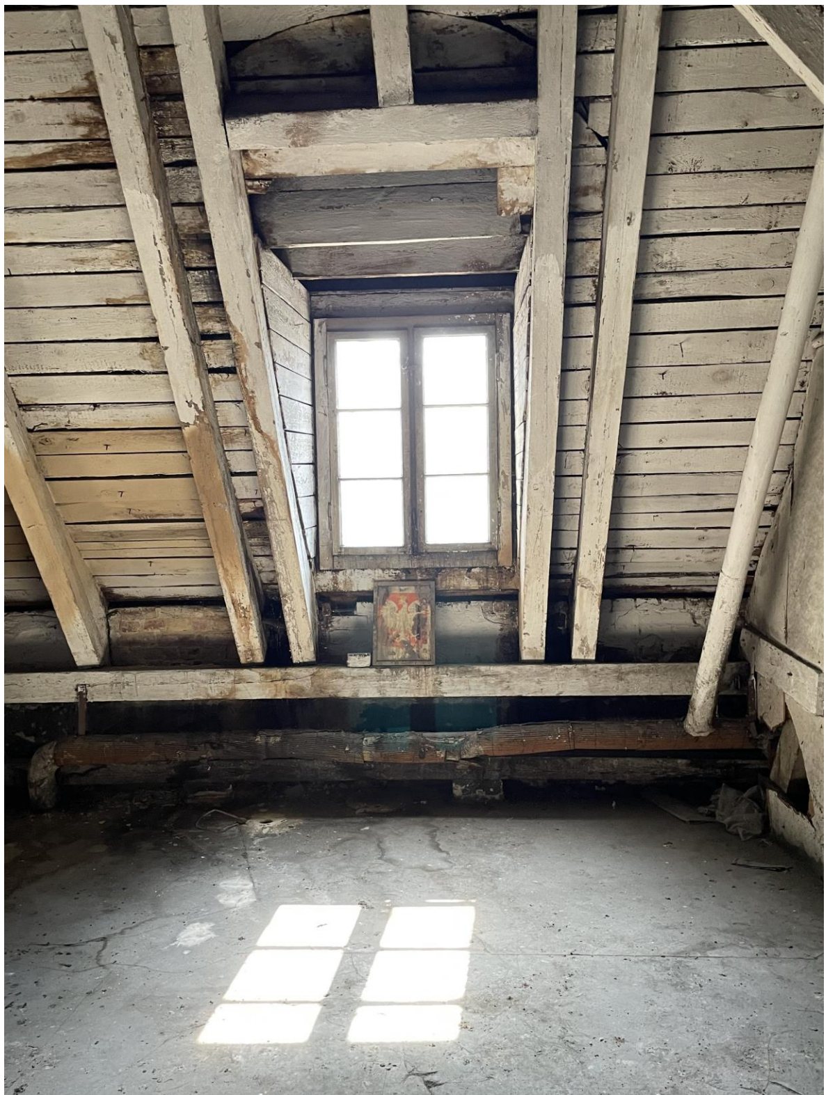
2.4 Pierwotna stolarka okienna, z zachowanymi zasuwkami, szprosami, szklenie wtórne
