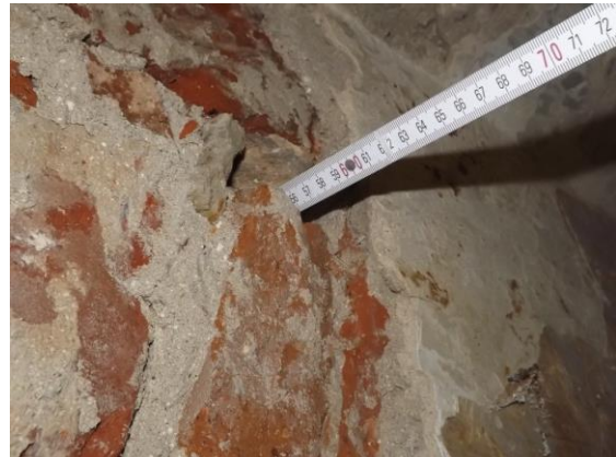
Gł .spoin poziomych na płaszczyźnie grzbietowej sklepienia.
