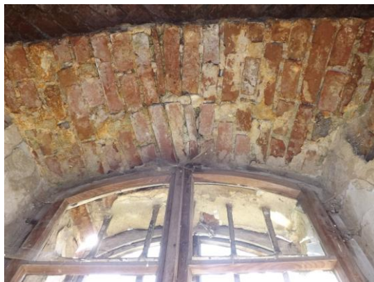
Sklepienie łukowe otworu okiennego
