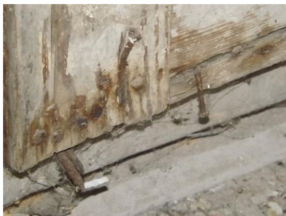
Ramiak dolny drzwi wejściowych
