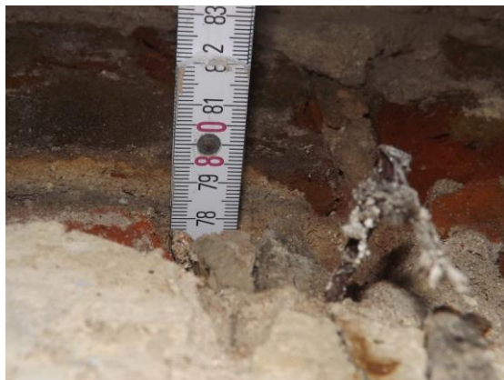
Gł .spoin poziomych na płaszczyźnie grzbietowej sklepienia.
