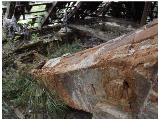
Kanał dolotowy degradacja konstrukcji kanału i materiału.
