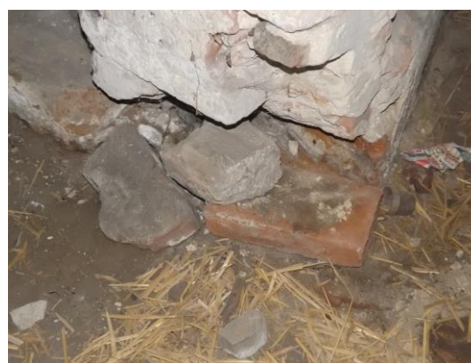
Ubytek w filarze przyotworowym
