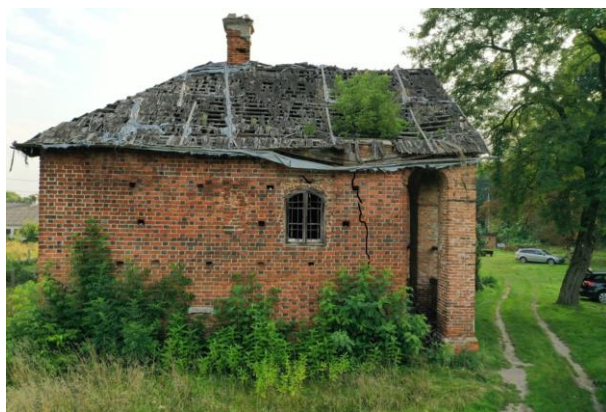
Ściana południowa, południowo-zachodnia.
