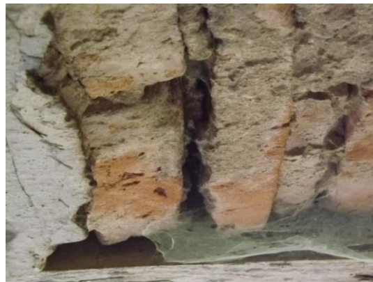
Sklepienie proste otworu drzwiowego.
