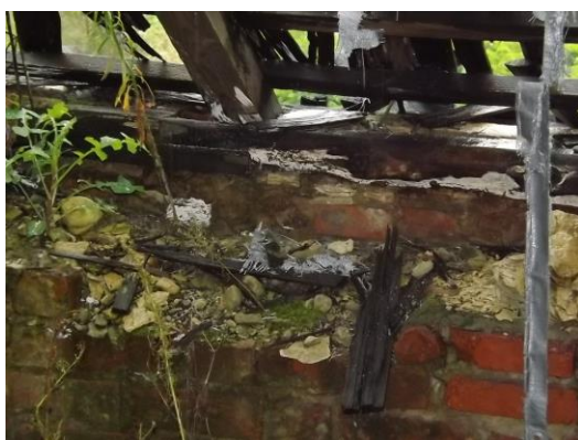
Degradacja kamienia w koronie muru .
