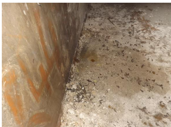
Kałuże podeszczowe w pomieszczeniach zachodnim i wschodnim.
