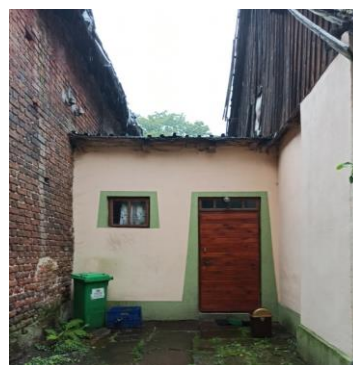
Strona północno-wschodnia zabudowa wejścia
