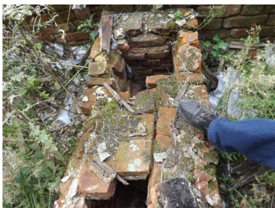
Kanał dolotowy degradacja konstrukcji kanału i materiału.
