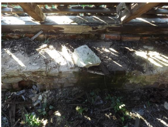
Murłata str. Północno- zachodnia.
