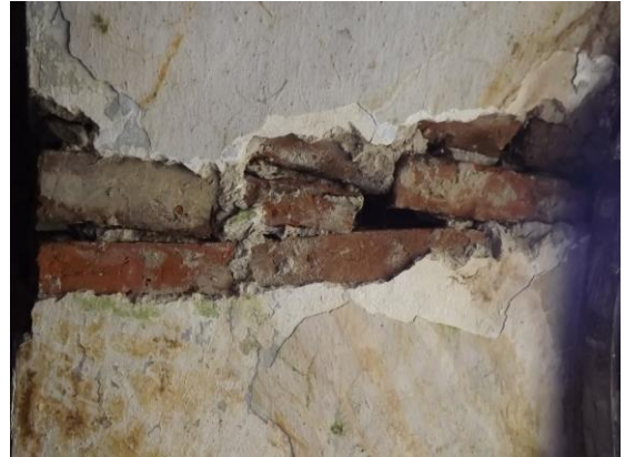
Po odkuciu tynku –zwornik sklepienia.
