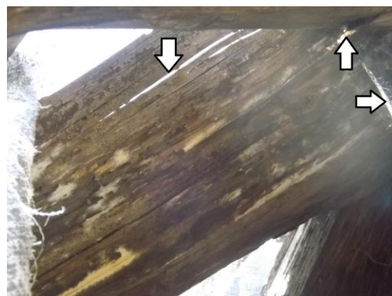
Krokiew koszowa, strzałki oznaczają prześwit przez warstwę zew. elementu.
