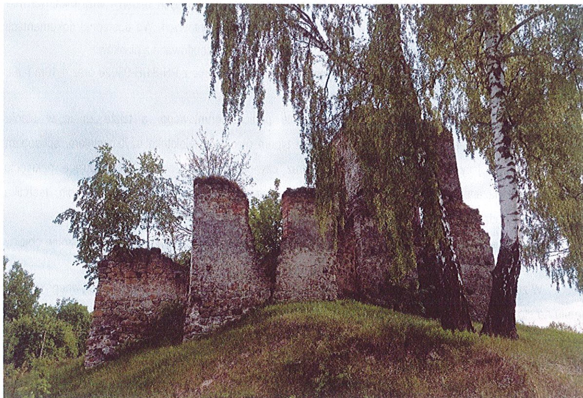
Fot. 9 Ruiny Zboru – elewacja północna (2024)
