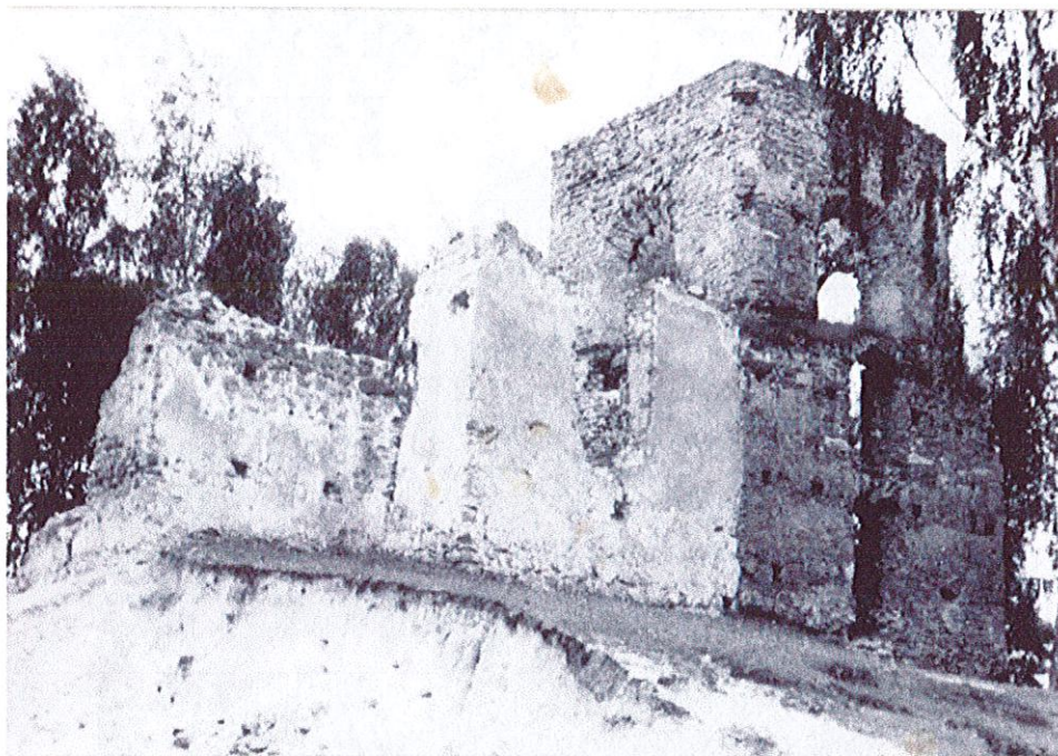
Fot. 1 Ruiny Zboru w latach 60-tych XX wieku (elewacja północna)
