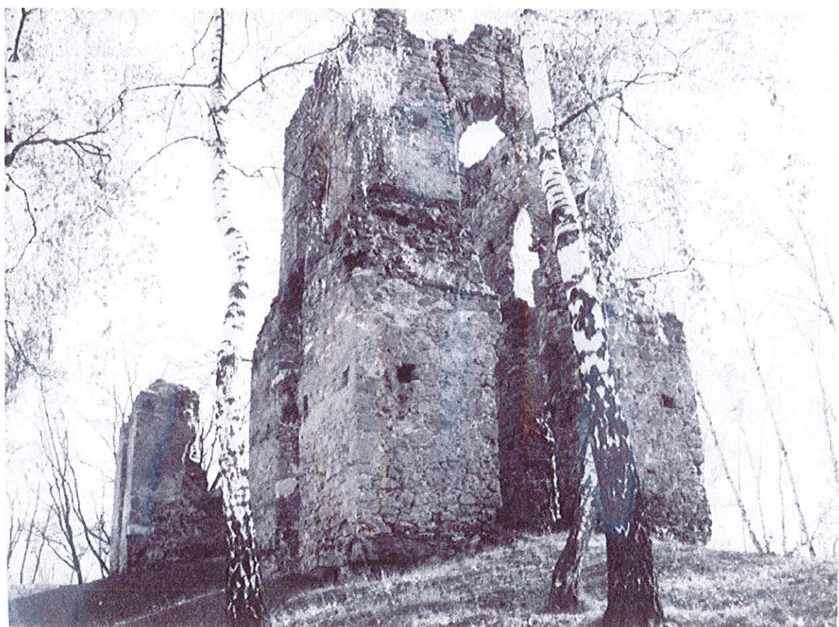
Fot. 5 Ruiny Zboru w latach 90-tych XX wieku (elewacja zachodnia i północna)
