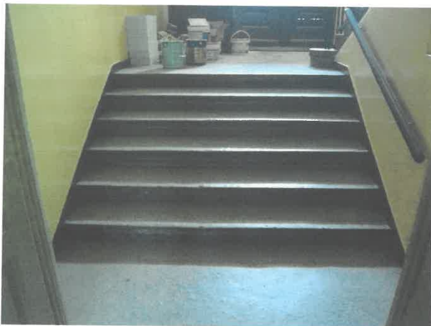
12. Schody: poziom piwnica – półpiwnica
