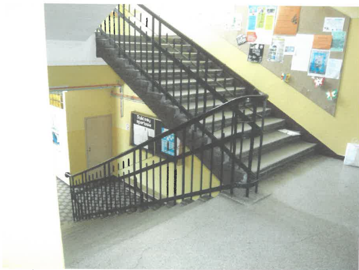
4. Schody: poziom półpiwnica – półpiętro 1
