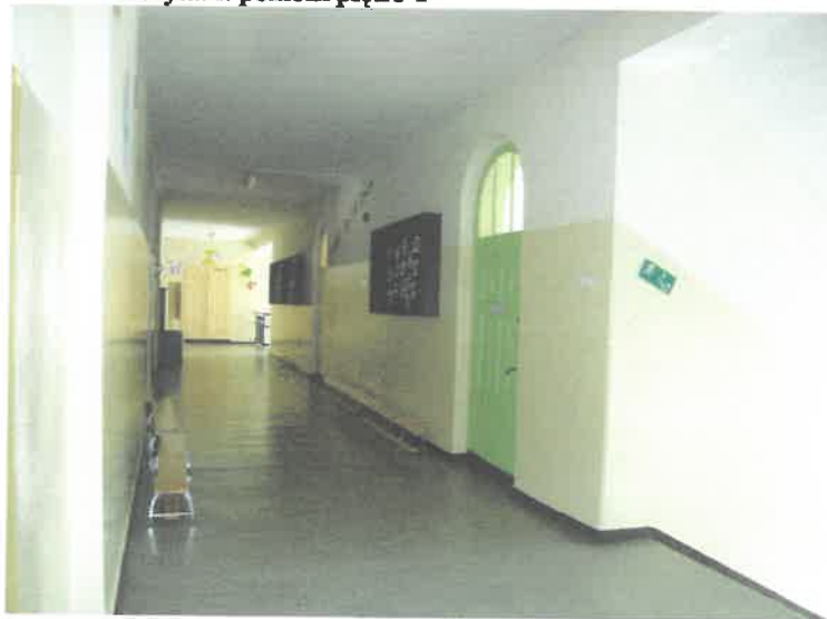
23. Korytarz: poziom piętro 2
