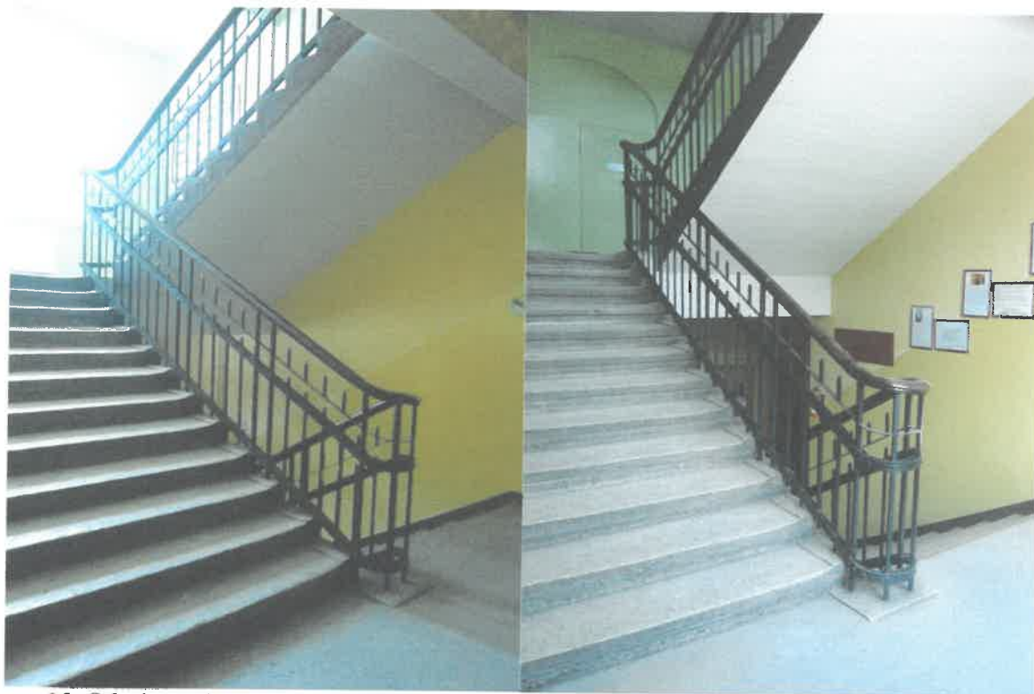
16. Schody: poziom parter – piętro 1
