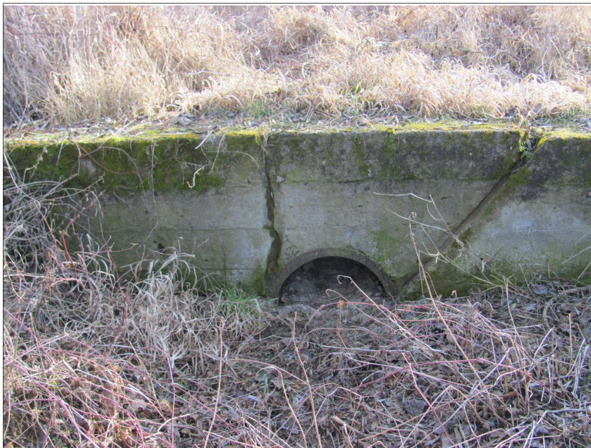
Fot. 5. Zasypany i uszkodzony przepust pod nasypem drogi wojewodzkiej nr 985 Dębica - Tarnobrzeg
