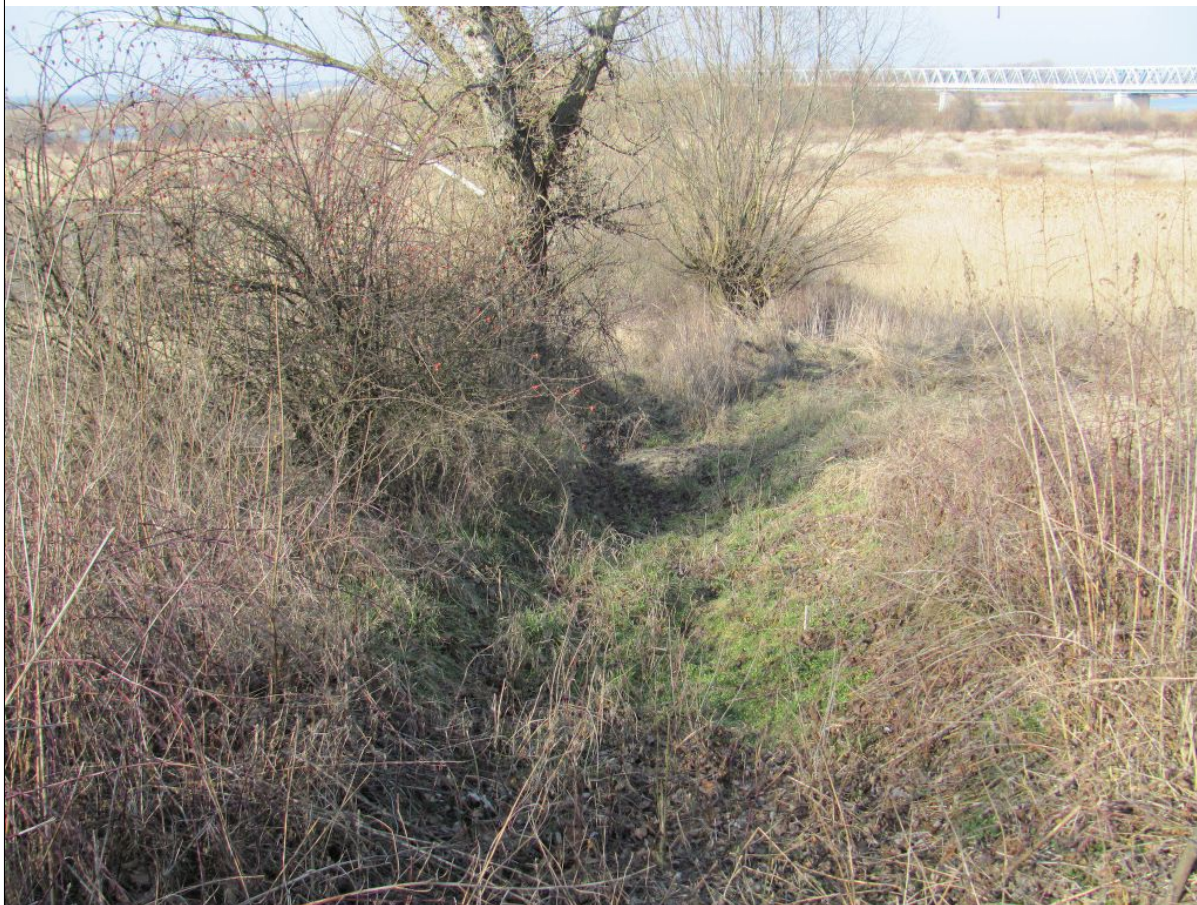
Fot. 6. Rów odwadniający w obrębie osuwiska
