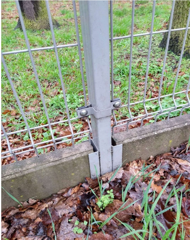
2. Mocowanie panela - przyziemie
