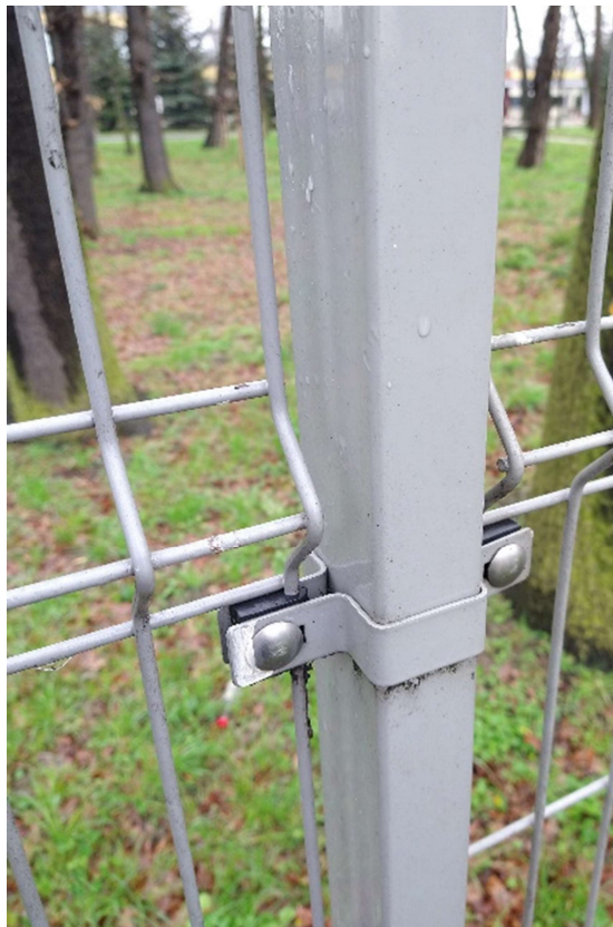
3. Mocowanie panela do słupka
