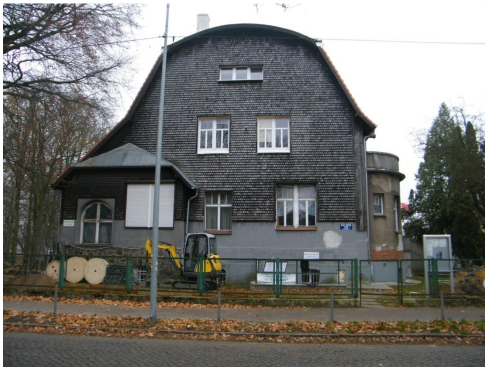
Fot.nr 7. Widok elewacji szczytowej , północnej – cokół częściowo z kamienia i częściowo pokryty tynkiem.
