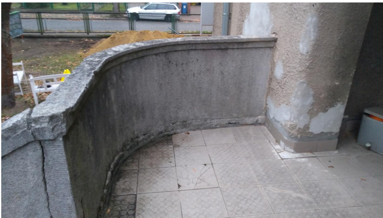
Fot.nr 5. Widok elewacji bocznej schodów głównych – strona prawa , widok na nawierzchnię z płytek klinkierowych oraz widok zniszczenia tynku elewacji wejścia, .
