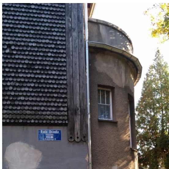
Widok elewacji – strona zachodnia , część elewacji z desek
