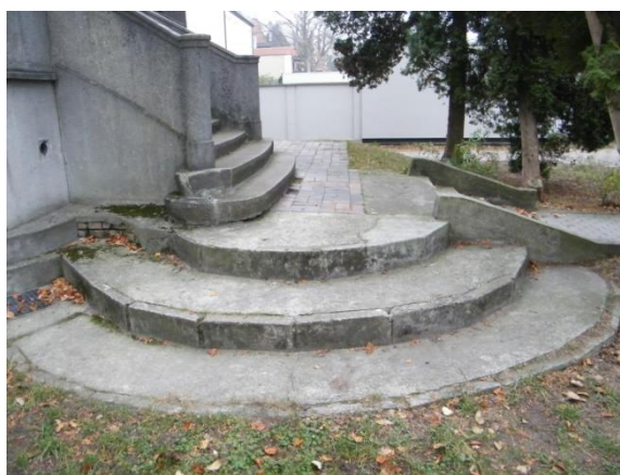
Fot.nr 2. Widok elewacji bocznej schodów głównych – boczny podest kolisty wejściowy strona lewa .
