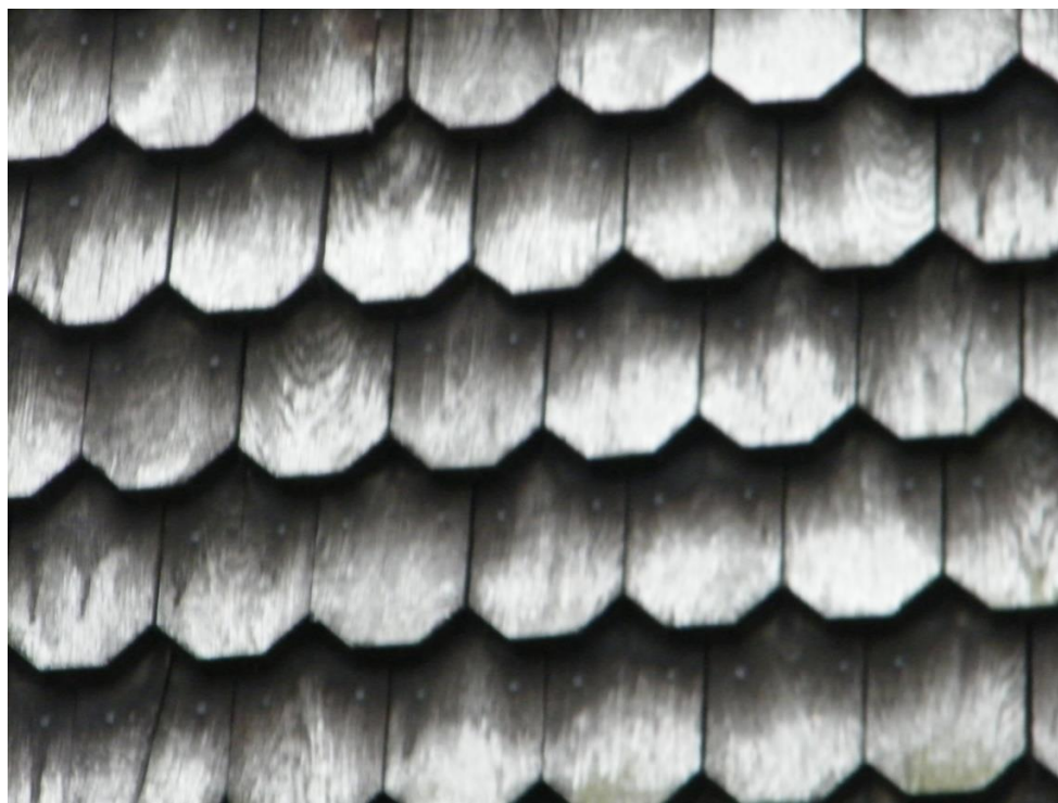
Fot.nr 8. Układ gontu drewnianego do konserwacji – wym. 10 x 13 cm
