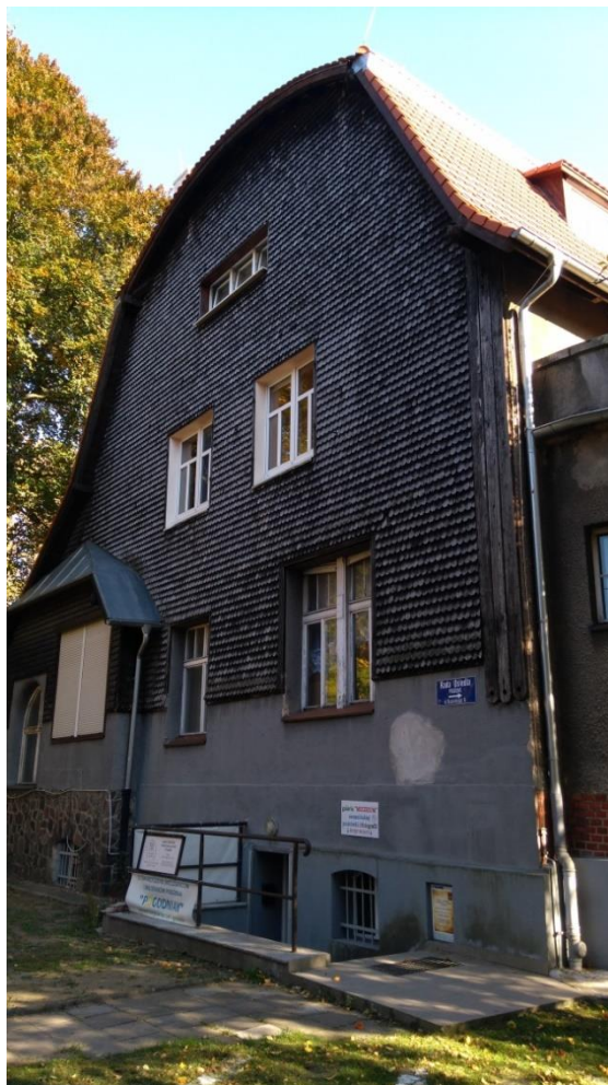
Widok na elewację zachodnią – elewacja pokryta gontem drewnianym o wy.: 10 x 13 cm
