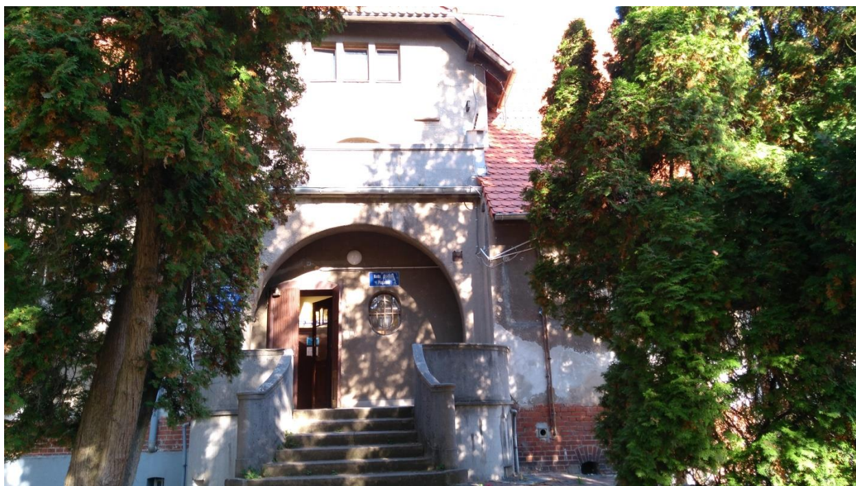
Fot.nr 9. Widok na wejście amfiladowe do budynku przy ul.Krasickiego. Widoczna forma reprezentacyjna wejścia
