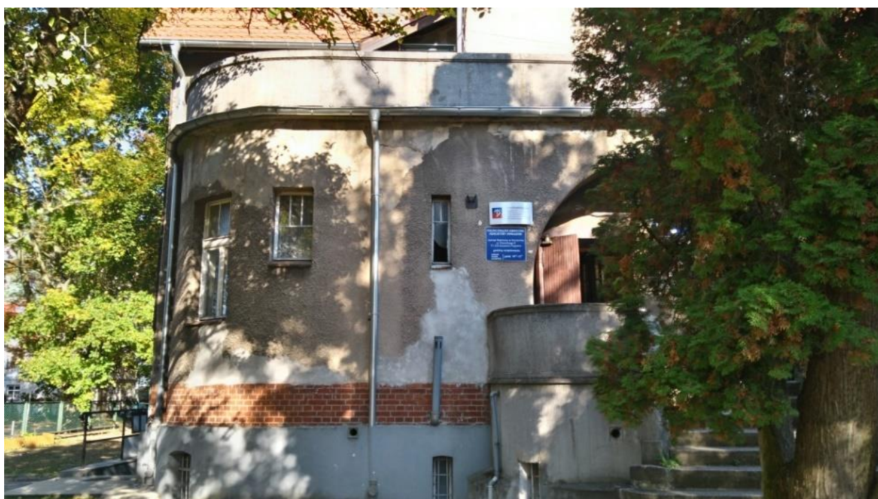
Widok elewacja frontowa – widoczna ściana zakrzywiona – strona lewa budynku
