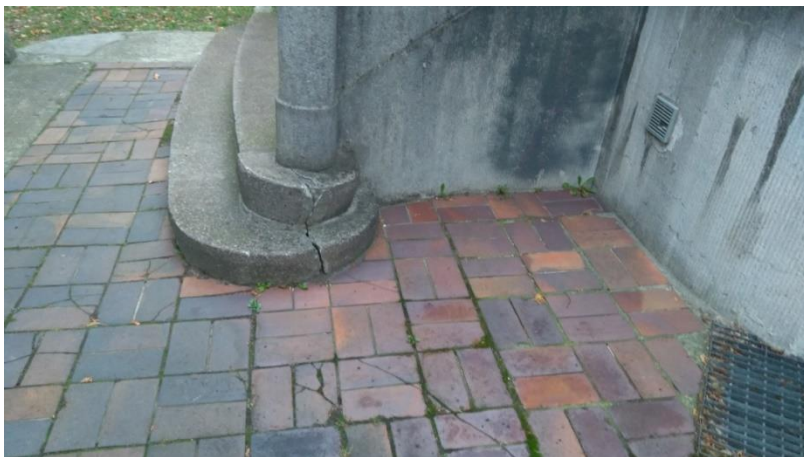
Fot.nr 4. Zachowane płytki klinkierowe do konserwacji – strefa boczna wejścia.
