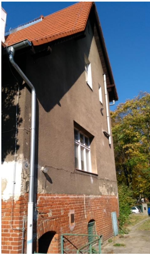
Fot.nr 11. Elewacja szczytowa pld –wsch – wejście do węzła c
