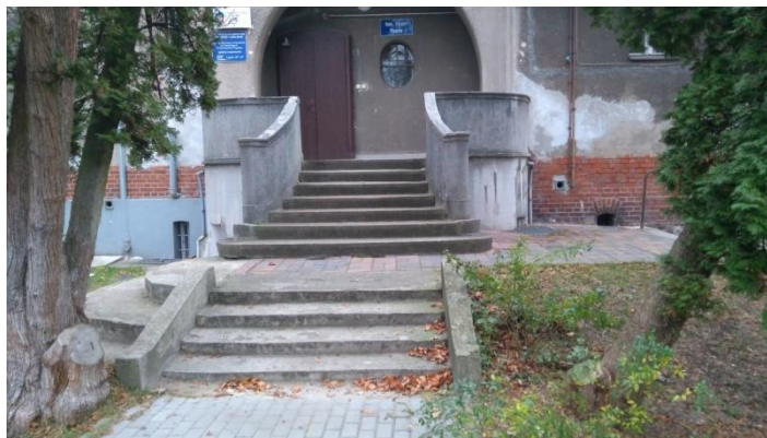
Fot.nr 1. Widok na wejście główne , balustrady , schody główne, podest z płytek klinkierowych przed elewacją wejścia.
