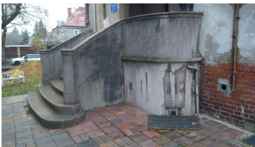
Fot.nr 5. Widok elewacji bocznej schodów głównych – strona prawa , widok na nawierzchnię z płytek klinkierowych oraz widok zniszczenia tynku elewacji wejścia, .
