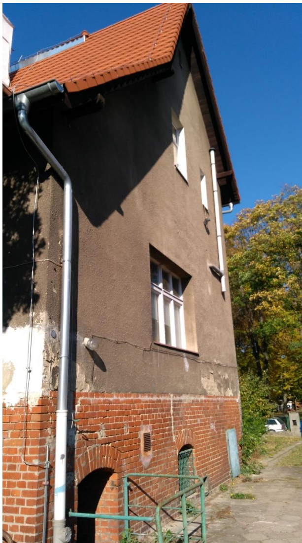
Elewacja szczytowa południowa
