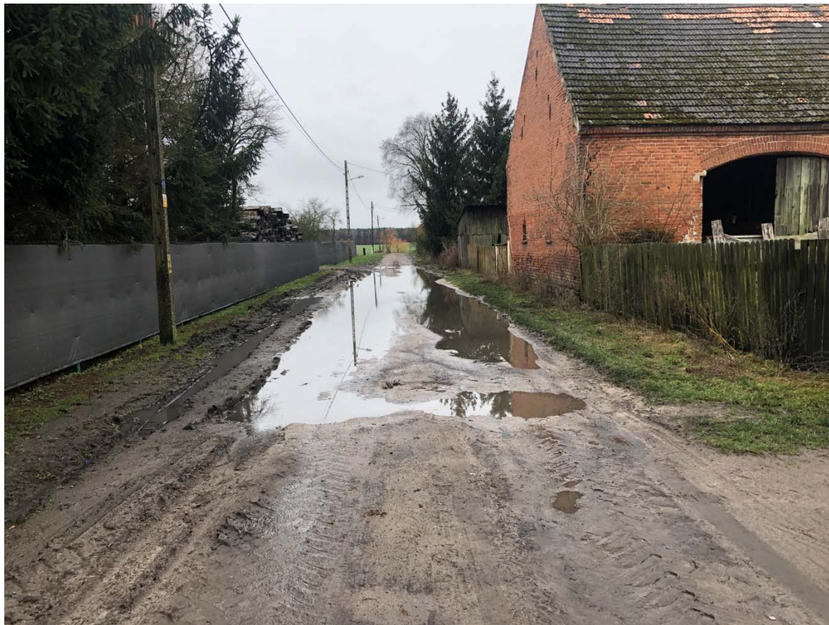
Zdjęcie 6. Widok na wysokości budynku nr 2 (zdjęcie w kierunku końca inwestycji, wymagane odwodnienie tego odcinka)
