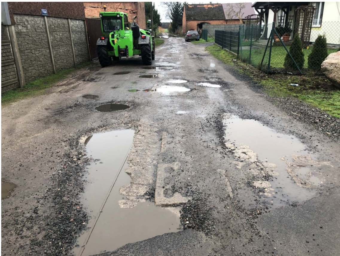
Zdjęcie 3. Widok początku ulicy Polnej (zdjęcie w głąb drogi gminnej)
