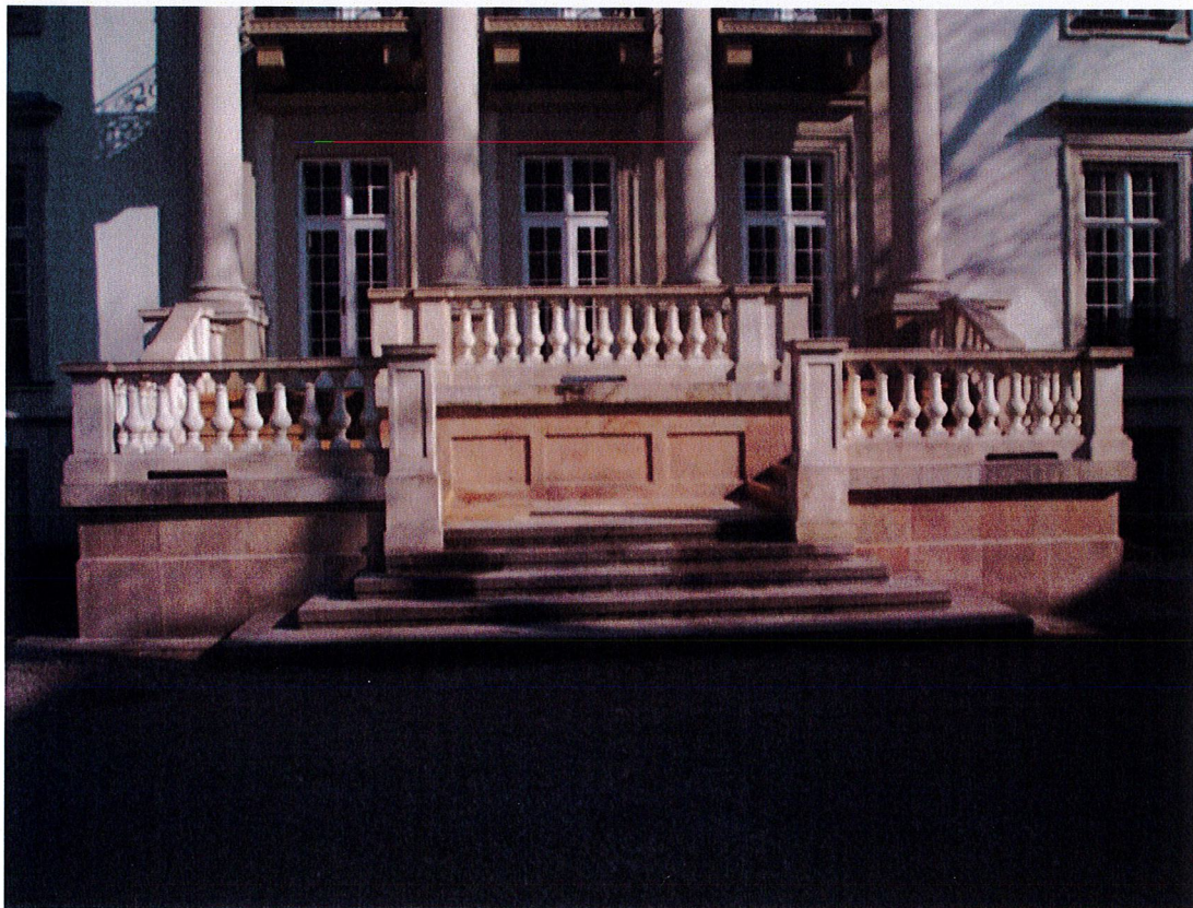
Fot.1,2 – taras – widok ogólny
