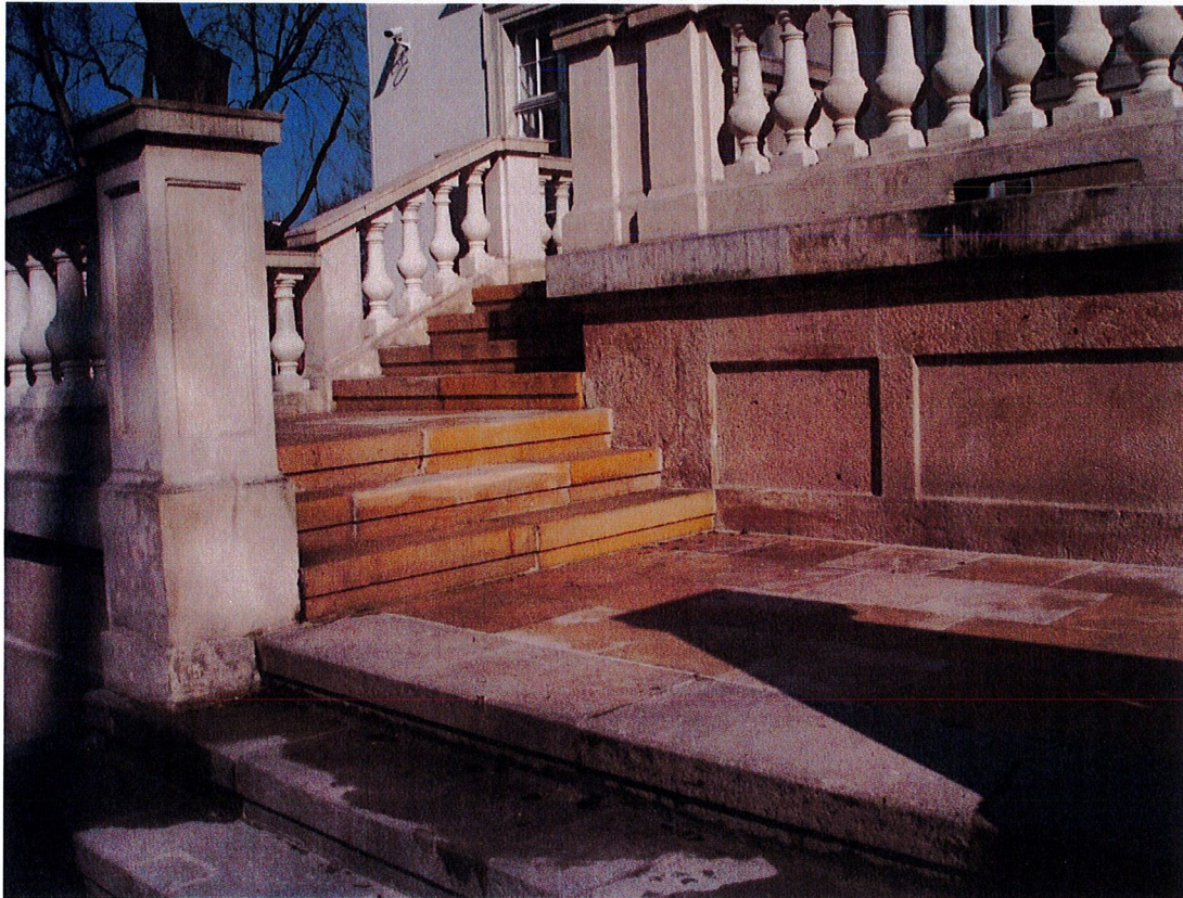
Fot.3,4 – biegi schodowe na tarasie – widok ogólny
