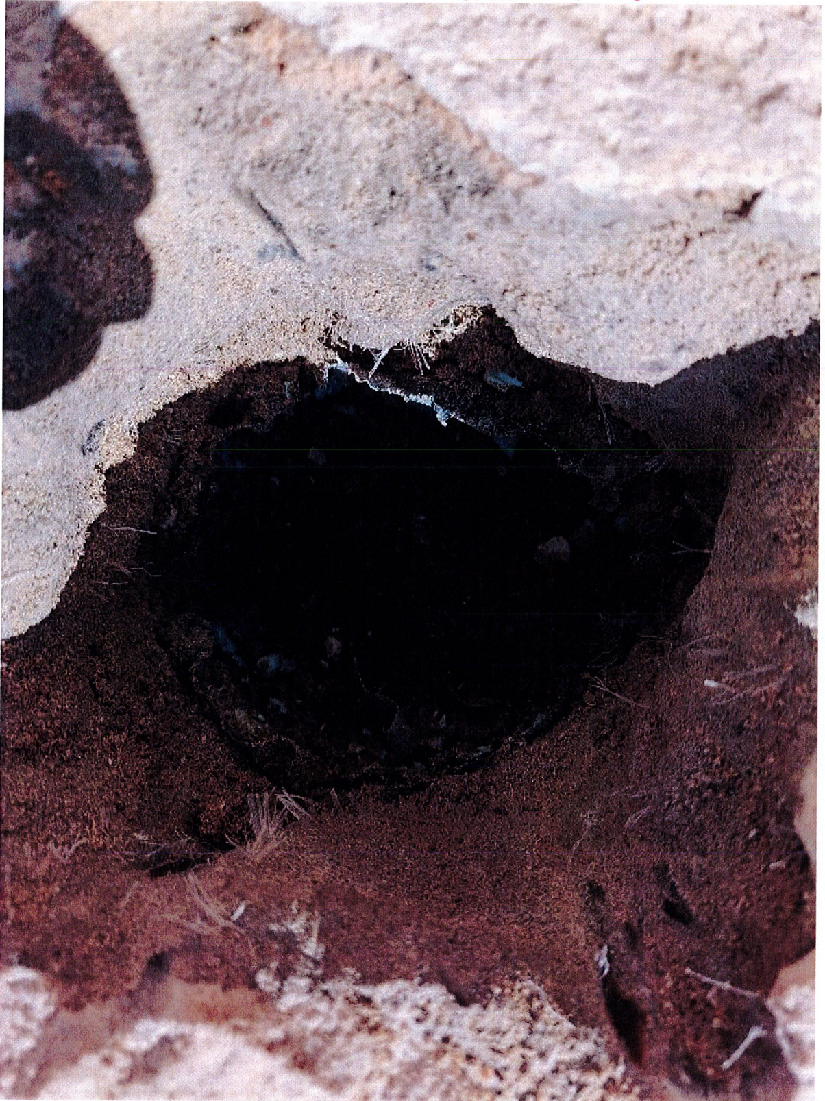
Fot.5 – Odkrywka wykonana w warstwach posadzkowych tarasu w celu ustalenia ich rodzaju oraz sprawdzenia szczelności warstwy izolacji. Od góry widoczny układ warstw: - płyty kamienne, folia budowlane ocieplenie z płyt styrodurewych, izolacja przeciwwilgociowa szlamowa, płyta żelbetowa tarasu
