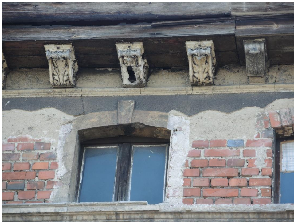
Fot.7: Widok na pęknięcia i ubytki w ścianie zewnętrznej
