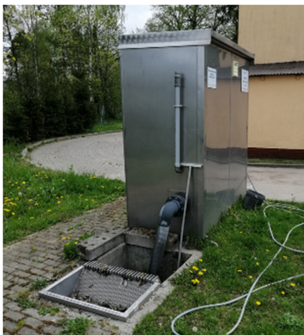
Fot.14. Stacja zlewna, krata ręczna
