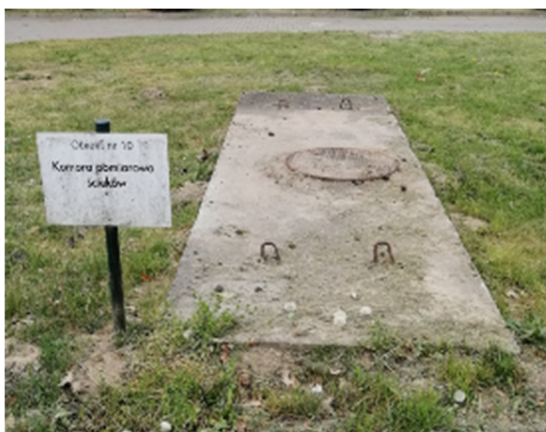
Fot.16, 17. Komora przepływomierza
