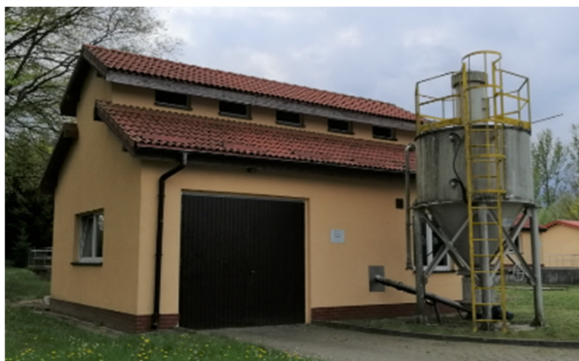
Fot.12. Silos wapna wraz z przenośnikiem
