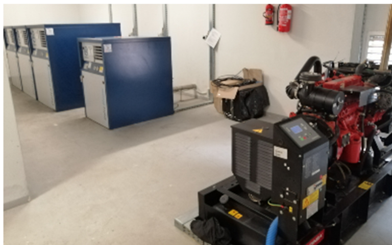
Fot.5. Budynek socjalno-techniczny – pomieszczenie dmuchaw i agregatu
