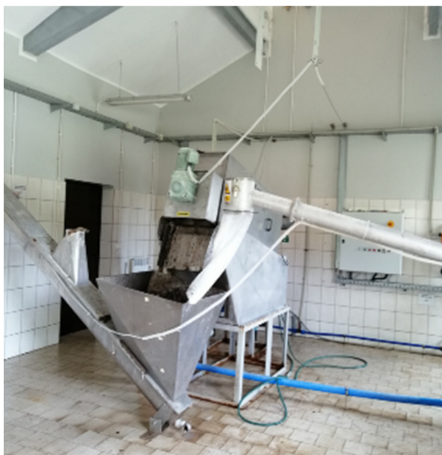
Fot.11. Budynek odwadniania osadu – instalacja odwadniania i higienizacji osadu
