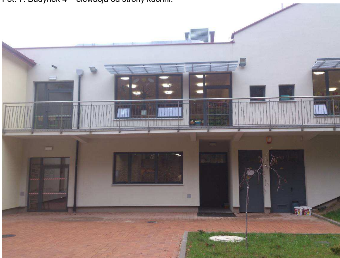
Fot. 7. Budynek 4 – elewacja od strony kuchni.
