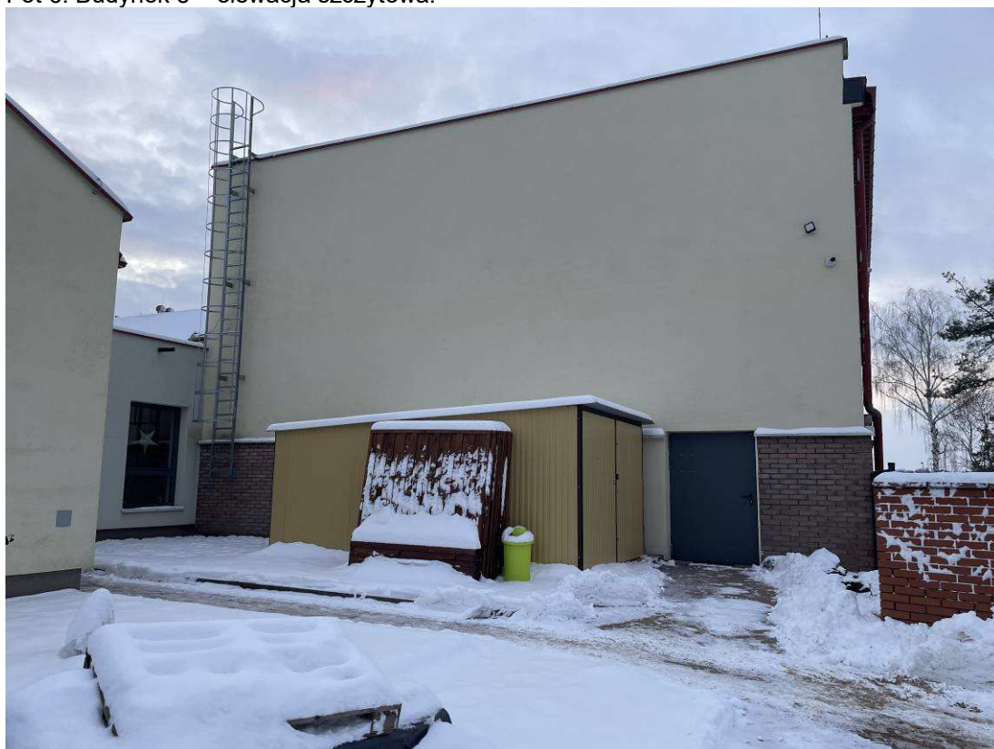
Fot 6. Budynek 3 – elewacja szczytowa.
