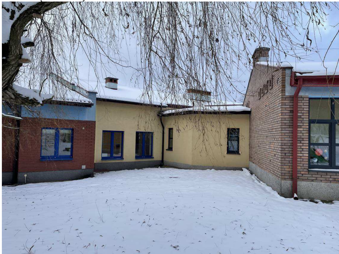
Fot 4. Połączenie budynków 1a i 2.
