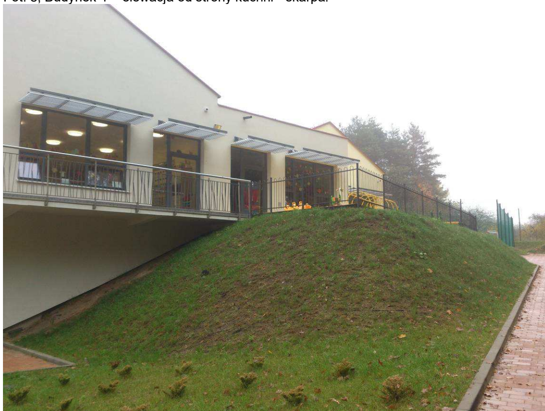
Fot. 8, Budynek 4 – elewacja od strony kuchni - skarpa.
