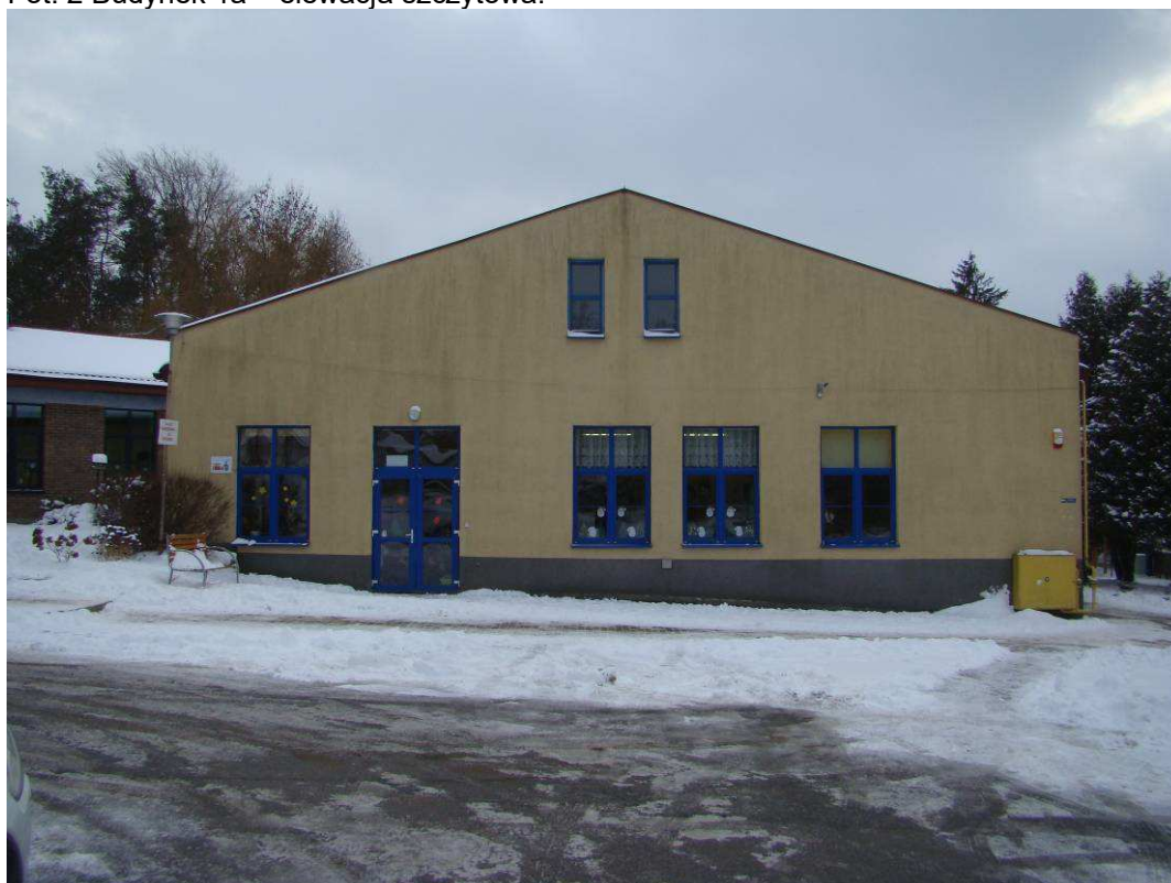
Fot. 2 Budynek 1a – elewacja szczytowa.
