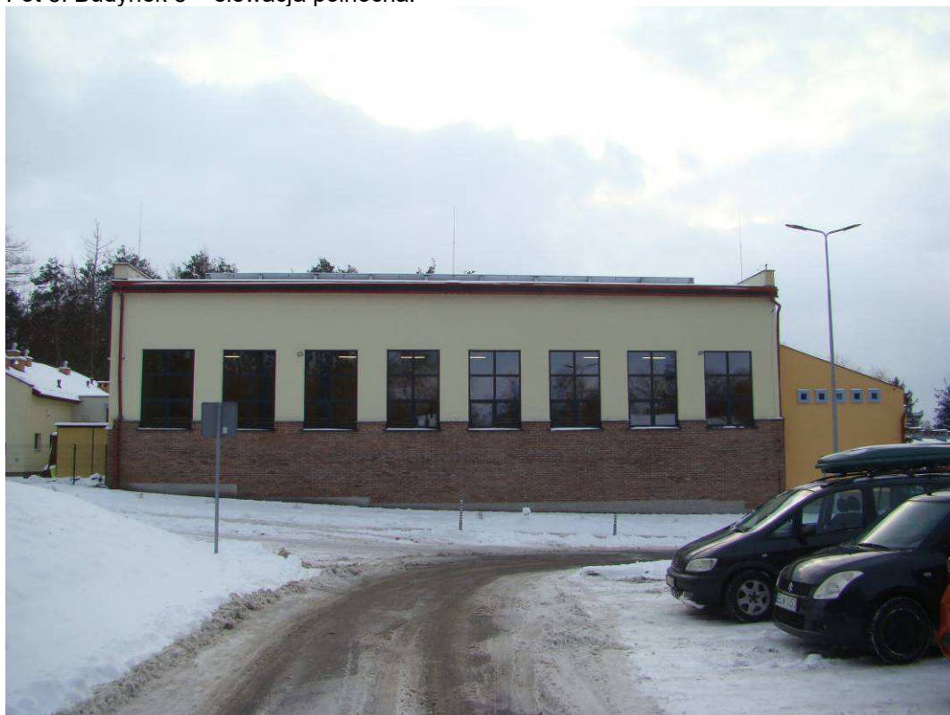
Fot 5. Budynek 3 – elewacja północna.
