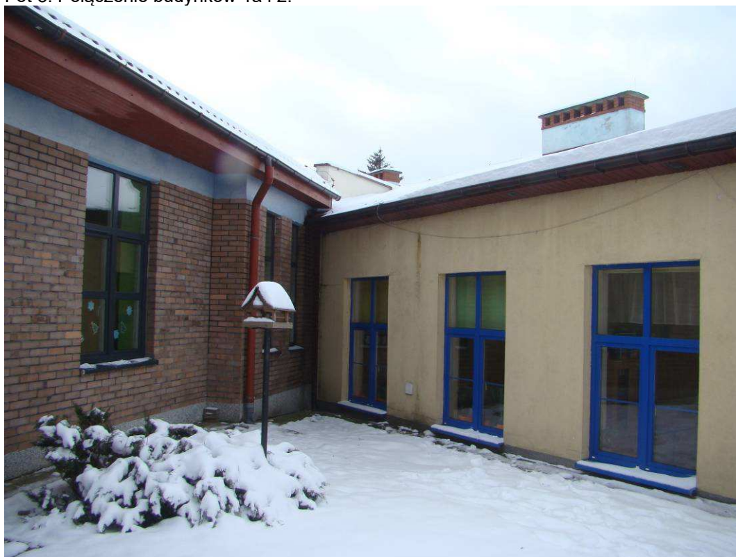
Fot 3. Połączenie budynków 1a i 2.
