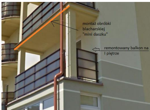
Przykładowy widok zamocowanej obróbki
