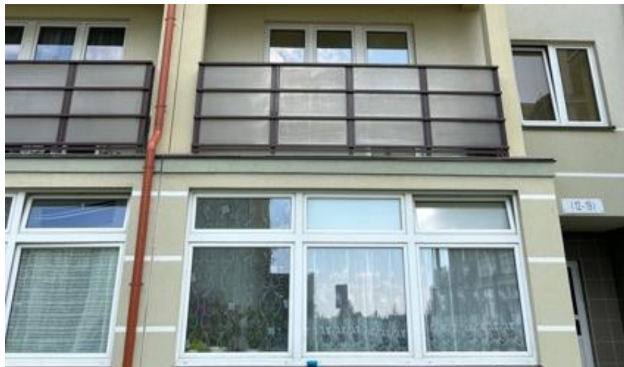
przykładowy widok wyremontowanego balkonu nad werandą
