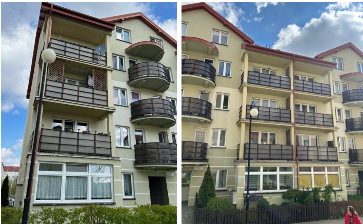
widok balkonów prostokątnych skrajnych i środkowych prostokątnych na II i III piętrze
