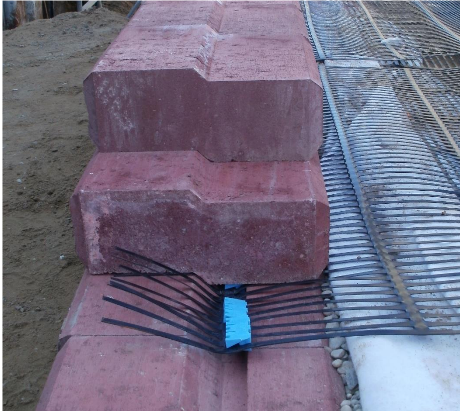
Rysunek 3 Mocowanie georusztu i łącznika typu B
