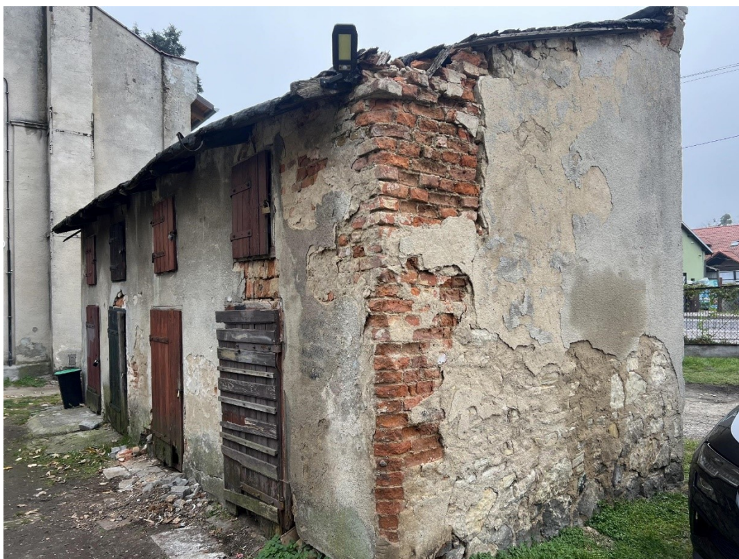
Zdjęcie nr 2 – Elewacja północna i zachodnia – widoczne uszkodzenia dachu i ścian zewnętrznych
