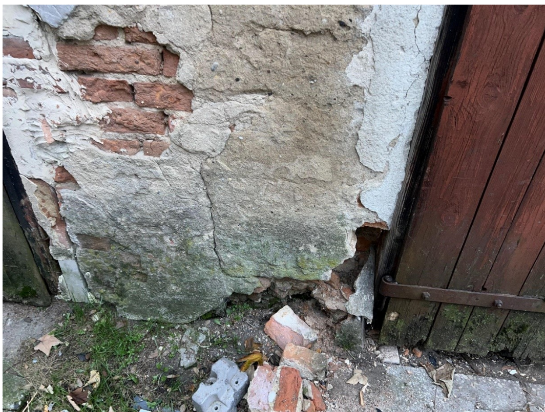
Zdjęcie nr 4 – Uszkodzenia i zawilgocenia ścian konstrukcyjnych
