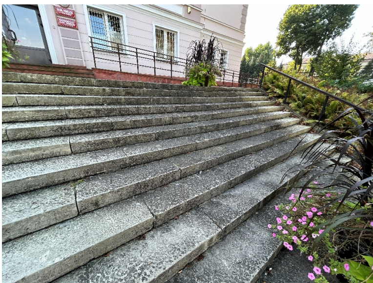
Zdjęcie. Widoczne nierówności poszczególnych stopni.
