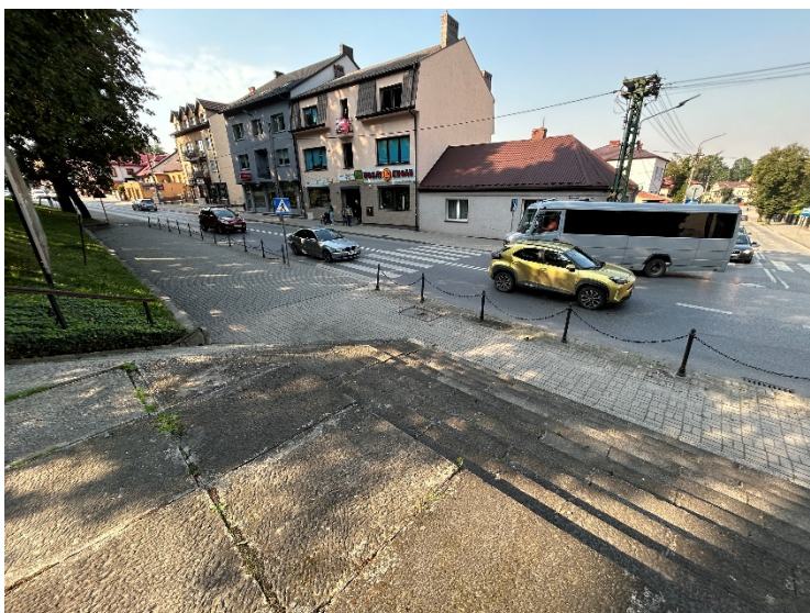
Zdjęcie. Widoczne powiększone spoiny między płytami na skutek przemieszczenia płyt.
