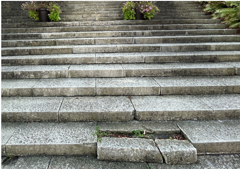
Zdjęcie. Deformacja stopni i uszkodzenia elementów kamiennych.
