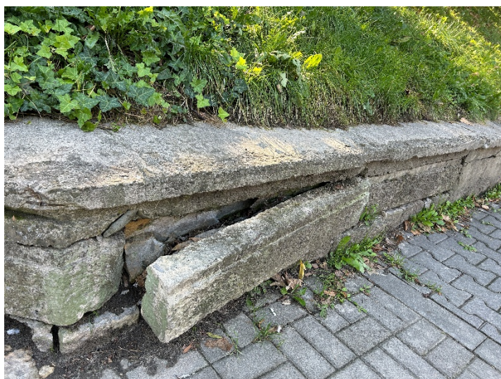
Zdjęcie. Odspojony fragment okładziny kamiennej murka
