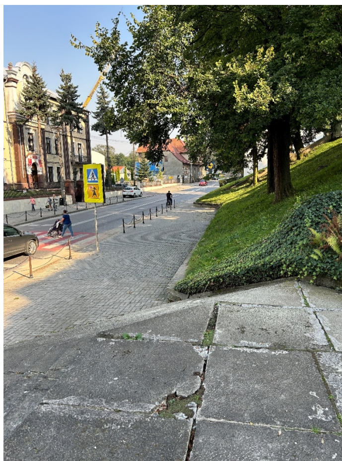
Zdjęcie. Uszkodzenia płyt spocznika
