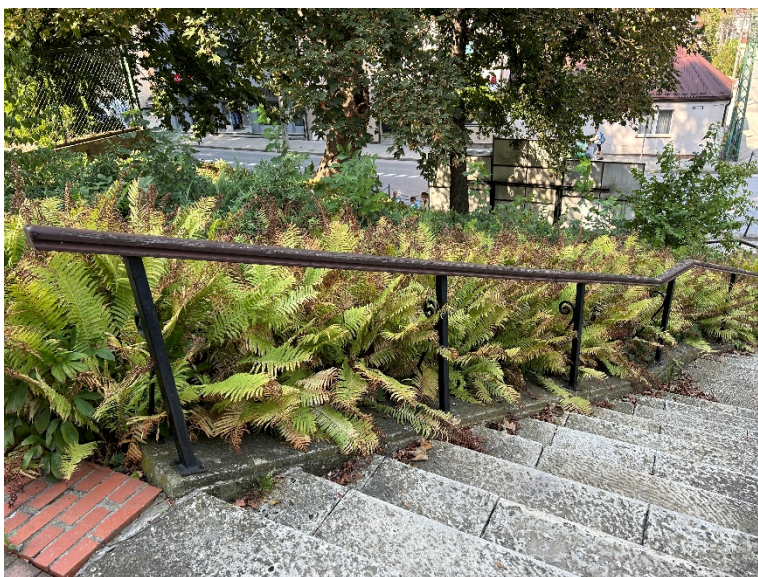
Zdjęcie. Balustrada z widocznymi śladami korozji.
