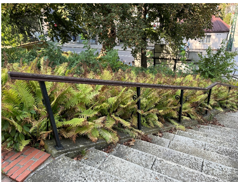
Zdjęcie. Balustrada z widocznymi śladami korozji.
