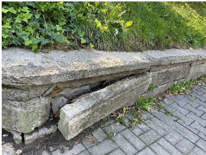
Zdjęcie. Odspojony fragment okładziny kamiennej murka
