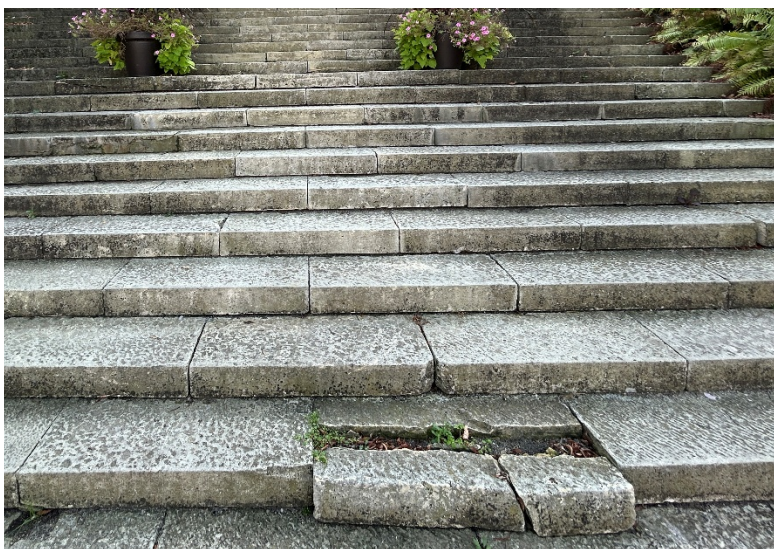
Zdjęcie. Deformacja stopni i uszkodzenia elementów kamiennych.
