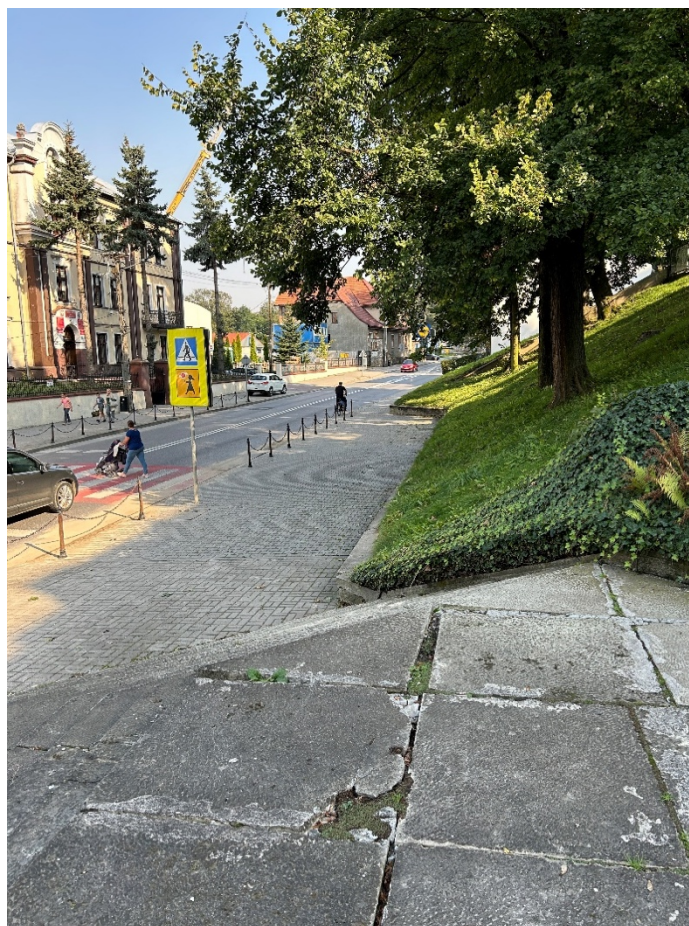
Zdjęcie. Uszkodzenia płyt spocznika
