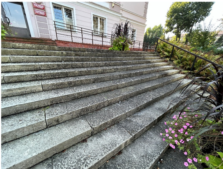
Zdjęcie. Widoczne nierówności poszczególnych stopni.
