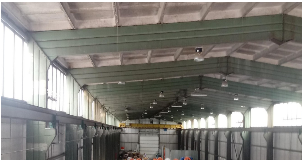
Ilustracja 5: Rygiel skrzynkowy z widocznymi płytami korytkowymi
