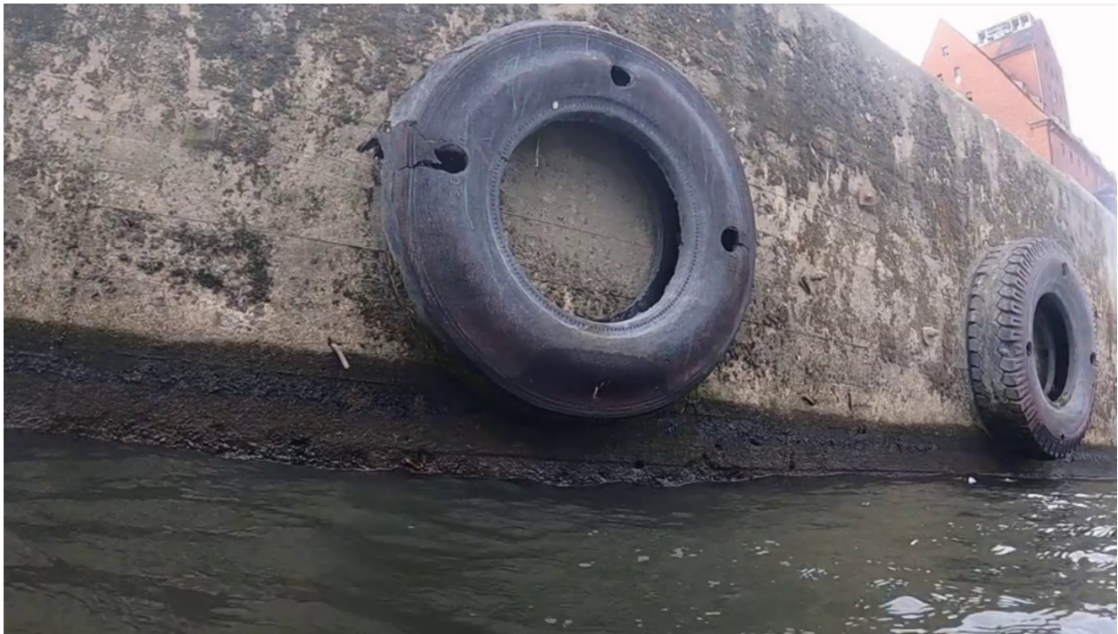
Okolice 25 mb – dolna krawędź oczepu w stanie dobrym – brak znaczących ubytków. Lokalne wżery w betonie do 3 cm
