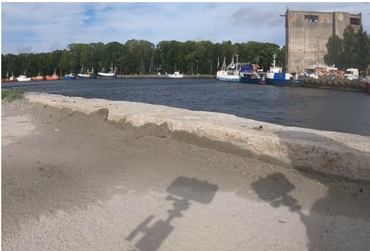
Obniżenie nawierzchni za oczepem o około 15 cm.
