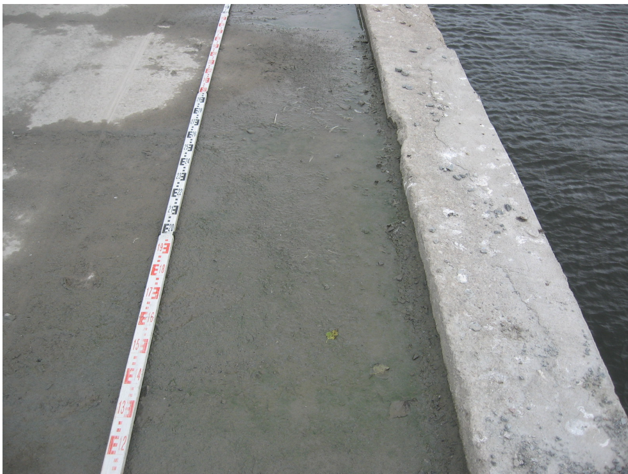
Okolice 35mb – widoczne naprawy oczepu, obniżenie nawierzchni o około 15 cm
