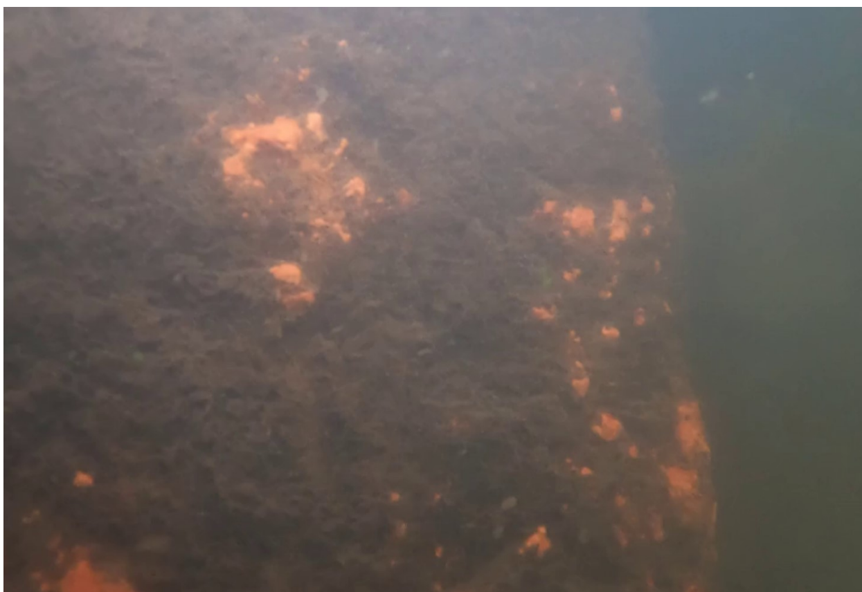
Korozja powierzchniowa ścianki szczelnej - „brzuch” profilu larssen
