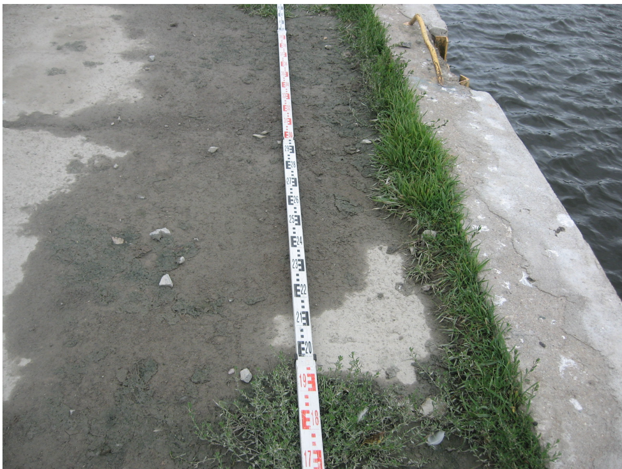
Okolice 64mb – widoczne naprawy oczezu wokół drabinki, obniżenie nawierzchni o około 8-10 cm
