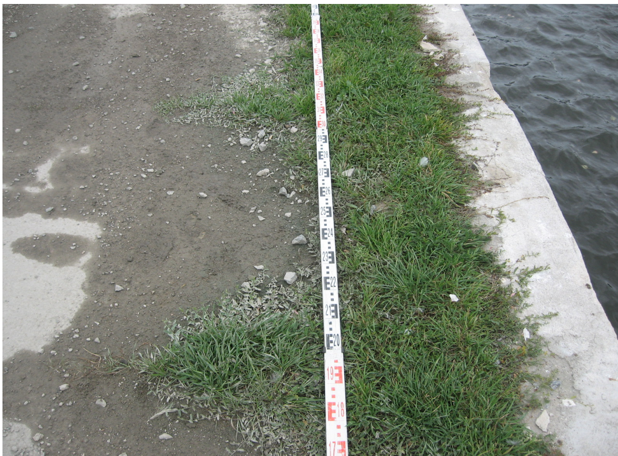
Okolice 85mb widoczne liniowe naprawy oczezu, obniżenie nawierzchni o około 5 cm porośnięte trawą
