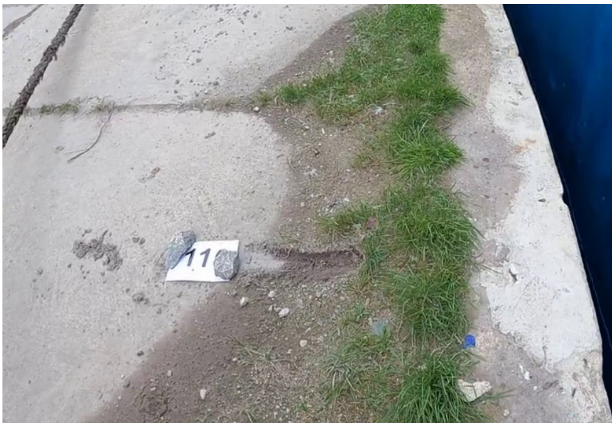
Okolice 110mb widoczne liniowe naprawy oczepu, obniżenie nawierzchni o około 5 cm porośnięte trawą
