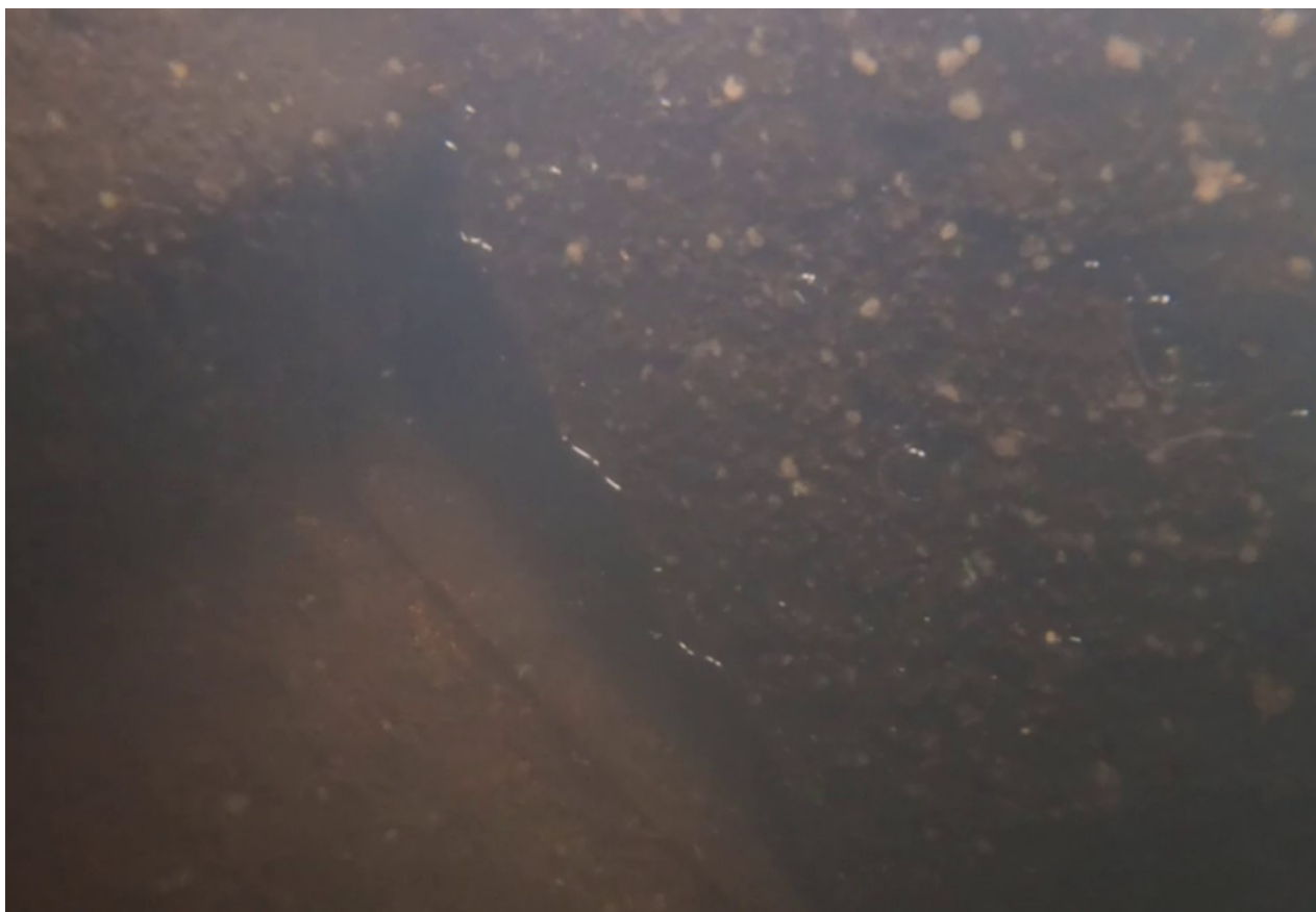
Połączenie ścianki szczelnej z oczepem – w stanie dobrym
