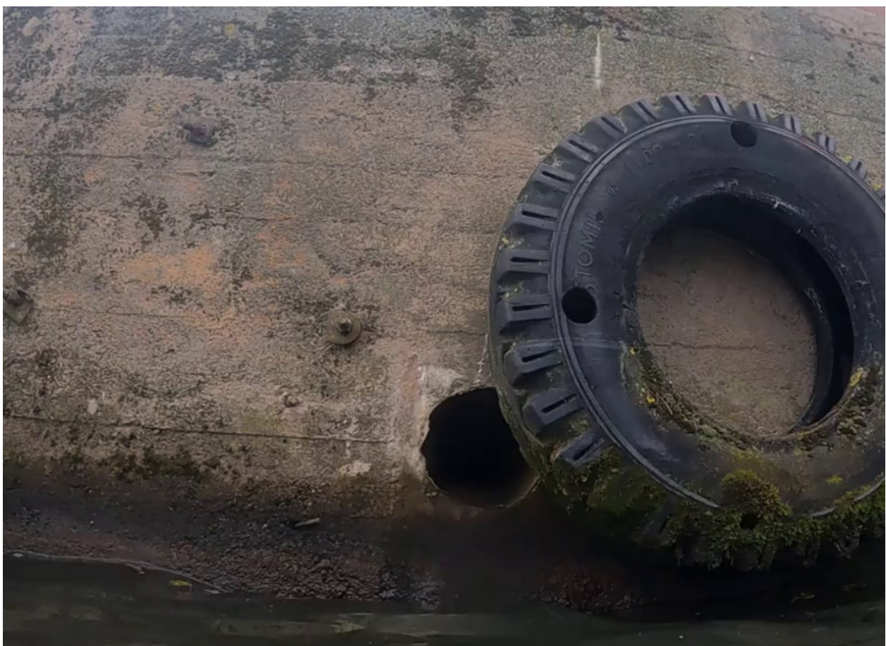
Okolice 85 mb - Wylot Ø 200 mm na wysokości 140cm poniżej korony oczepu.
