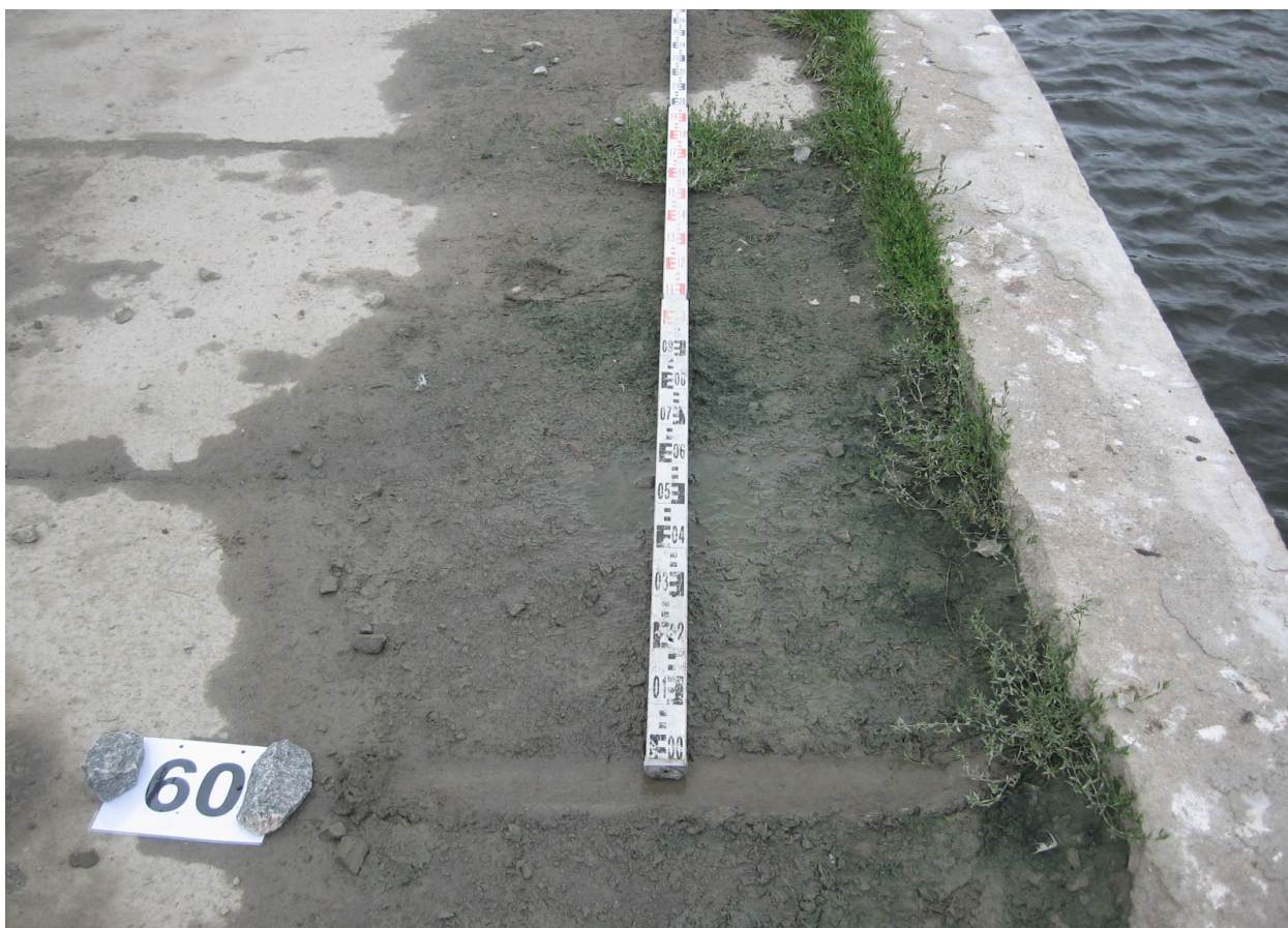
Okolice 60mb – widoczne naprawy oczepu, obniżenie nawierzchni o około 10-12 cm
