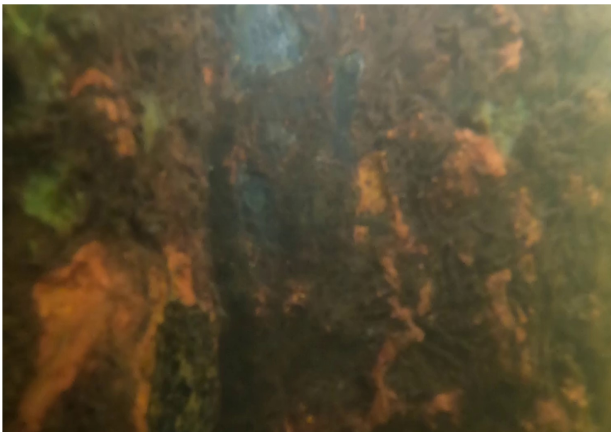
Korozja ścianki szczelnej - skrzydełko boczne profilu larssen - miejsce oczyszczenia z rdzy do badania
