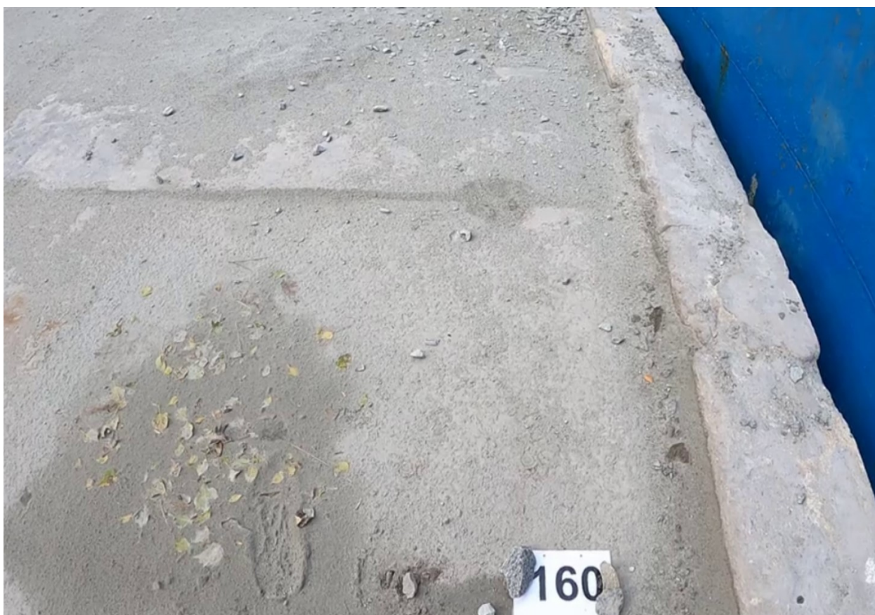
Okolice 160mb widoczne naprawy oczepu, drobne wykruszenia napraw, obniżenie nawierzchni o około 5 cm
