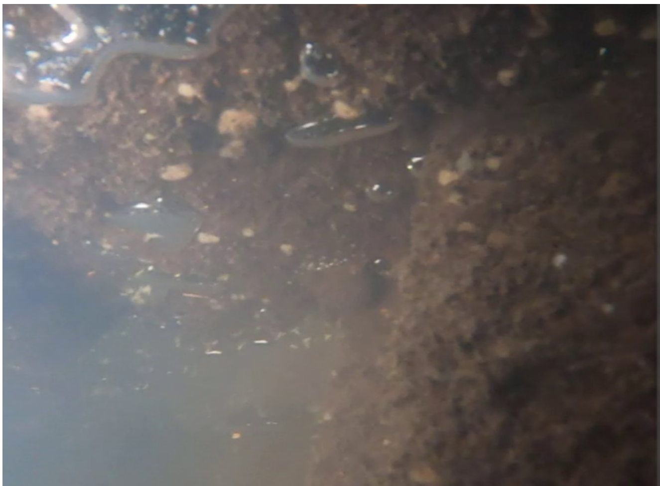
Połączenie ścianki szczelnej z oczepem – w stanie dobrym, brak ubytków i widocznego zbrojenia
