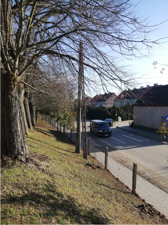
Ogrodzenie od strony ul. Wojska Polskiego
